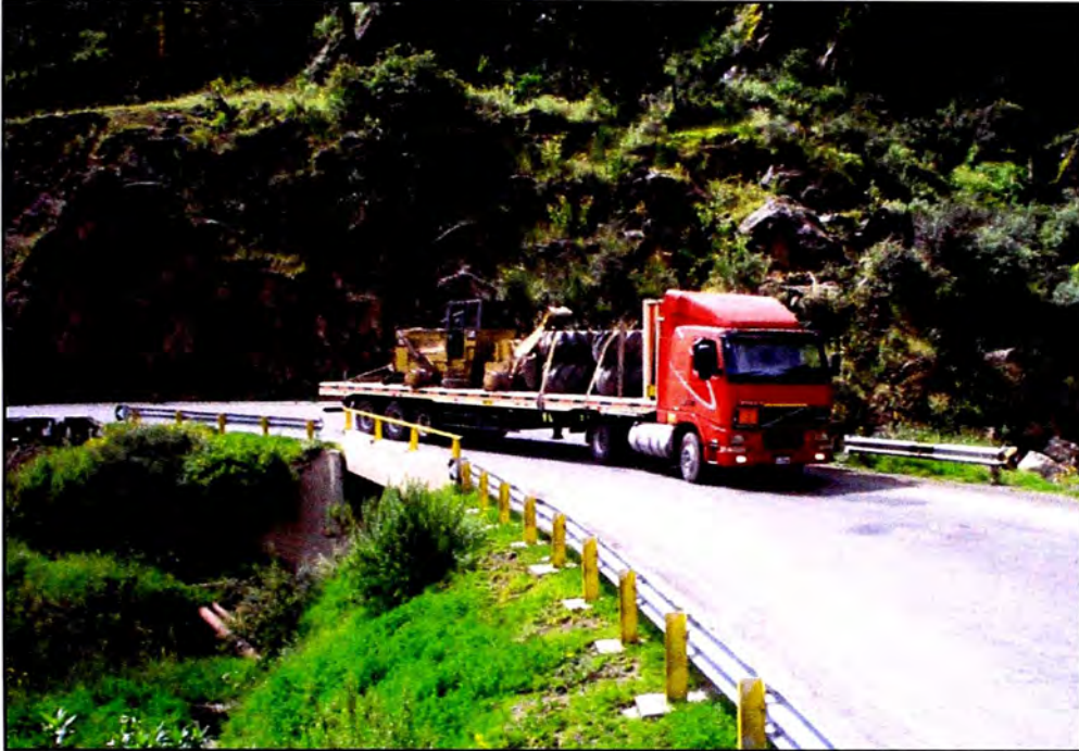
Foto05: Cruce de T2S3 sobre puente existente en sector 15 Km 123+760, se observa la necesidad de invadir el carril contrario para poder girar.
