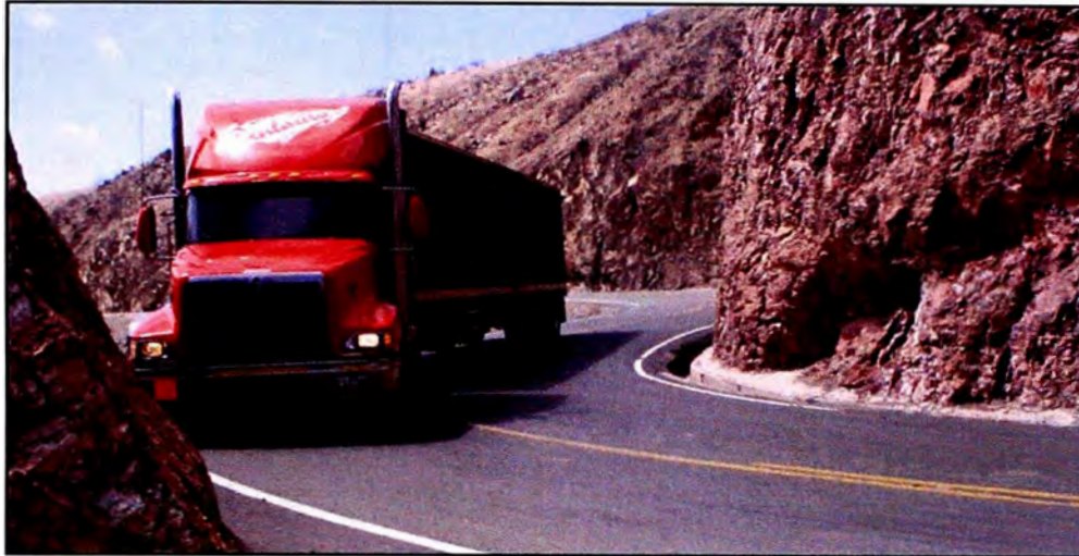
Foto03: Giro de T3S2 sobre una curva de radio R=20.7\text{m} en el sector 08 Km 26+630, el radio existente es menor al mínimo exigido por la norma DG. Se observa la necesidad del vehículo de invadir el carril contrario, aumentando el riesgo de choque frontal.
