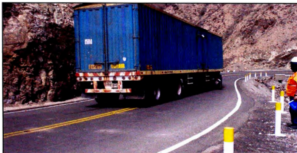
Foto04: Giro del mismo vehículo de la foto03 terminando de pasar la curva del km 26+630. Se observa que sigue invadiendo el carril contrario ya que la curva tiene un radio muy bajo y no le permite mantener su carril. Esta circunstancia es muy peligrosa y conlleva a posibles choques frontales o despistes. La combinación de curva y contracurva no posee la longitud de transición adecuada, es decir debe dotarse de espirales con la longitud reglamentaria.
