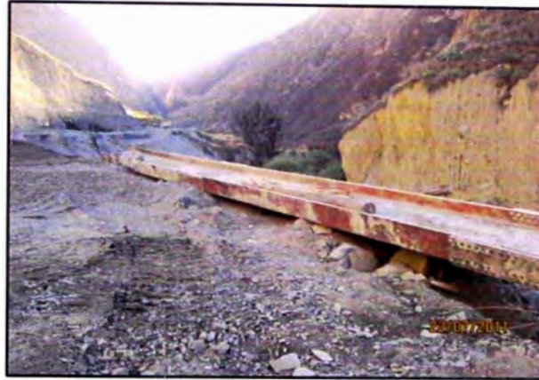
Figura 3.3 Viga metálica de puente demolido utilizado en la conformación del falso puente
