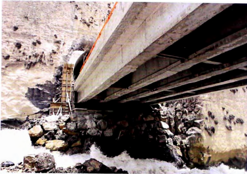
Vista de las vigas diafragma y las vigas postensadas
