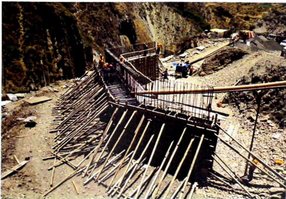
Etapa de vaciado de pantalla del estribo derecho Puente Viroc II
