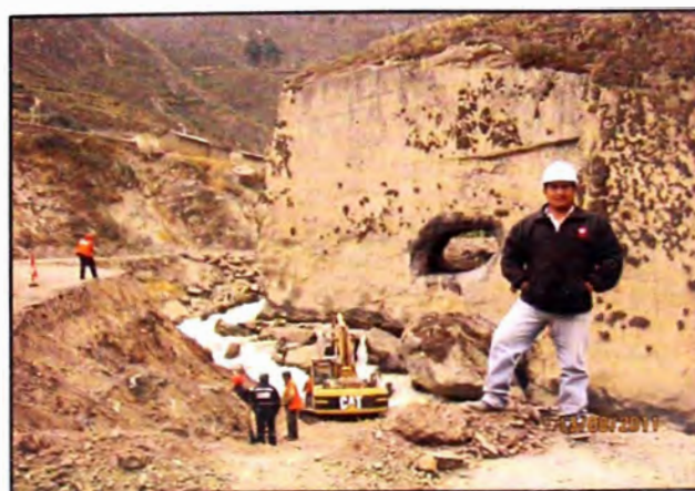
Figura 3.1 Inicio de la etapa de excavación en estribo derecho
