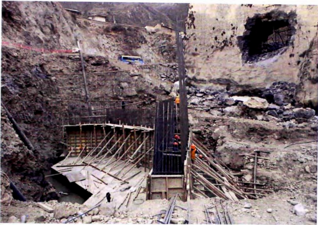
Trabajos de encofrado de pantalla en el puente Viroc II (Estribo derecho)
