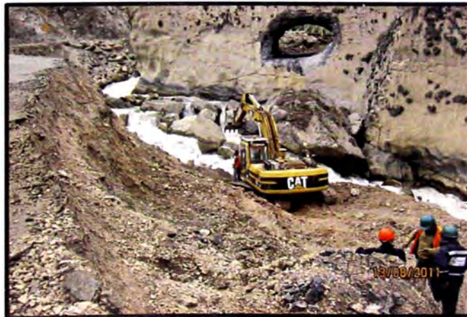
Figura 2.1 Excavación de calicata
