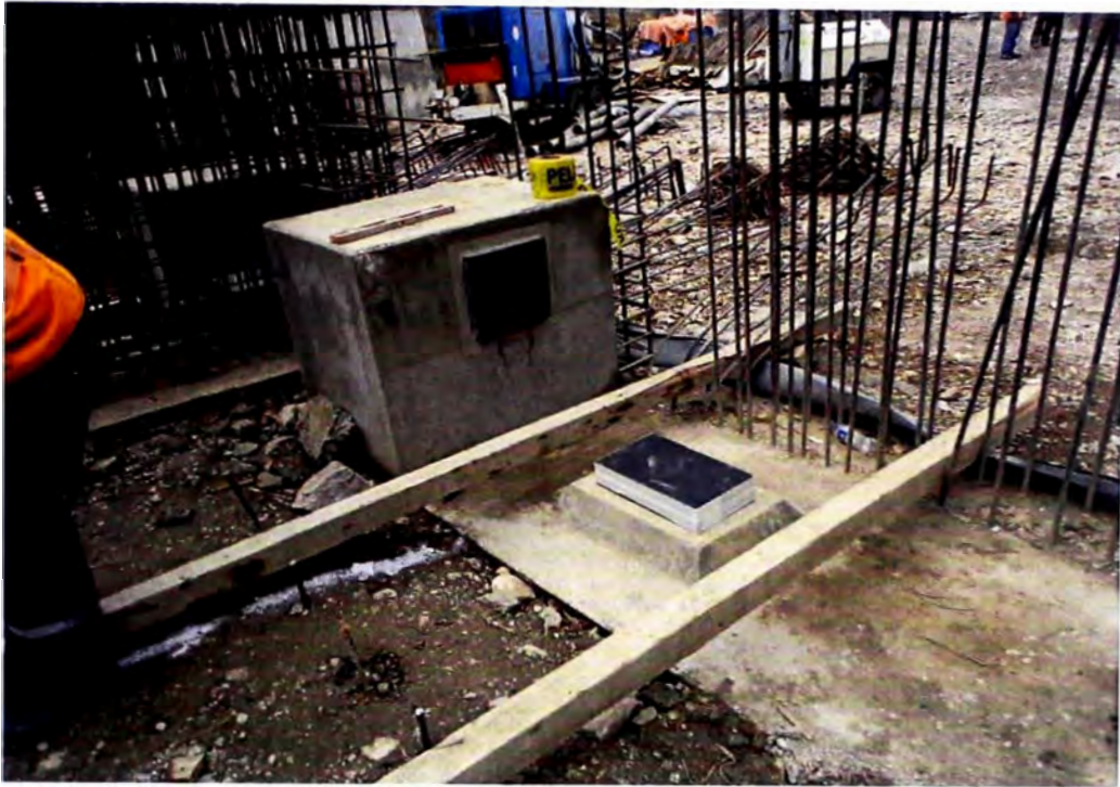
Detalle del apoyo y del tope sísmico
