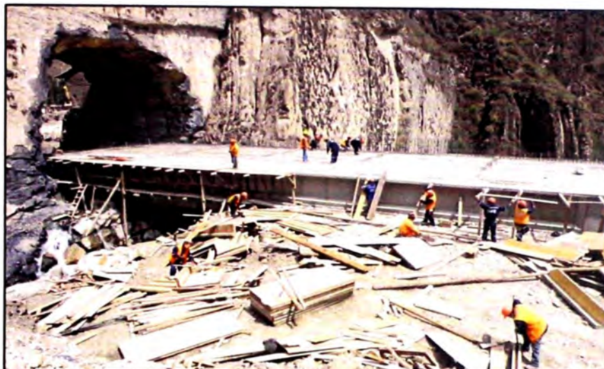
Figura 3.6 Encofrado de losa
