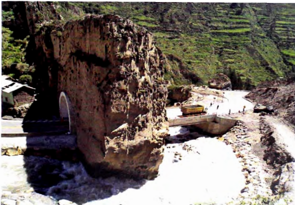
Finalización de trabajos en el sector adyacente al puente Viroc II (Enrocado de protección y señalización)
