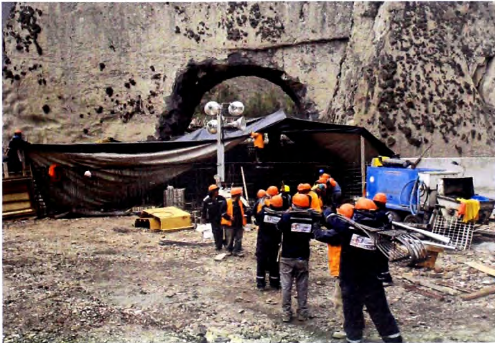
Transporte del acero de las vigas a postensar
