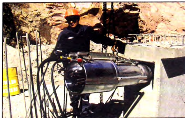
Figura 3.5 Proceso de tesado de tendones
