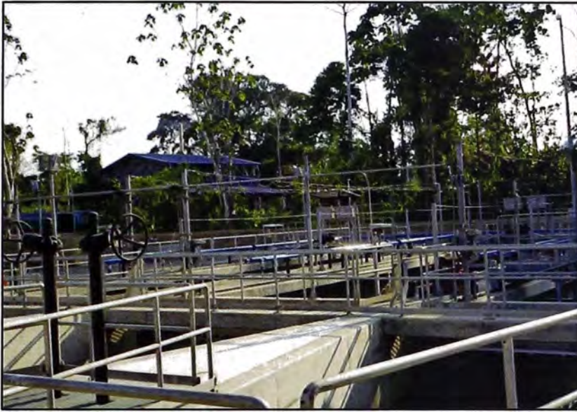
FIGURA 3:“Compuerta de ingreso de drenaje”.
