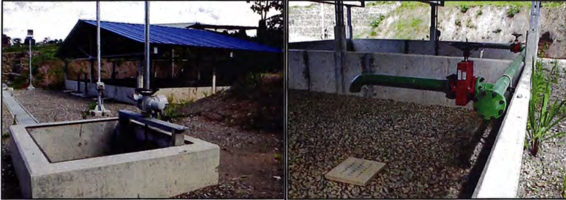
FIGURA 11: “Área y fosa de secado de lodos”.
