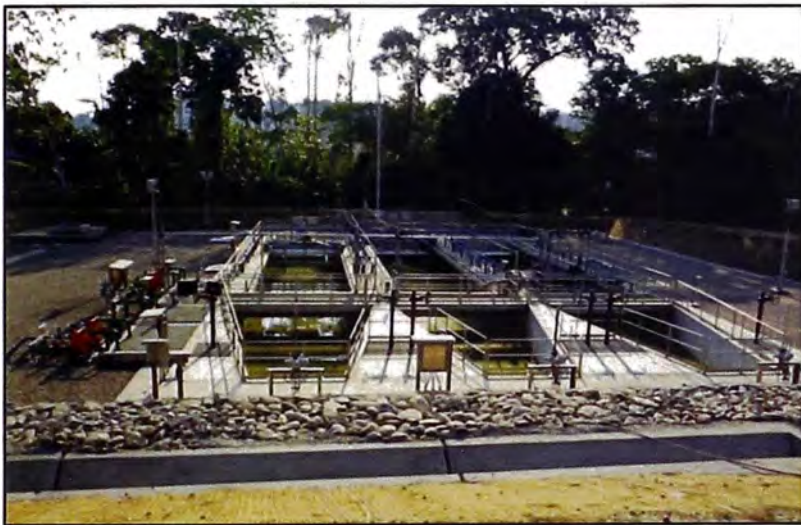
FIGURA 1: “Vista frontal de pileta API”.
