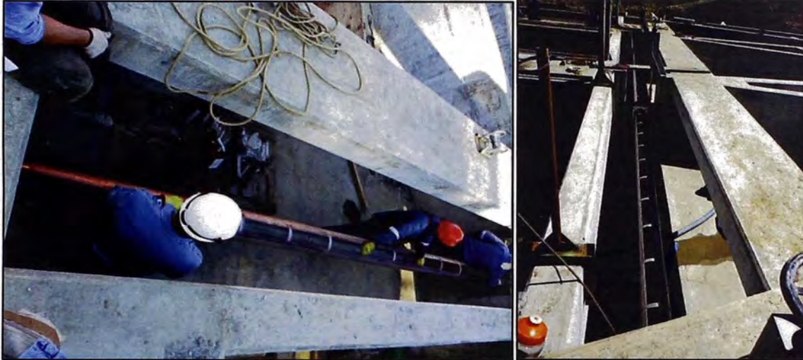
FIGURA 5: "Instalación del tubo ranurado".
