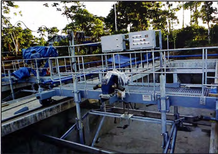
FIGURA 7: “Instalación del puente Barredor”.
