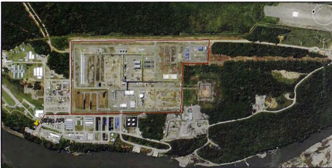
FIGURA 15: “Vista general de la planta de gas Malvinas”. Fuente: google earth
