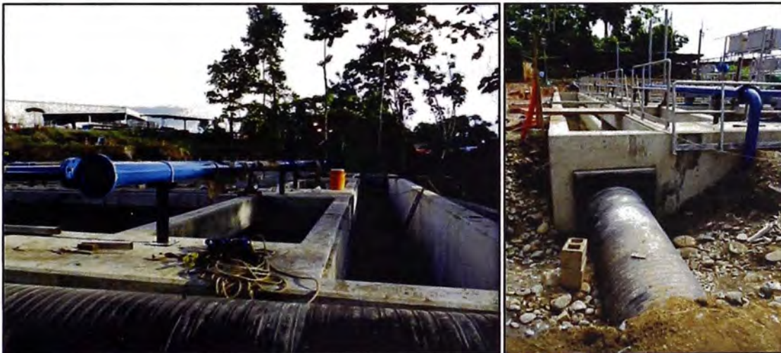
FIGURA 8: “Canal de reinyección de Pileta al río”.
