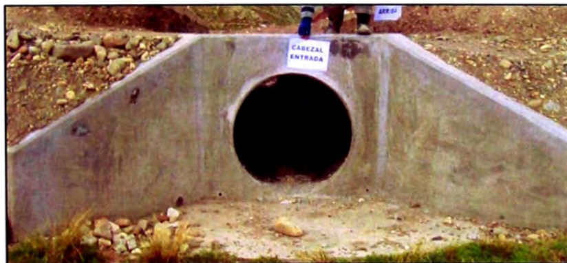
Figura 2.6 Protección de enrocado a la entrada de la alcantarilla
