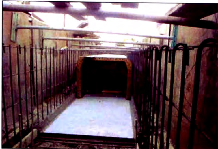
(Fuente: Internet) Figura 4.23 Vaciado parcial del concreto
