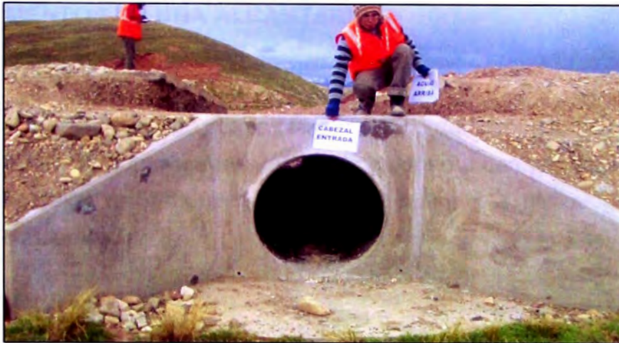
(Fuente: Elaboración Propia, 2010) Figura 2.1 Alcantarilla de concreto de sección circular
