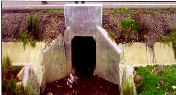
(Fuente: Elaboración propia, 2010) Figura 2.5 Entrada tipo alero inclinado
