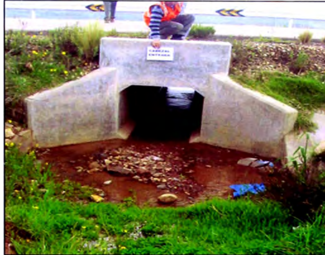
(Fuente: Elaboración Propia, 2010) Figura 4.3 Vista aguas arriba de la alcantarilla 77+780
