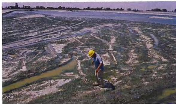
Figura N°31: Dificultad para la colocación de Geomembrana
