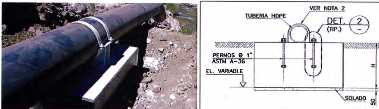
Figura N°23: Instalación de Pernos de anclaje
