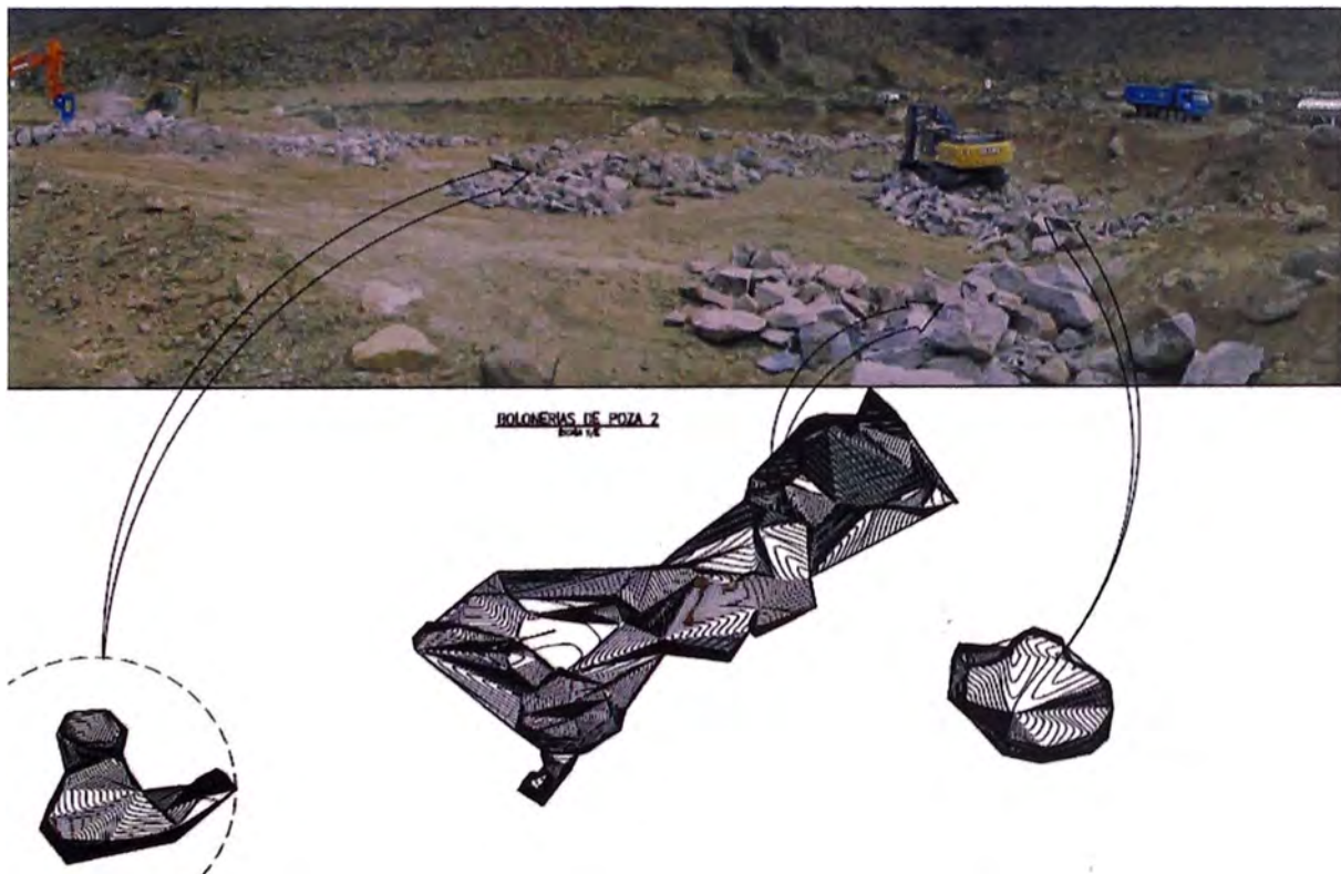
Figura N°24: Bolonería encontrada durante las excavaciones de las pozas
