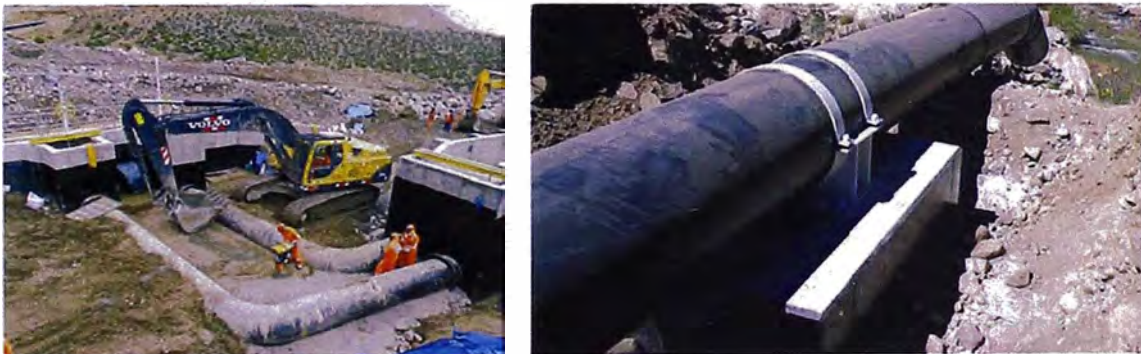
Figura N°34: Vistas del relleno y Anclajes químico
