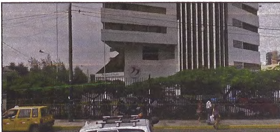
Figura 1.1. Banco de la Nación que cuenta con 5 niveles de sótanos sostenidos por calzaduras
