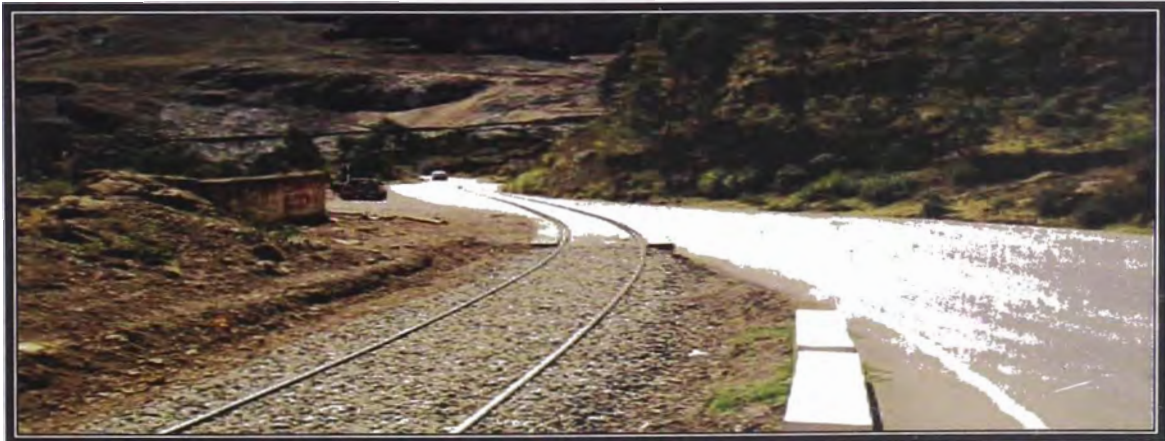
Figura N°5: Vía ferroviaria y la carretera central.
