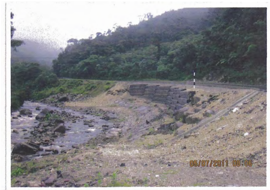
- Figura N° 1.6 Carretera tramo II margen derecha del río Utcubamba, Km 263.
