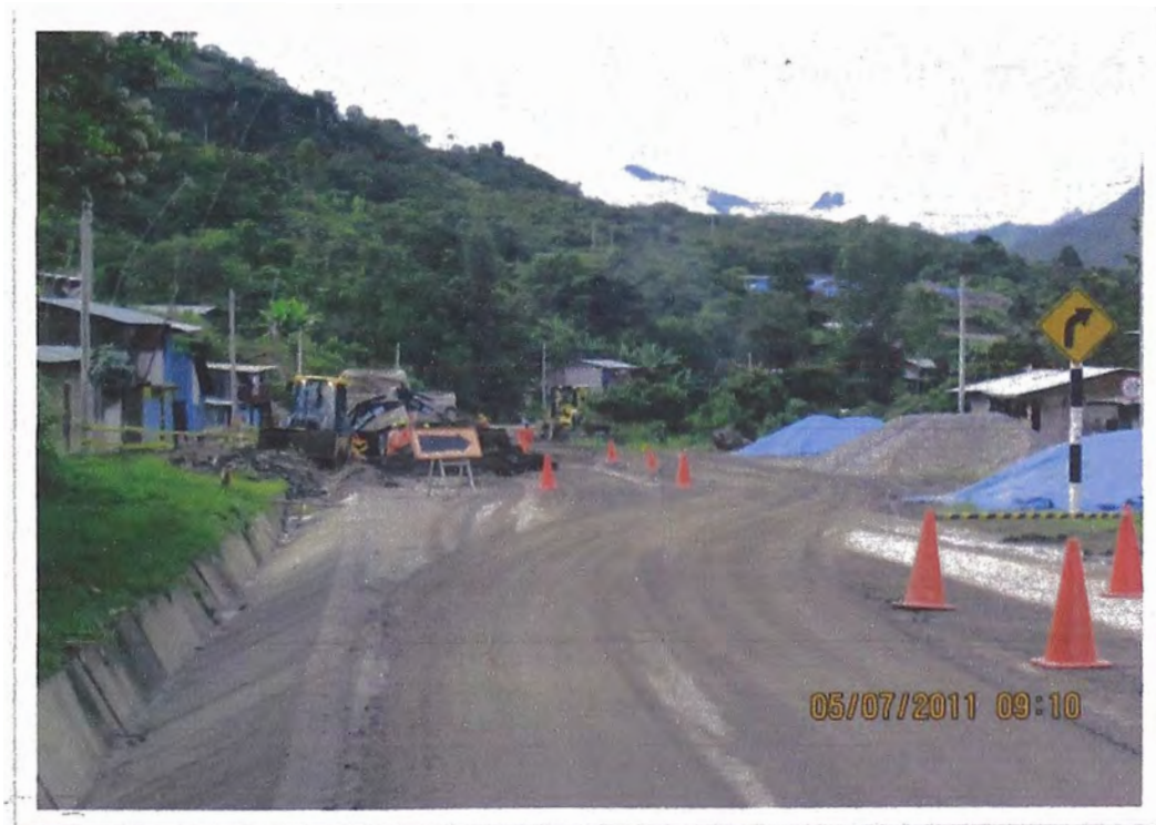
Figura N° 2.5 Mantenimiento de la carretera, Km 323.
