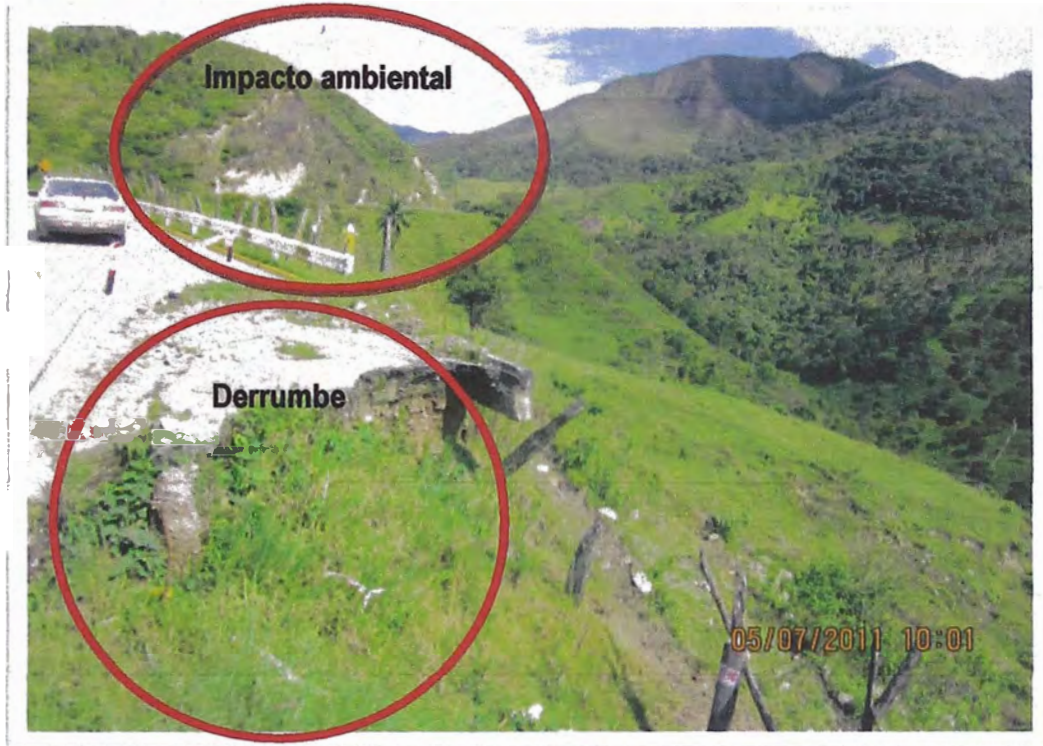
Figura N° 2.4 Carretera interrumpida por derrumbe, impacto ambiental, Km 318.
