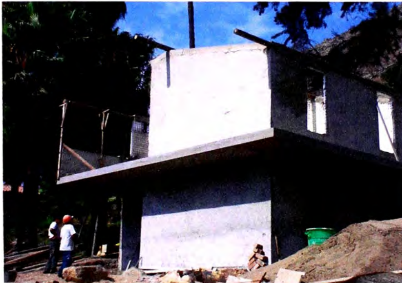
CONSTRUCCION DE CASAS DE CAMPO CHOSICA
