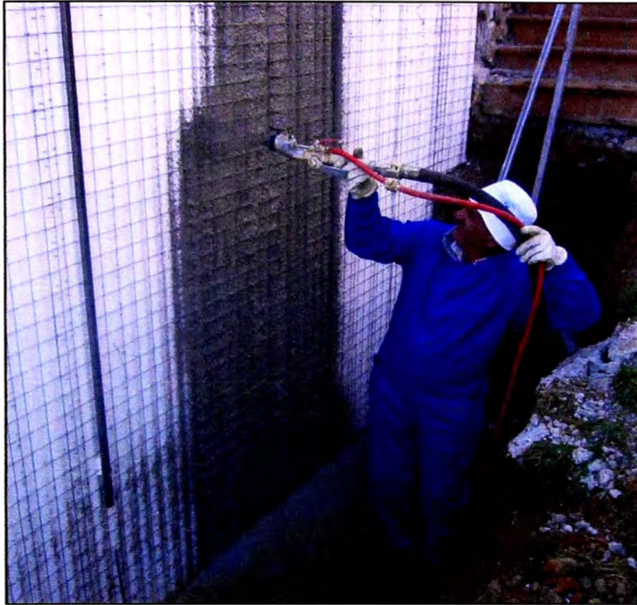
PROYECCION CONTINUA DE MORTERO ESTRUCTURAL
