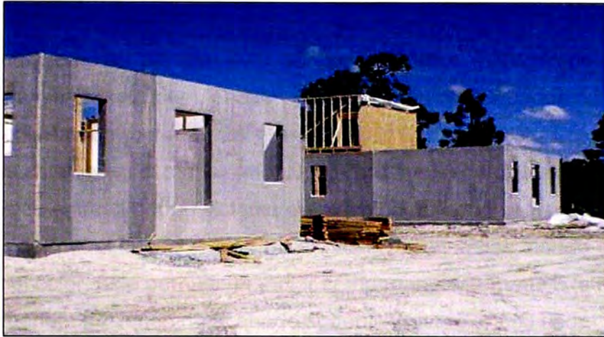
Figura N° 1.14.-Vivienda usando el sistema constructivo Llasta
