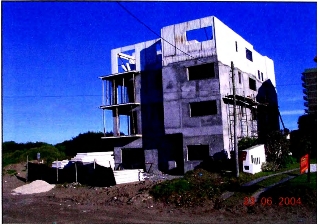
CONSTRUCCION DE HOTEL DE 4 NIVELES – ARGENTINA
