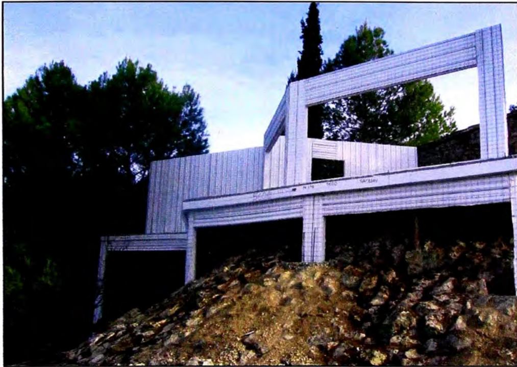
CONSTRUCCION DE VIVIENDA EN TERRENO INCLINADO
