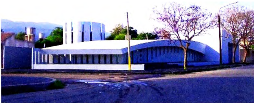
CONSTRUCCION CONCLUIDA DE HOSPITAL-ARGENTINA
