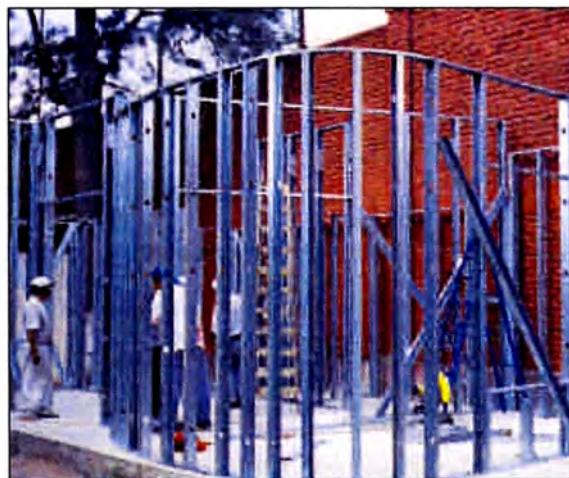
Figura N° 1. 7 .-Estructura de acero galvanizado del sistema Constructivo en seco Eternit
