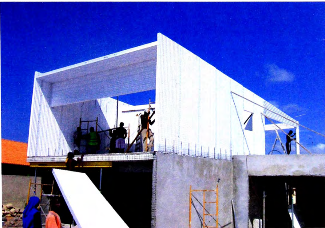
CONSTRUCCION DE VIVIENDA DE DOS NIVELES
