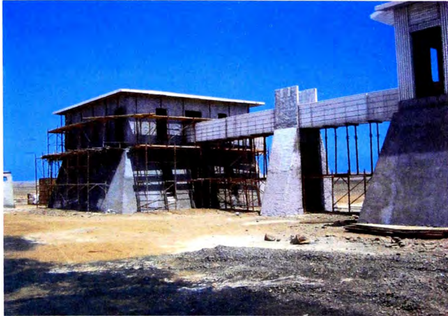
CONSTRUCCION INTEGRAL CON EL SISTEMA EMMEDUE
