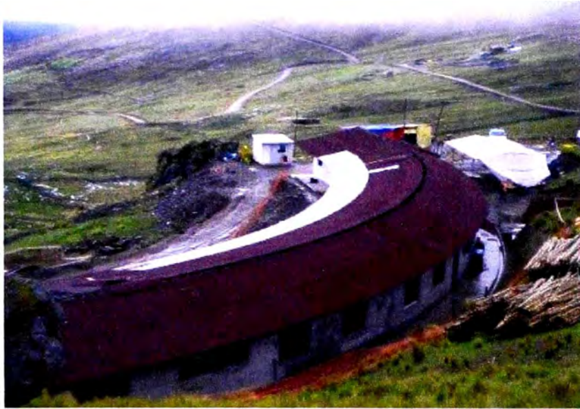
CONSTRUCCION DE CAMPAMENTOS EN PUNO
