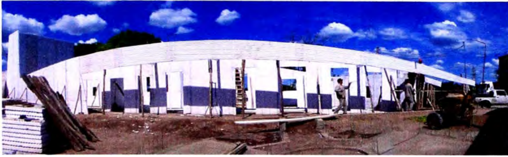
ETAPA DE CONSTRUCCION DE HOSPITAL-ARGENTINA
