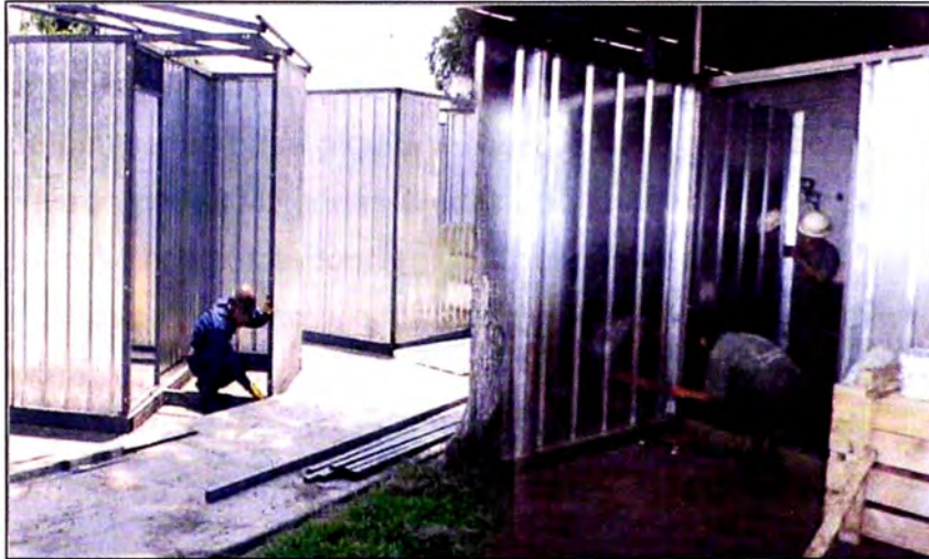
Figura N° 1. 8 .-Vivienda en construcción con el uso del sistema Sidercasa
