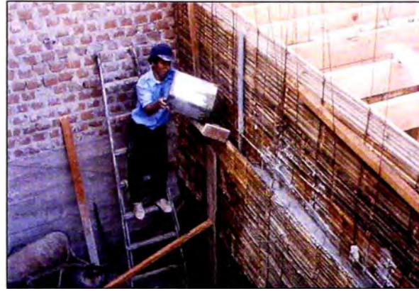
Figura N° 1.17.-Vaciado de concreto en paneles del sistema Cañacreto (Fuente: Sistemas Constructivos No Convencionales – MVCS)
