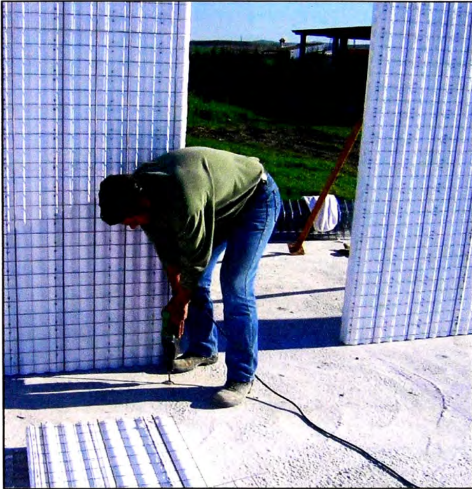
ANCLAJE DE PANELES EMMEDUE
