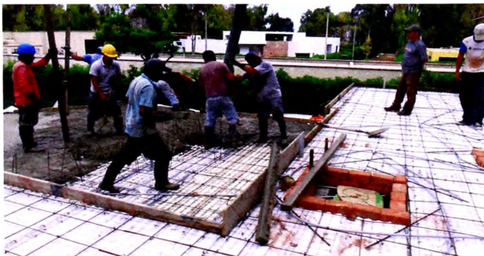
VACIADO DE TECHO VIVIENDA DE LURIN
