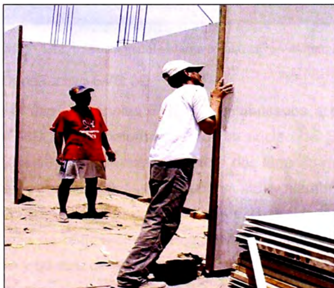
Figura N° 1.11.-Instalación de paneles del sistema Superwall
