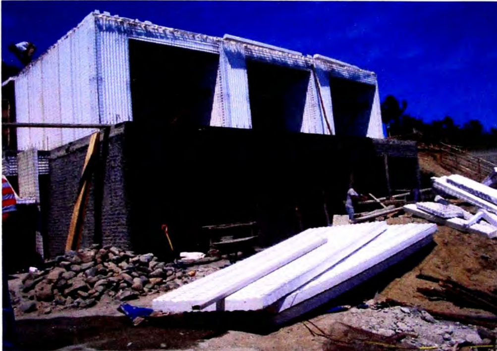
CONSTRUCCION DE HOTEL TRES NIVELES MANCORA
