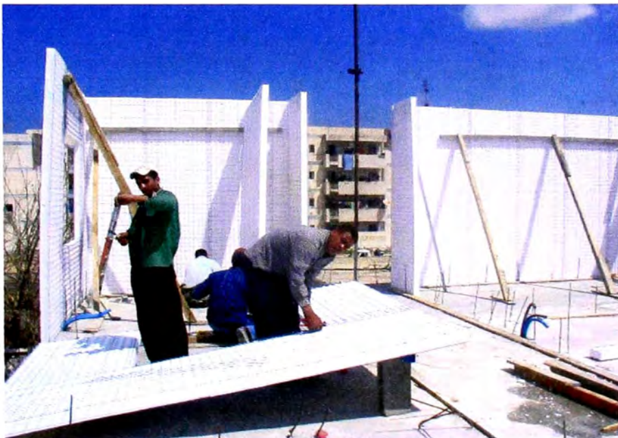
MONTAJE DE PANELES EMMEDUE
