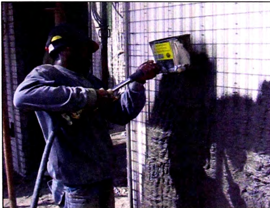
PROYECCION DISCONTINUA DE MORTERO ESTRUCTURAL
