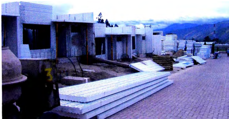
CONSTRUCCIONES MASIVAS CON EL SISTEMA EMMEDUE
