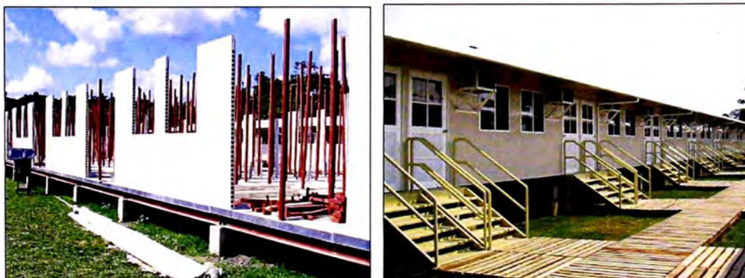
Figura N° 1.20.-Proceso de montaje y vivienda terminada con el sistema (RBS) Fuente: RBS Especificaciones Técnicas - www.modulos.pe
