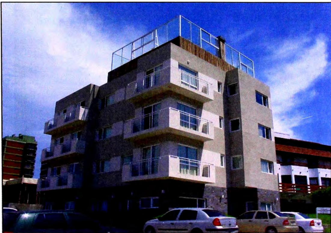
CONSTRUCCION CONCLUIDA DE HOTEL DE 4 NIVELES – ARGENTINA
