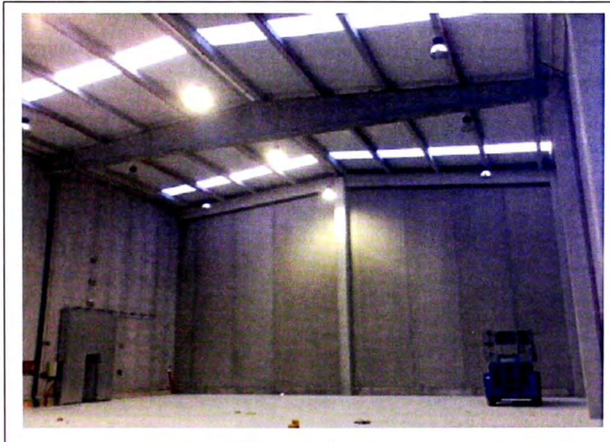
Figura N° 1. 2 .-Edificio industrial de estructura y cerramientos de hormigón prefabricado.
