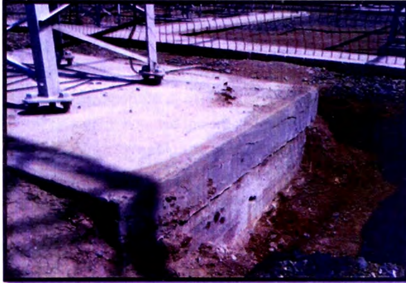
Figura N° 3.1: Pórtico deteriorado
