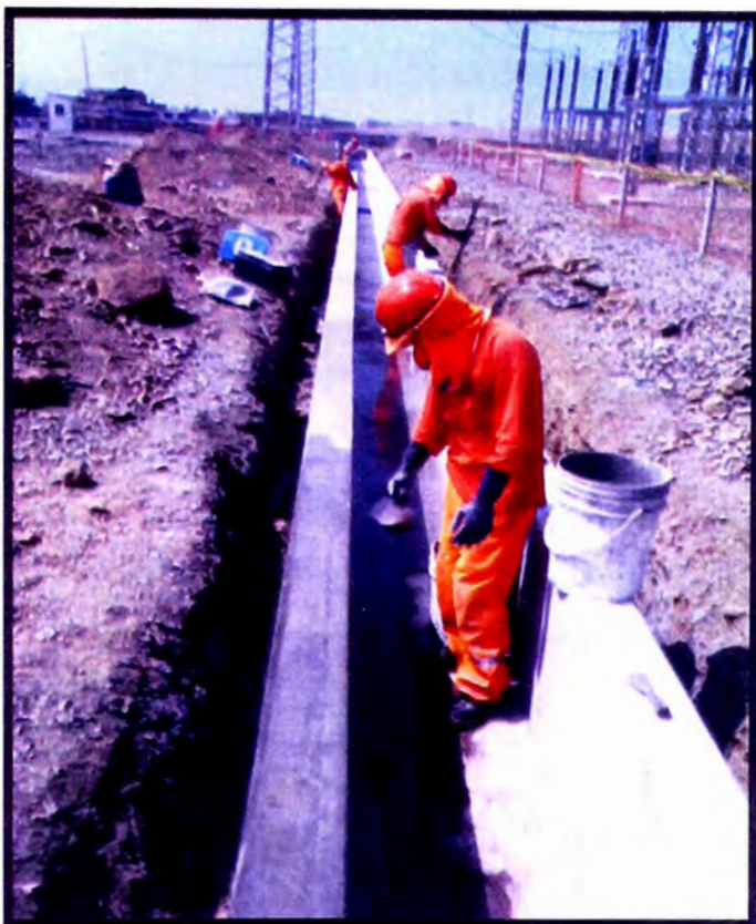
Figura N° 3.4: Limpieza y aplicación de lechosidad de cemento
