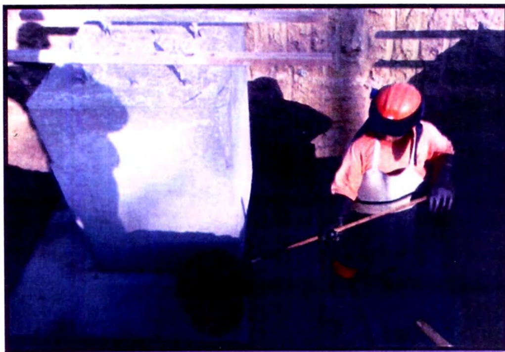
Figura N° 3.7: Aplicación de la cobertura bituminosa con rodillo
