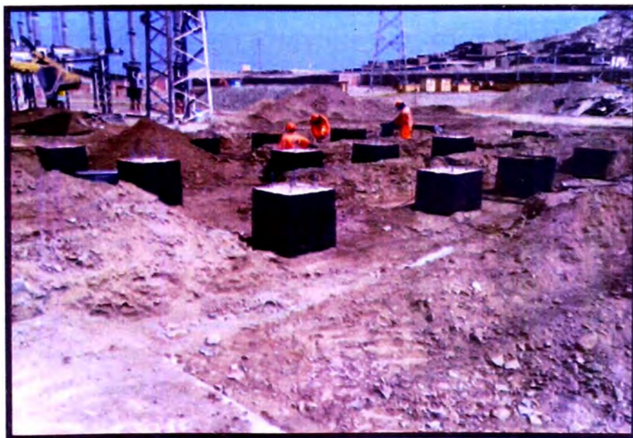
Figura N° 3.3: Vista de la cobertura aplicada en los pedestales
