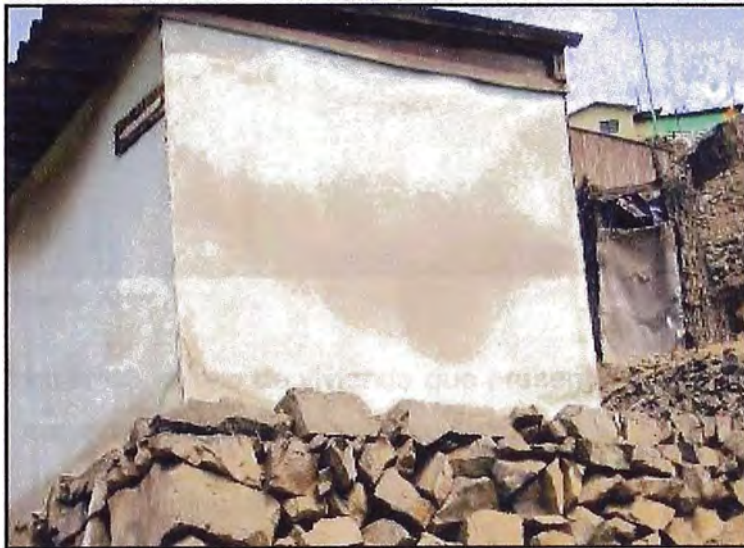
Foto N°13.- Vivienda en las laderas de Pamplona Alta.
