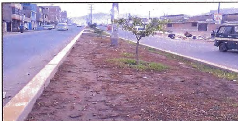
Foto N°19.- Estado de la avenida prolongación San Juan, Pamplona Alta.
