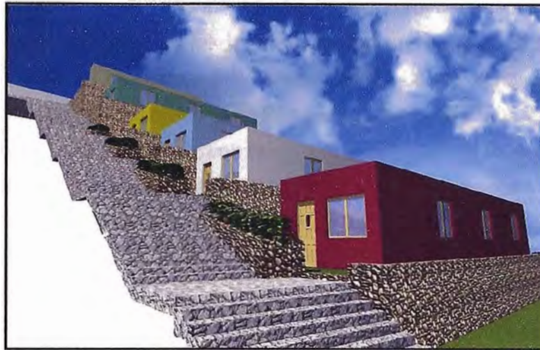
Figura N°16.- Vista panorámica de la obra terminada.
