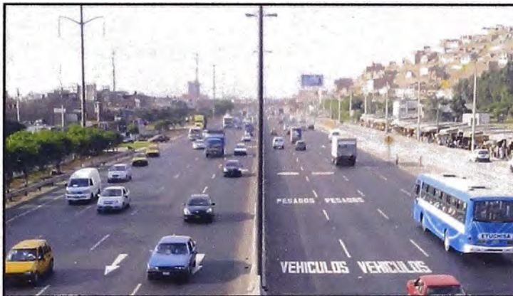
Foto N°7.- Avenida Panamericana Sur.
