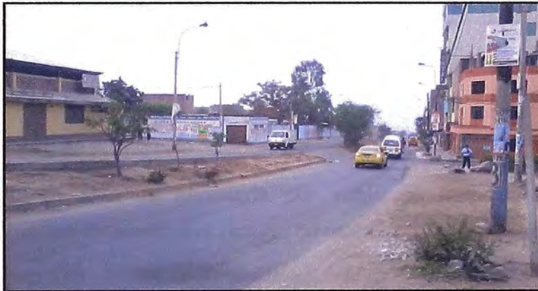
Foto N°18.- Estado de la avenida Central, Pamplona Alta.
