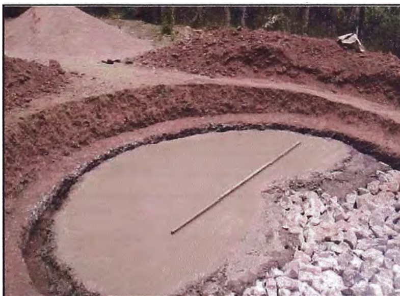
Foto N°26.- Cimentación del tanque, vaciado de la losa de soporte.
