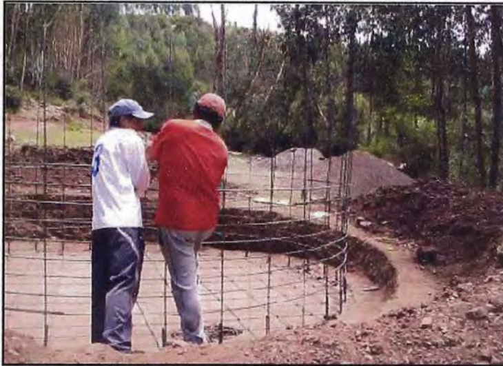
Foto N°27.- Armado del refuerzo horizontal y vertical.
