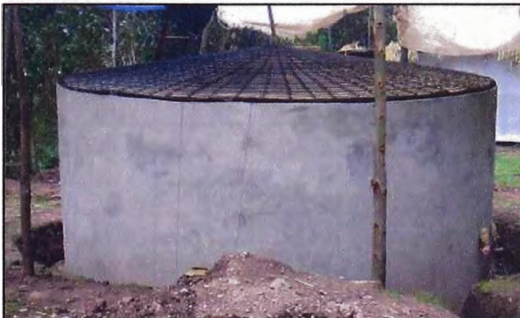
Foto N°29.- Vista panorámica del tanque y la tapa antes del vaciado.
