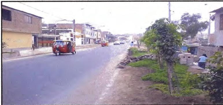
Foto N°21.- Estado de la avenida solidaridad, Pamplona Alta.
