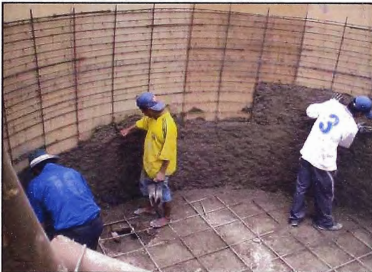
Foto N°28.- Inicio del pañeteo interior.
