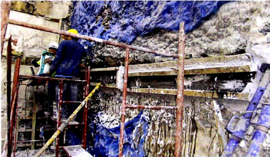
Figura 4.07 Relleno de los vacíos con el concreto epoxi
