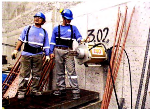
Figura 5.15 Postensado del anclaje 3.02 ubicado en el tercer anillo de la zona 1 del Edificio Comercial Basadre
