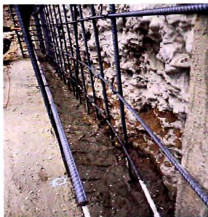
Figura 5.11 Vista del solado típico en pendiente de los paños de los anillos del muro pantalla del Edificio Comercial Basadre
