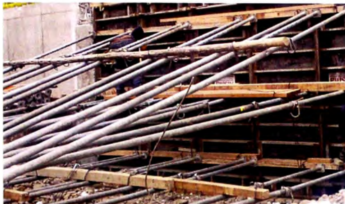
Figura 5.12 Vista de las mechas que evitan que el encofrado se levante por acción de la presión del concreto
