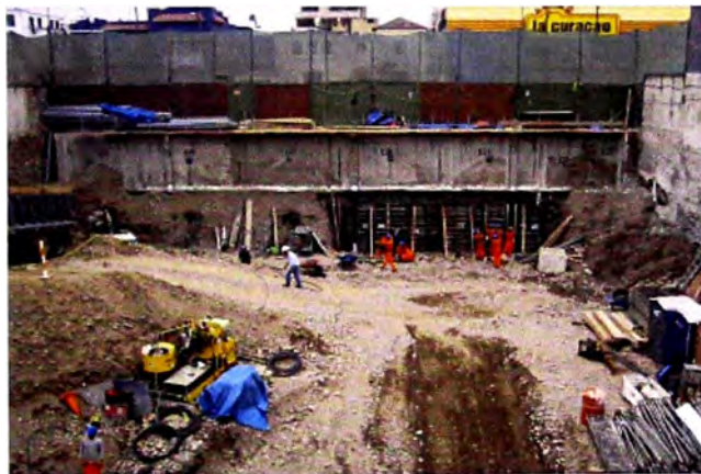
Figura 5.08 Vista frontal de encofrado de muros del Edificio Comercial Basadre
