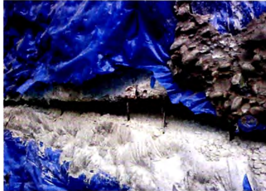
Figura 3.01 Examen visual y acústico de las cangrejas en el encuentro de anillos del muro pantalla
