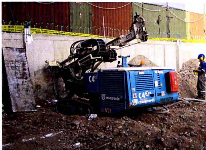
Figura 5.03 Se aprecia el equipo de perforación en el primer anillo de la zona 2 frente a la Av. Arequipa del Edificio Comercial Basadre
