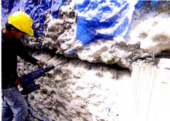
Figura 4.01 Vista desde la propiedad vecina del repicado de los vacíos del muro pantalla utilizando un martillo de percusión en el proyecto Jacinto Lara
