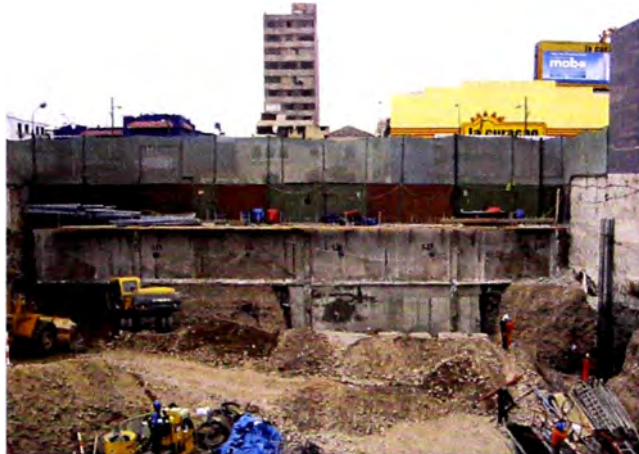
Figura 5.10 Vista frontal del muro desencofrado de la Zona 2 Lado Av. Arequipa del Edificio Comercial Basadre
