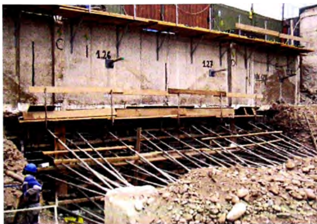
Figura 5.09 Véase el encofrado de muros con su respectiva plataforma de hormigonado de la Zona 2 lado Av. Arequipa del Edificio Comercial Basadre
