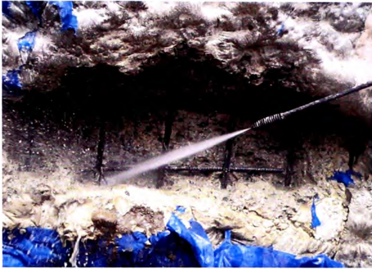
Figura 4.03 Secado de la zona a reparar del Edificio Jacinto Lara
