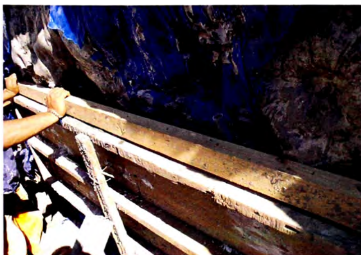
Figura 4.06 Encofrado con madera de la zona a reparar del Edificio Jacinto Lara
