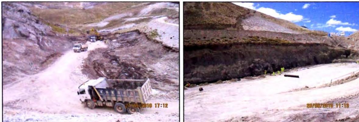
**Figura N° 5.6:** Fotografías de los trabajos de excavación para la determinación de fundación y construcción de drenaje tipo francés.
