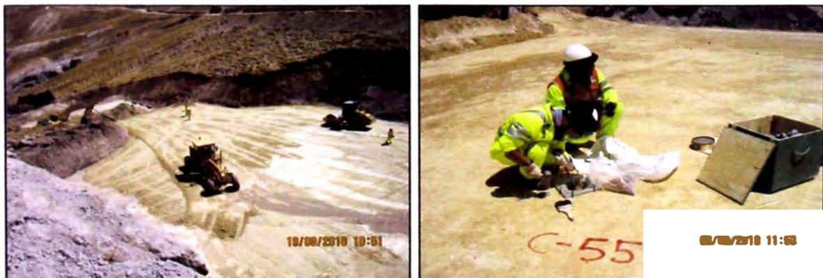
**Figura N° 5.9:** Fotografías de los trabajos de relleno controlado y compactación por capas en el terraplén de nivelación oeste.
