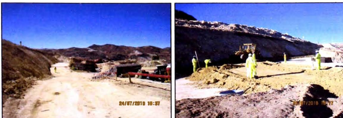
**Figura N° 5.11:** Fotografías de la plataforma de fundación y trabajos de relleno controlado para llegar al nivel de fundación indicado en los planos.
