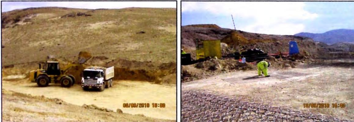
**Figura N° 5.12:** Fotografías de la preparación de materiales de relleno y habilitación de cajas metálicas del sistema terramesh.
