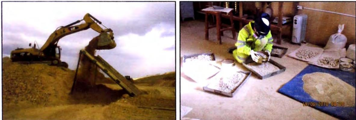
**Figura N° 5.8:** Fotografías de los trabajos de explotación de canteras y ensayos en laboratorio de los materiales de relleno.
