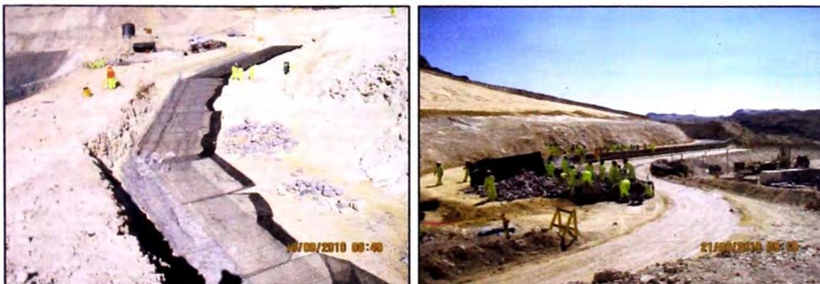
**Figura N° 5.13:** Fotografías donde se observa los trabajos de armado y relleno con rocas de las cajas metálicas del muro terramesh.
