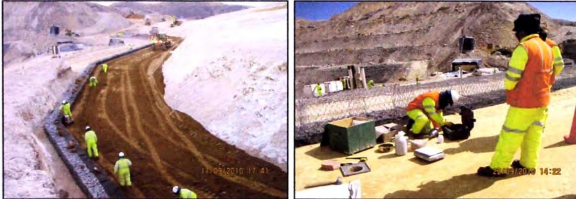
**Figura N° 5.14:** Fotografías donde se observa los trabajos de conformación de capas con material granular pre-seleccionado, y las pruebas realizadas por capa.
