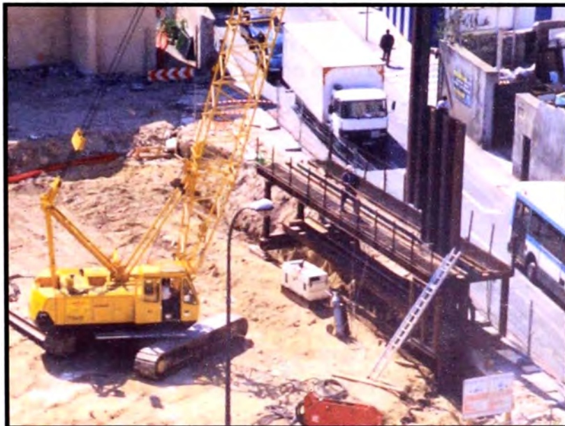
Figura 2.8: Guía de Instalación de 02 niveles donde se aprecia la verticalidad de las tablestacas, la pasarela, los pasamanos y la escalera de acceso
