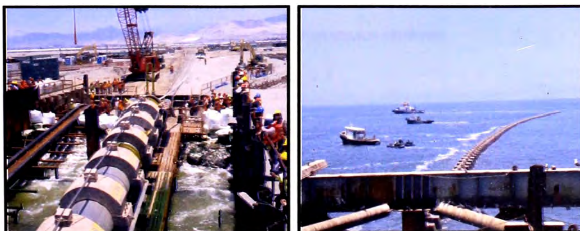
Figura 5.24: Lanzamiento de la tubería y el retiro de las tablestacas de la zona marina
