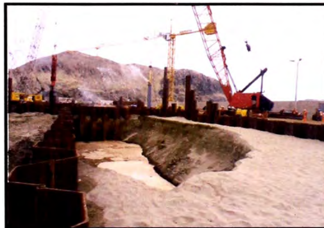
Figura 5.11: Hincado de tablestacado
