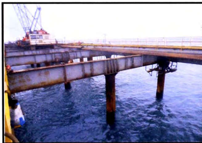
Figura 5.20: Instalación de la línea de pilotes y las vigas
