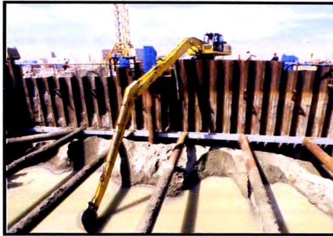
Figura 5.15: Vista de los trabajos en conjunto, pala mecánica, bomba externa, mano de obra
