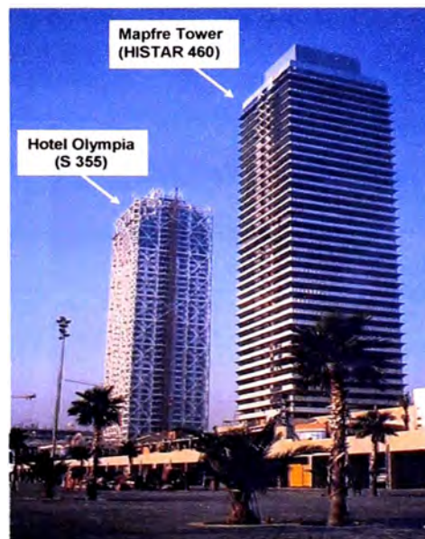
Figura 6. Comparativa de dos edificios similares en Barcelona en los que se pueden apreciar claramente las ventajas del uso de los aceros HISTAR
