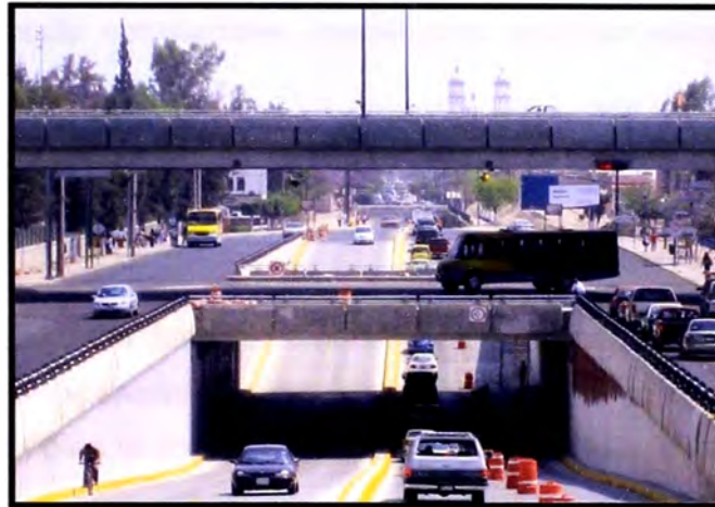
Figura 1.11: Paso a desnivel en Aguas Calientes, México
