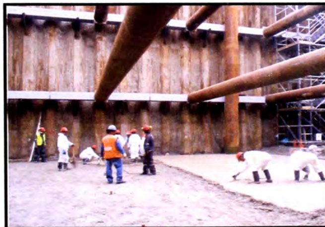
Figura 5.18: Vaciado de la losa de concreto
