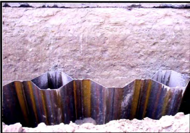
Figura 5.28: Cajón de tablestaca CAU 14 – 2 instalada en campo
