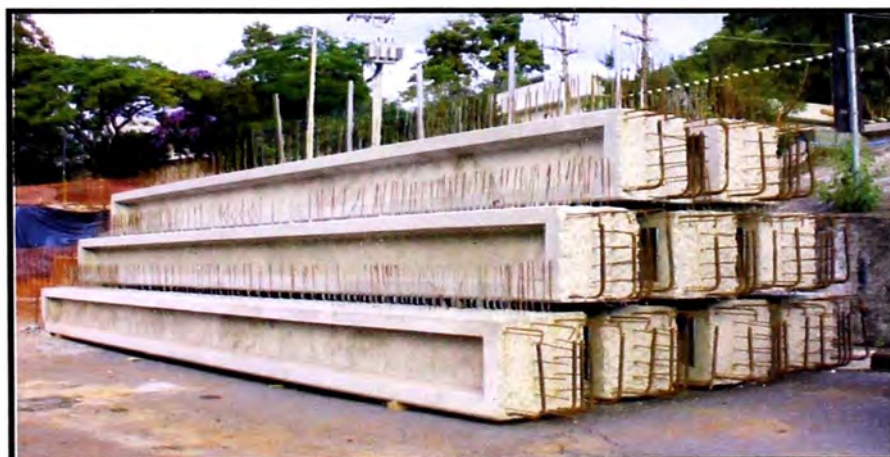
Figura 5.31: Vigas pre-fabricadas para la construcción de la losa superior del túnel
