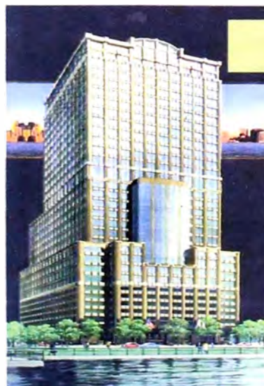
Figura 8 Edificio en Jersey City, USA, construido con acero de alto límite elástico
