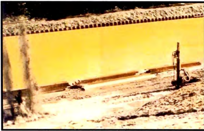
Figura 2.13: Uso del sistema de voladura ejecutando taladro a espaciamiento específicos
