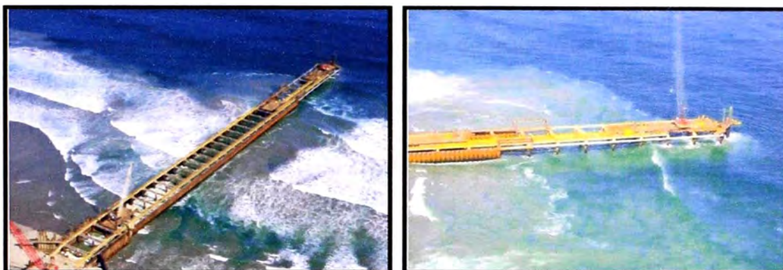
Figura 5.22: Avance de la instalación de la tablestaca y cierre en diagonal en la parte final
