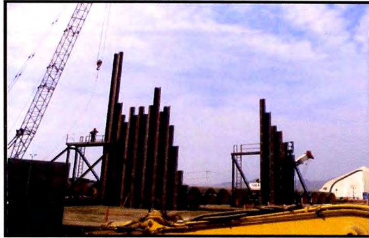
Figura 5.10: Equipos utilizados en la instalación de tablestacas en el proyecto termoeléctrica de Chilca
