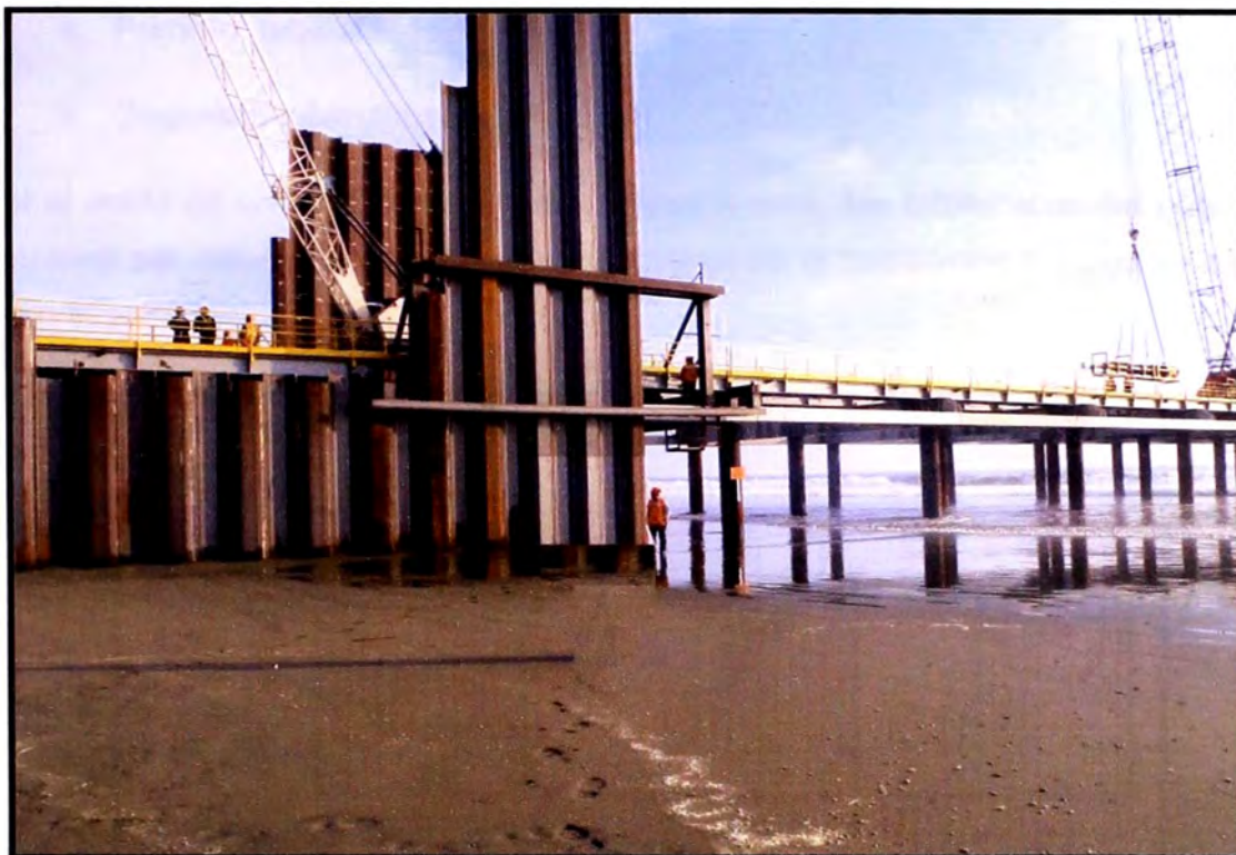
Figura 2.3: Método del panel de hincado y guía de instalación
