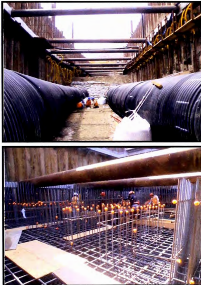
Figura 5.19: Colocación de las tuberías y la construcción de estructura de concreto.
