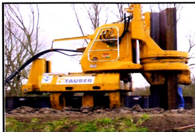
Figura 3.9: Martillo de presión instalando tablestacas
