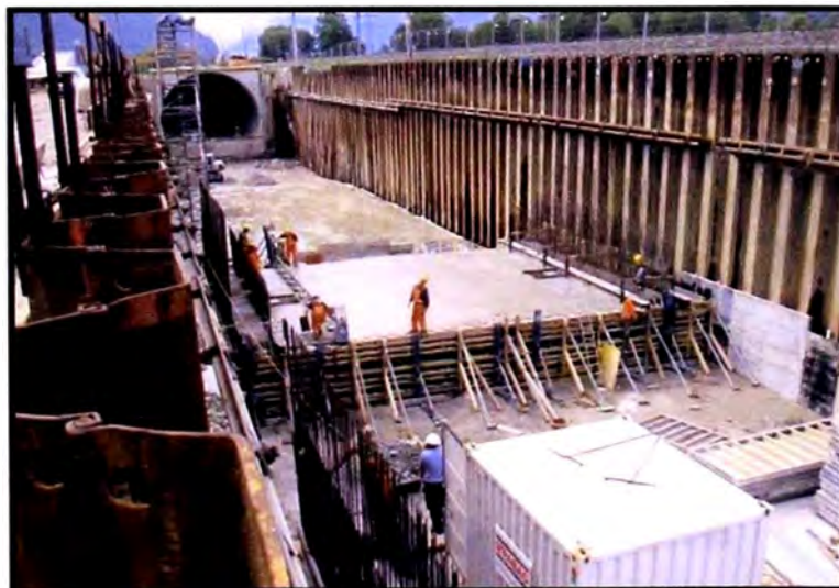
Figura 1.8: Muro de contención
