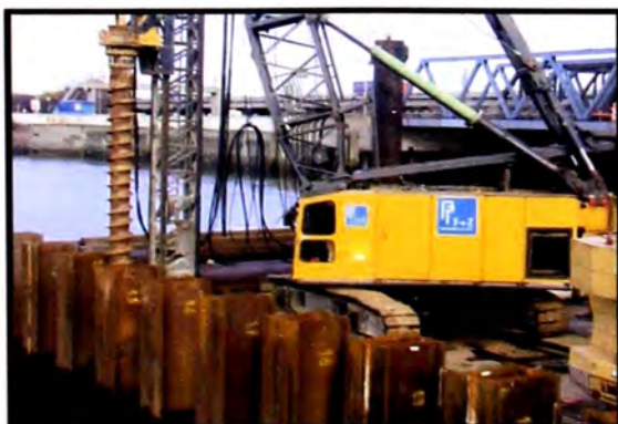
Figura 2.14: Uso de la técnica del pre-barrenado, donde se puede ver la penetración del taladro para facilitar la instalación de las tablestacas
