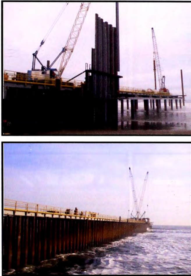
Figura 5.21: Instalación de las tablestacas a todo lo largo de la estructura formada por pilotes y vigas
