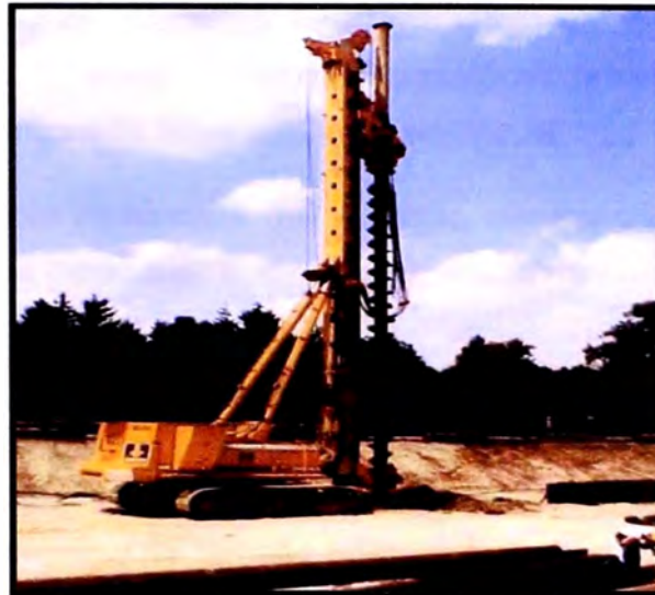
Figura 2.15: Uso de la técnica del pre-barrenado donde se ve el uso del equipo guía telescópico facilitando el uso del taladro
