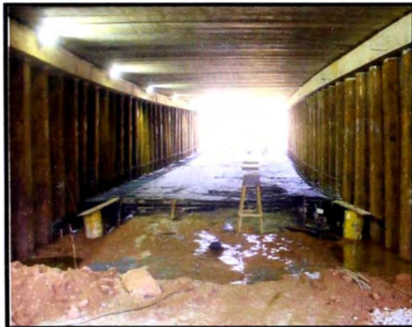
Figura 5.34: Vaciado de la losa inferior del túnel y trabajos de acabados para poner en funcionamiento el túnel.
