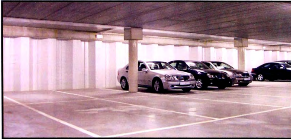
Figura 1.9: Estacionamiento subterráneo del edificio principal de Mercedes Benz
