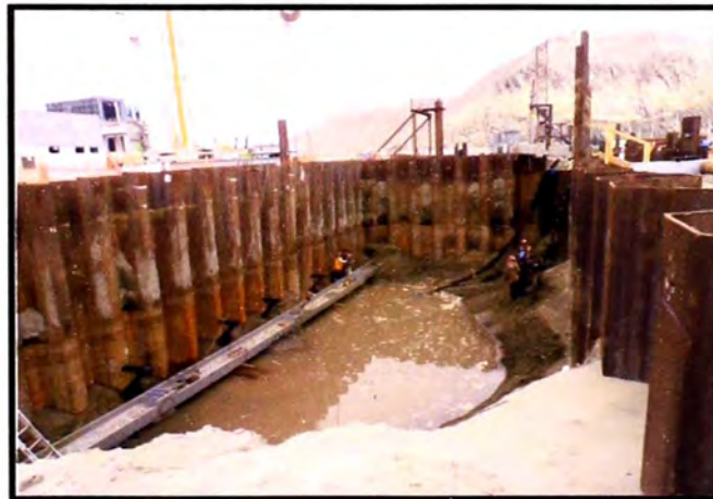
Figura 5.13: Uso de bomba externa para deprimir el nivel freático
