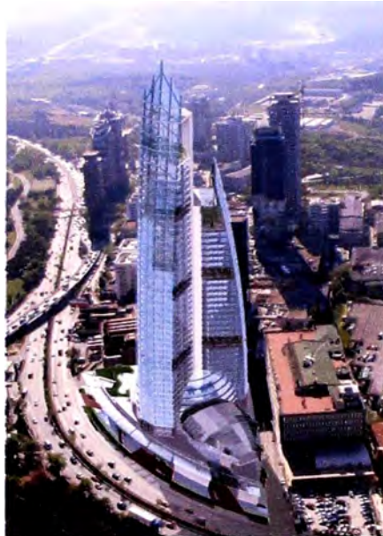
Figura 5. Torre El Diamante en Estambul, Turquía, cuya construcción con acero HISTAR permitió una reducción de las emisiones de CO 2 del 25% respecto al acero convencional S235
