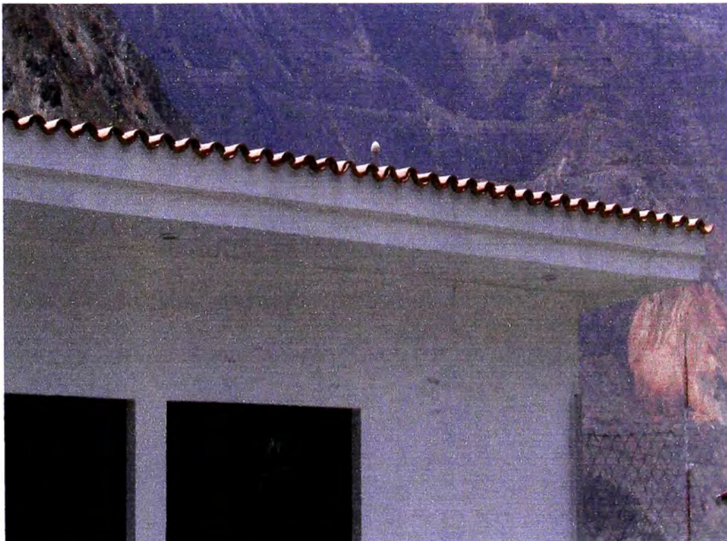
Foto N° 8.2 Antena ubicada sobre techo de sala de control
