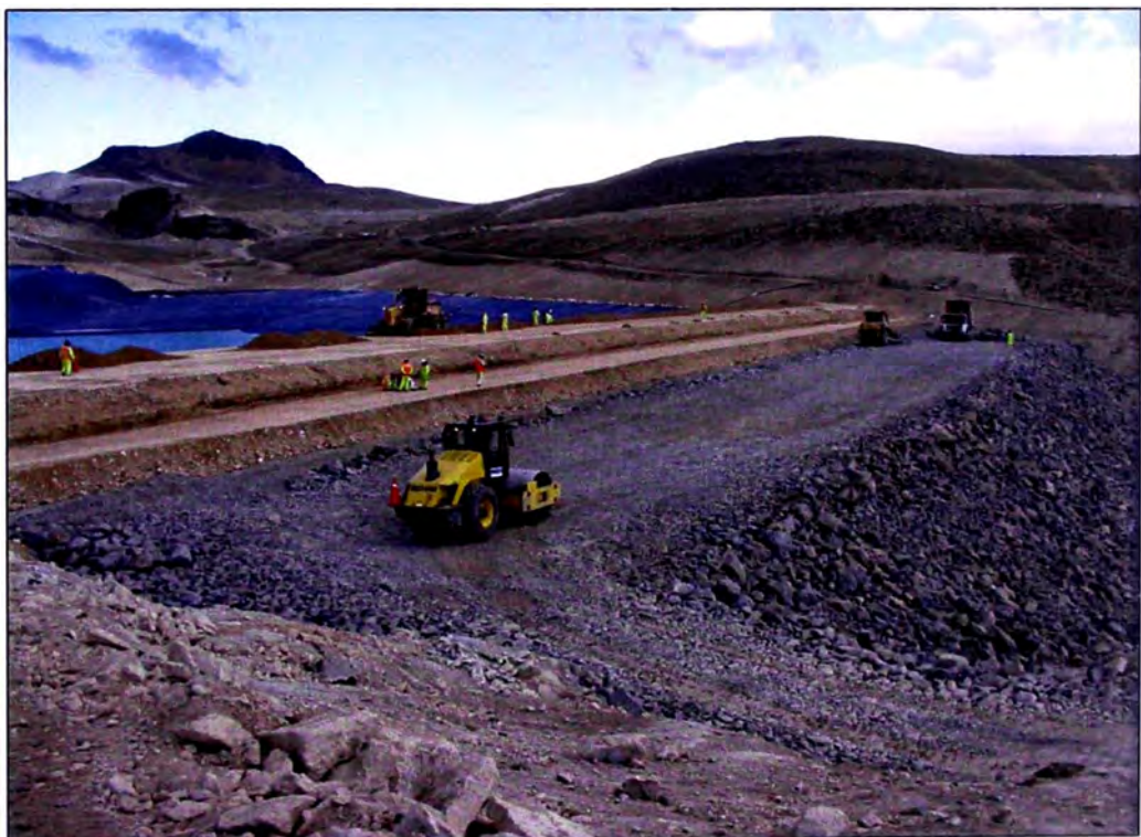
Foto N°04.- Compactación de material tipo 3
