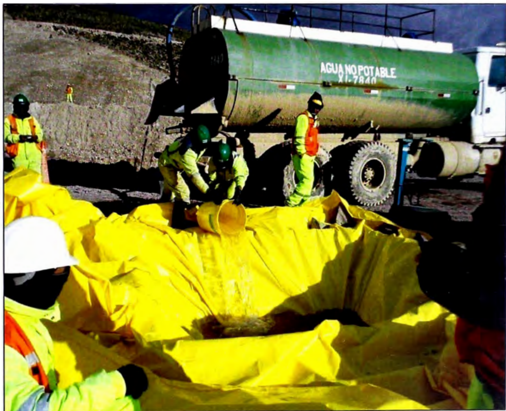
Foto N°10.- Ensayo de densidad in situ por reemplazo de agua- MT3
