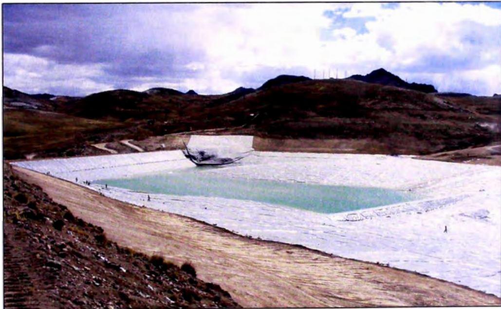
Foto N°02.- Vaso del depósito de relaves
