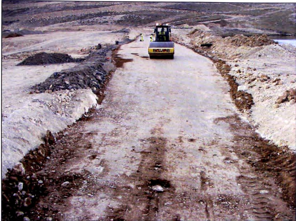
Foto N°17.- Compactación del material tipo 1 en el Dique Patococha
