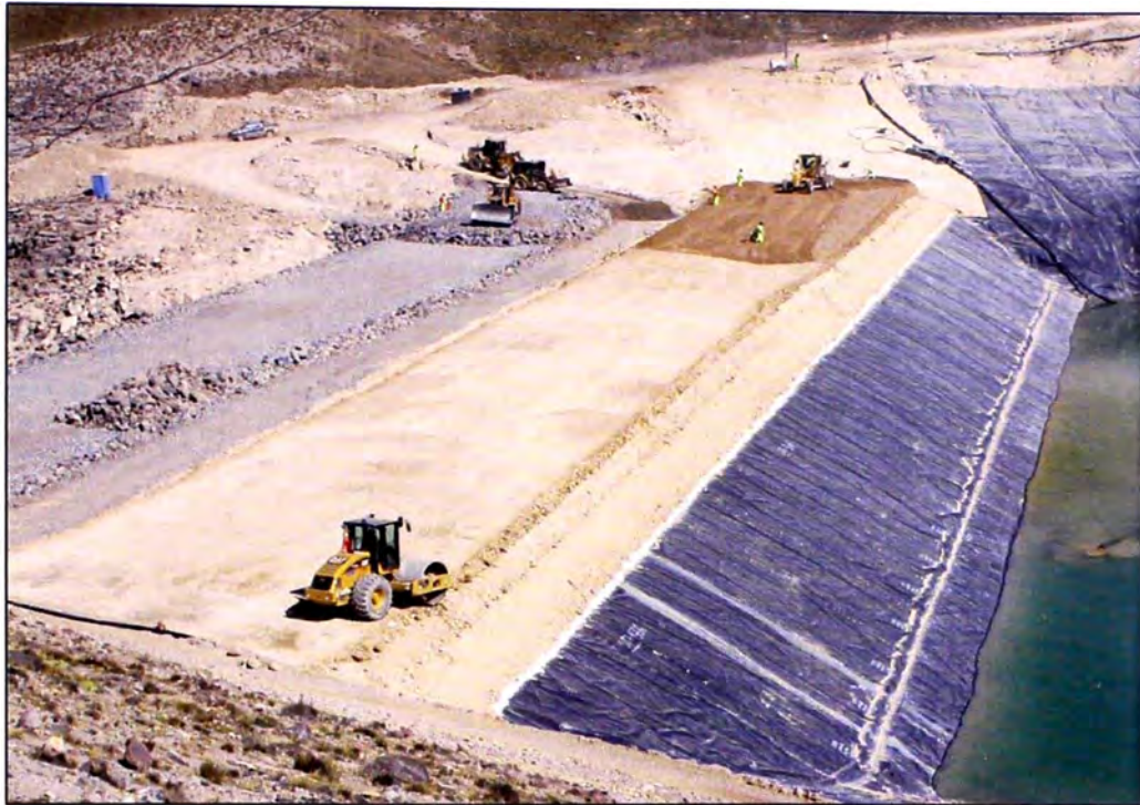
Foto N°05.- Compactación del material tipo 1 en el dique de la presa
