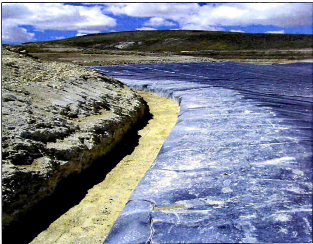
Foto N°18.- Relleno tipo 1 en zanja de anclaje de geomenbrana
