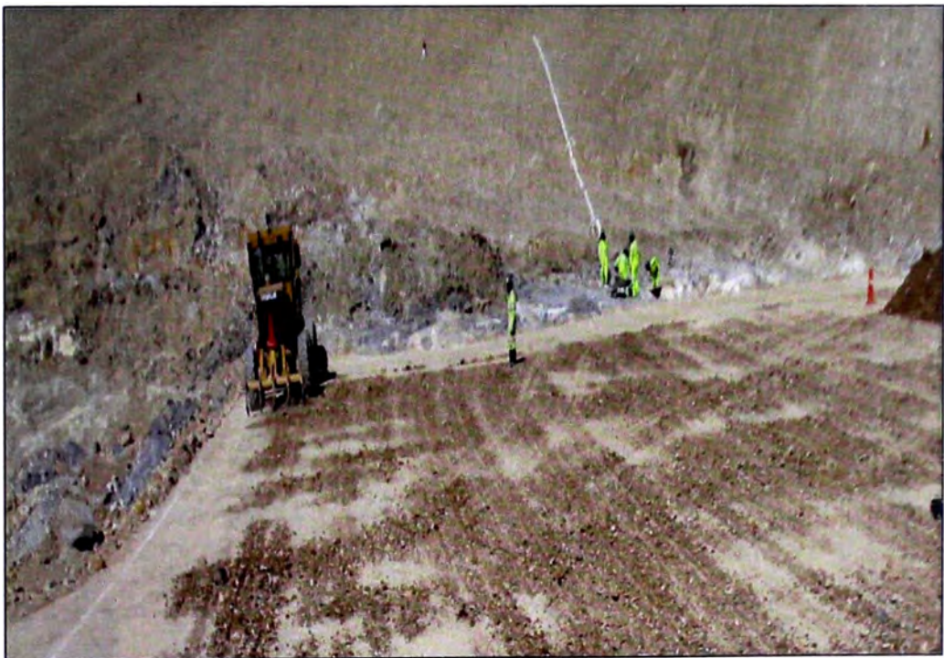
Foto N°14.- Escarificado del material tipo 1 compactado
