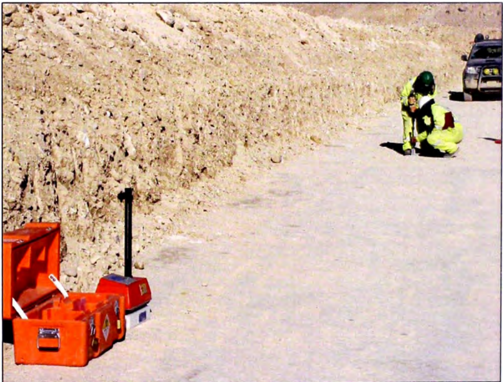
Foto N°16.- Ensayo de densidad in situ con densímetro nuclear- MT8
