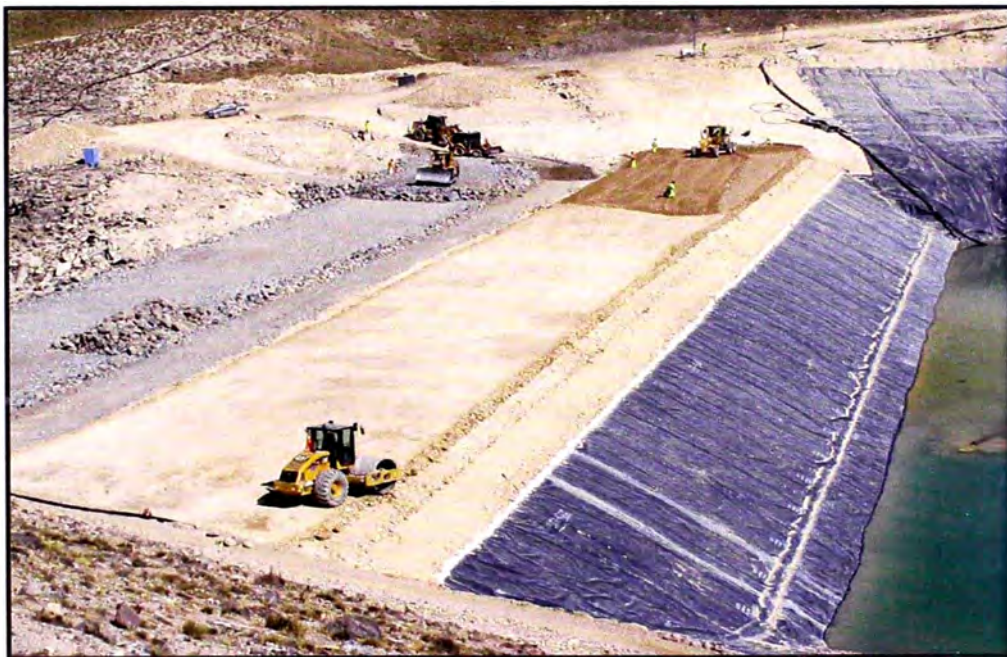
Figura N° 5.1.-Conformación y colocación del material tipo 1
