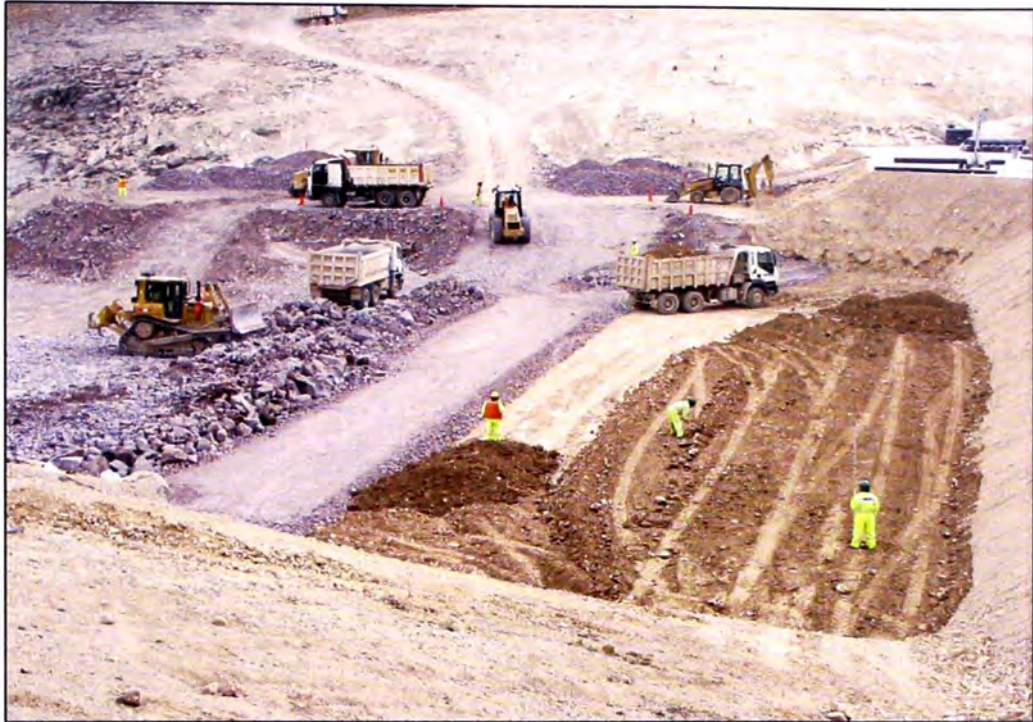
Foto N°03.- Conformación de material tipo 1, 2 y 3
