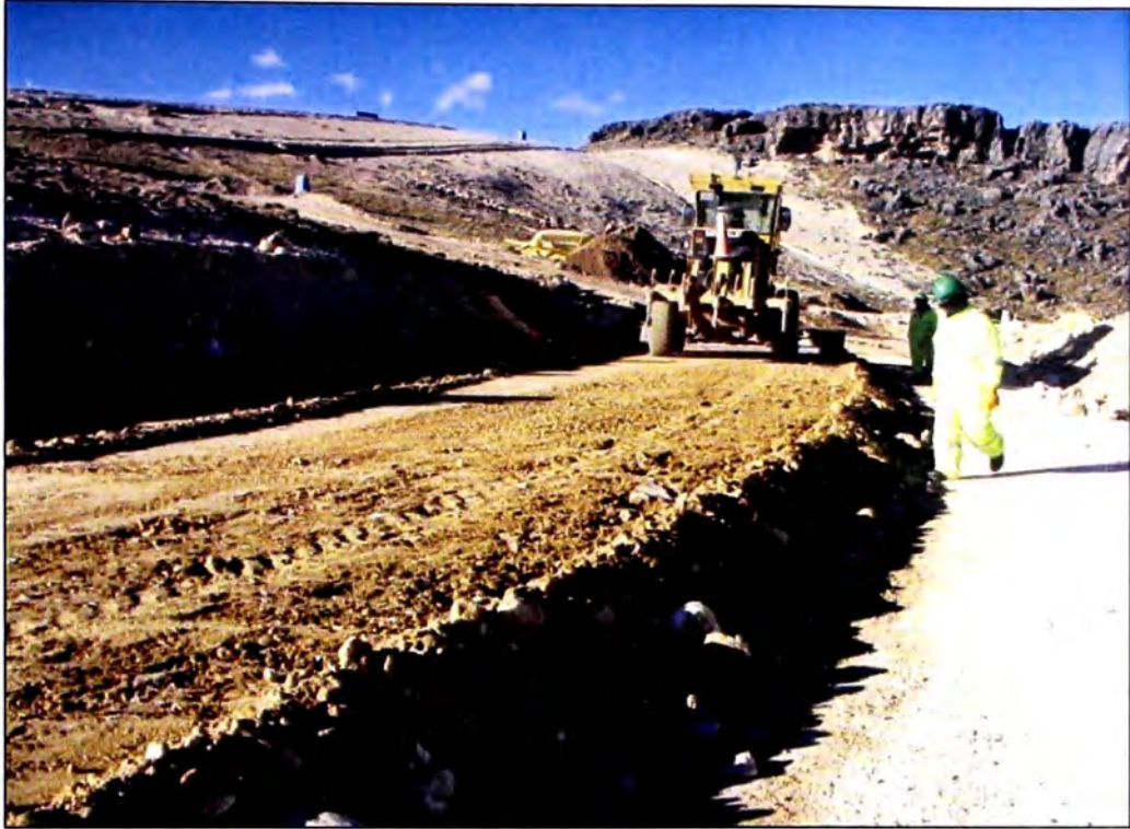
Foto N°13.- Plataforma del canal de derivación margen derecha-MT8
