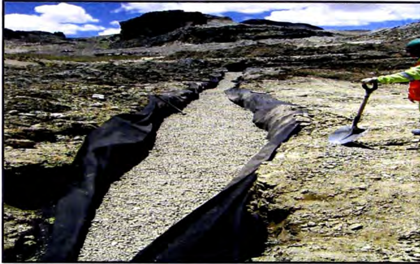
Figura N° 5.4.-Colocación de material tipo 6
