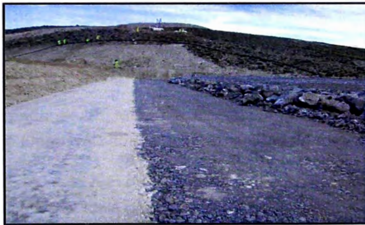
Figura N° 5.3.-Contacto de material tipo 1 y tipo 2
