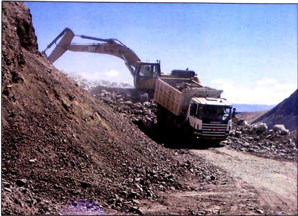
Foto N°15.- Carguío de material tipo 3 en cantera de roca
