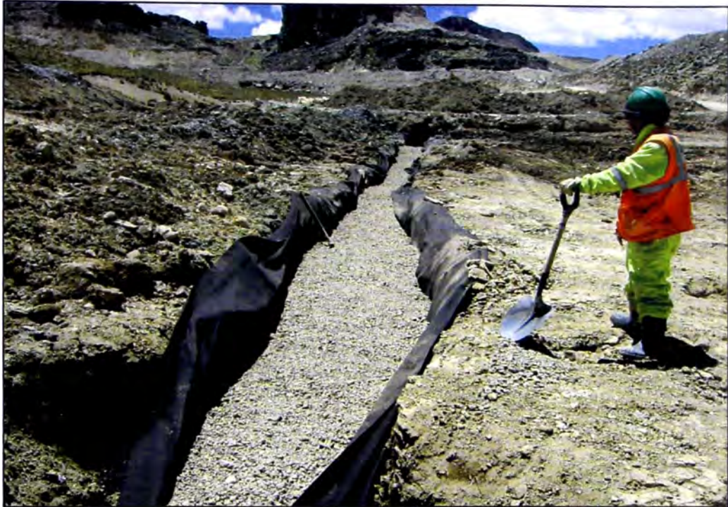
Foto N°07.- Colocación de filtro en subdrenaje-Material tipo 6
