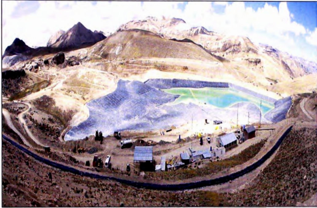
Foto N°01.- Vista general de la Presa de Relaves Pallancata
