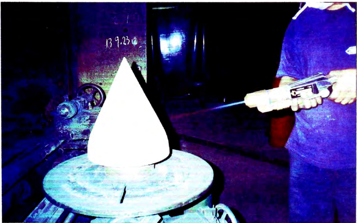
Figura 2, Proceso de aplicación de recubrimiento Carburo de Tungsteno mediante el termo-rociado a aguja de Turbina Pelton.
