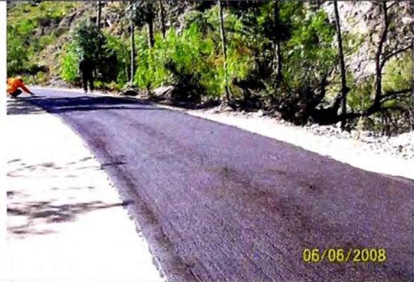
Colocado de mortero asfáltico en el tramo de prueba
