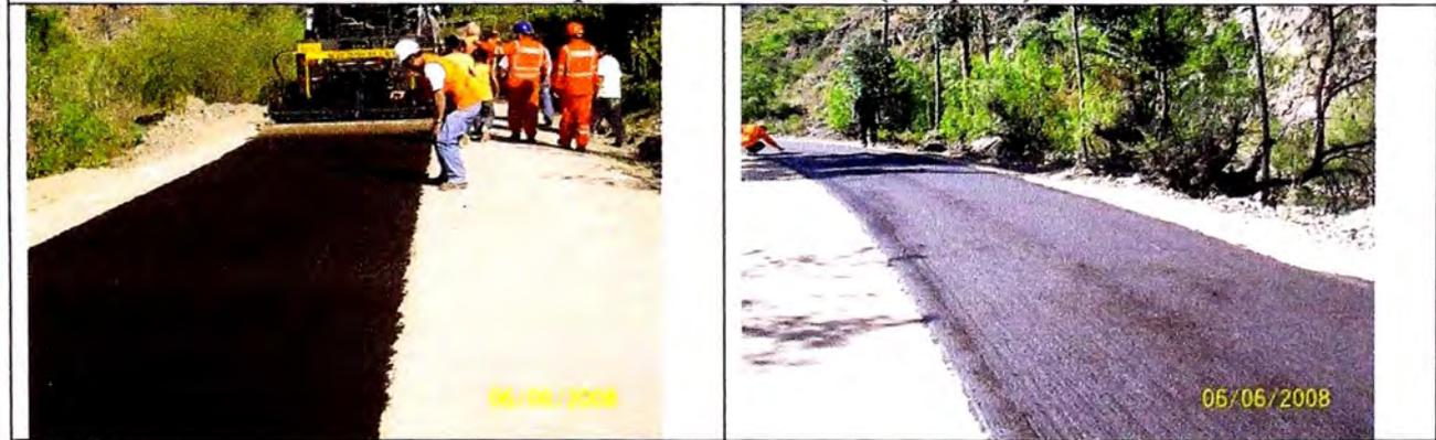
Colocado de mortero asfaltico en el tramo de prueba
