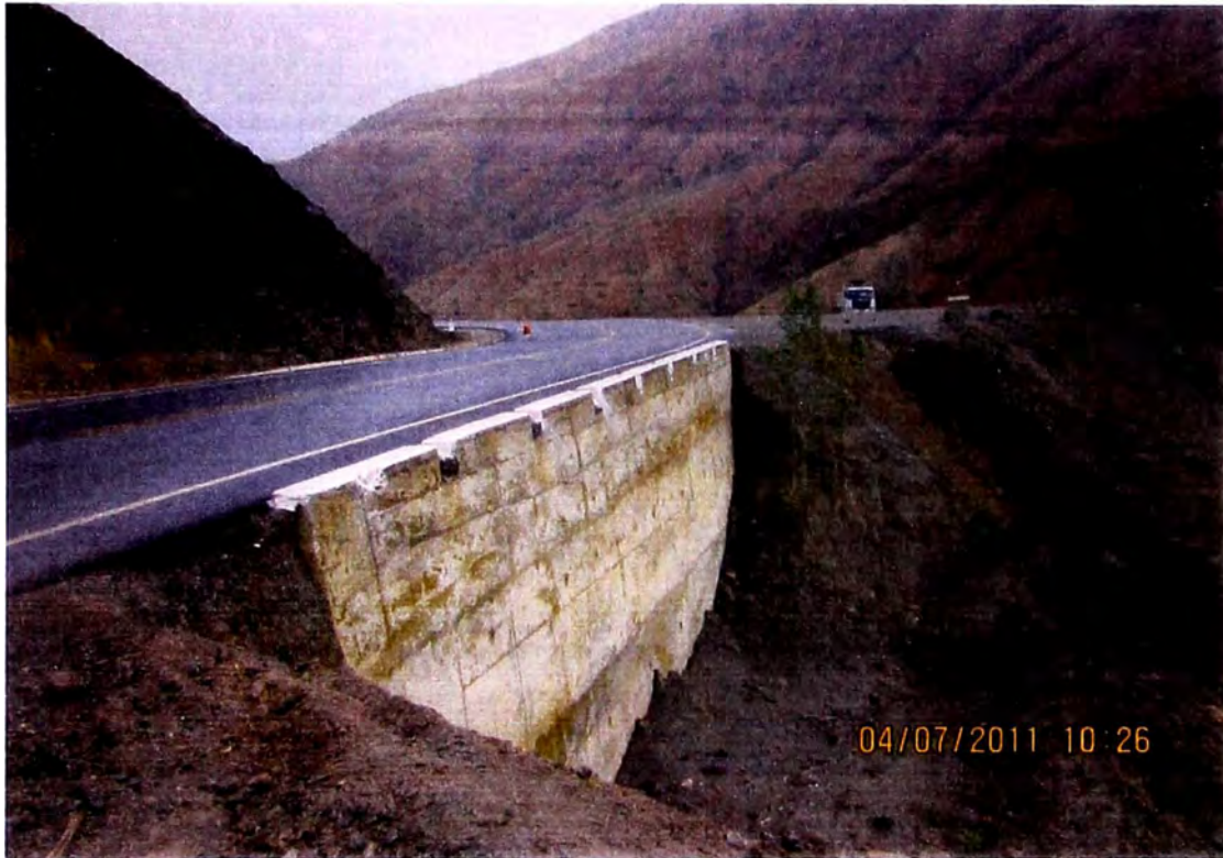
Foto 07: Km. 42 Vista de muro de contención construido de concreto armado.
