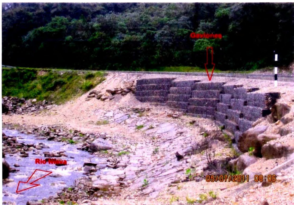
Foto 20: Río Nieva, Km. 379+000, muros de contención construido con gaviones.
