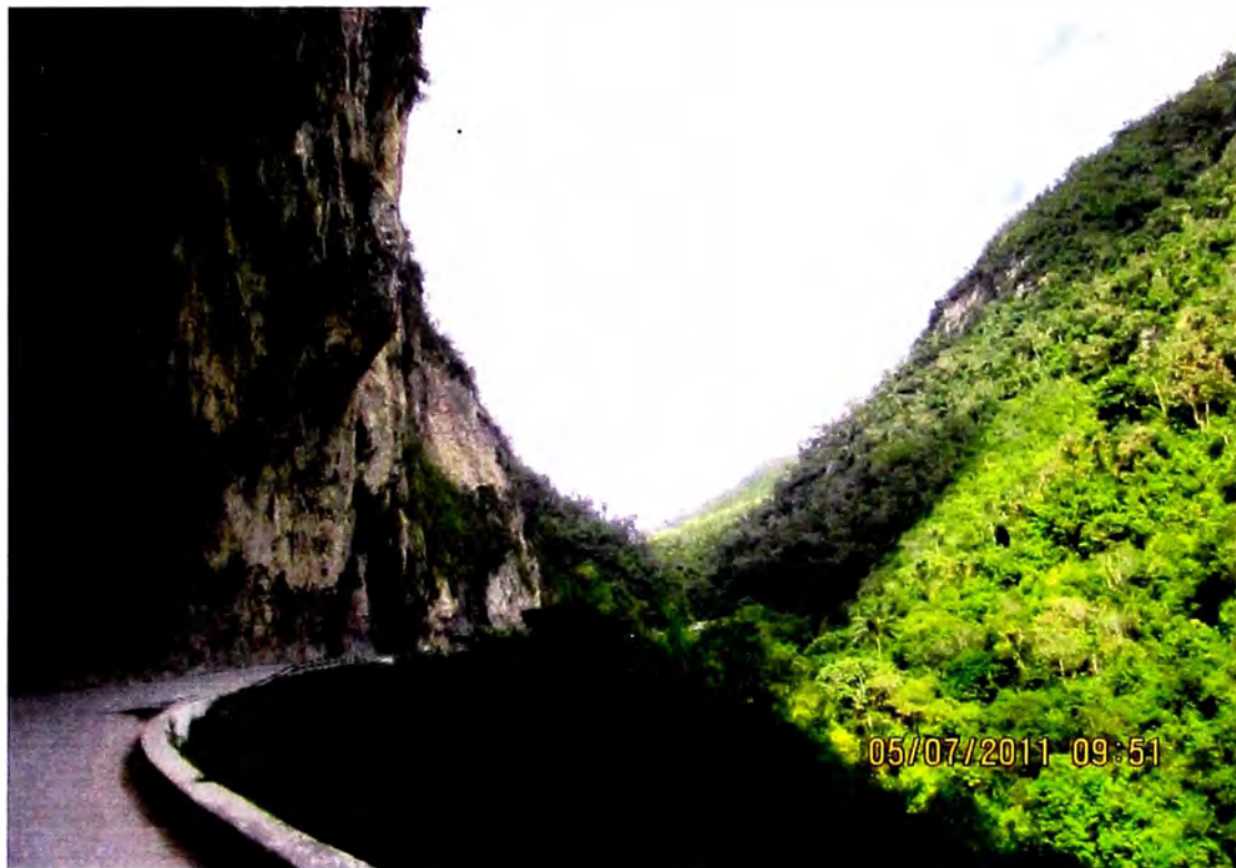
Foto 19: Km. 360 Para dar continuidad al desarrollo de la carretera fue necesario realizar un corte tipo medio túnel.
