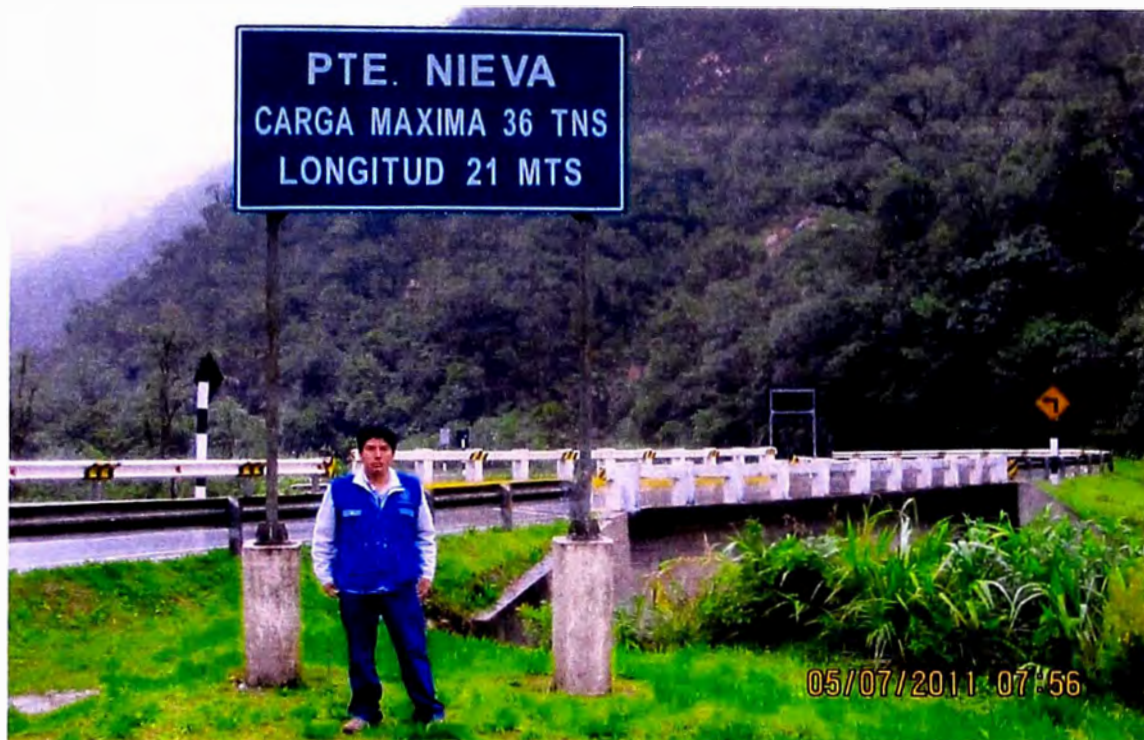
Foto 21: Km. 380+000 de la carretera en estudio cruza al Río Nieva a través del Puente Nieva (fin de estudio).
