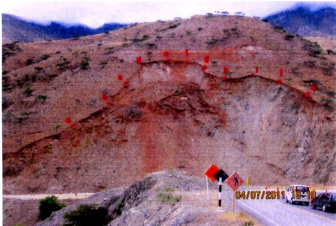
Foto 08: Km. 55 Se observa la obstrucción de la carretera a consecuencia de un deslizamiento.
