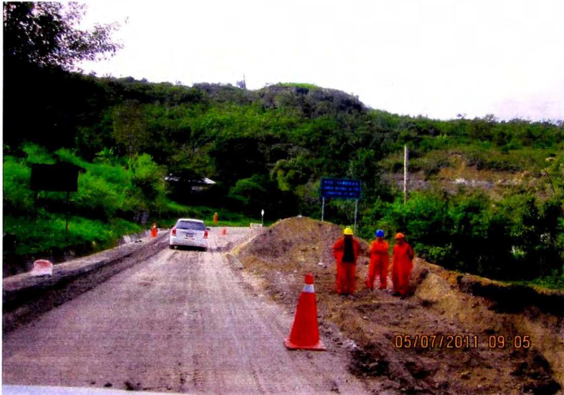
Foto 17: Km. 340 Debido al inadecuado drenaje se produjo un hundimiento, están procediendo a realizar el cambio del material de la plataforma.
