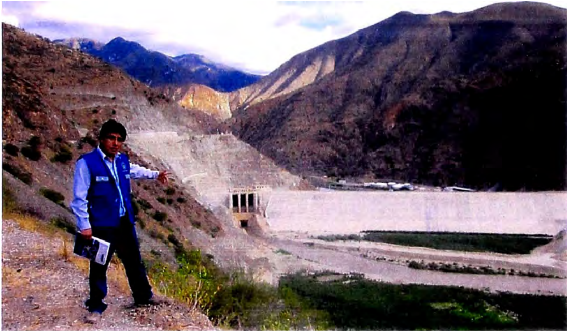
Foto 09: Km. 86 Vista aguas abajo de la Presa Limón, ubicada en el Frente Oriental de la carretera Olmos - Corral Quemado, en el distrito de San Felipe, departamento de Cajamarca. La capacidad de almacenamiento de la presa para la primera etapa es de 44 millones de metros cúbicos de agua.
