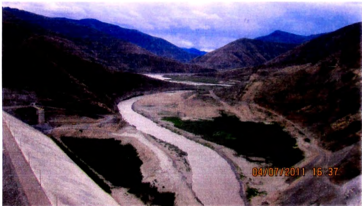
Foto 10: Vista aguas arriba de la Presa Limón, capacidad de almacenamiento de la presa para la primera etapa es de 44 millones de metros cúbicos de agua.
