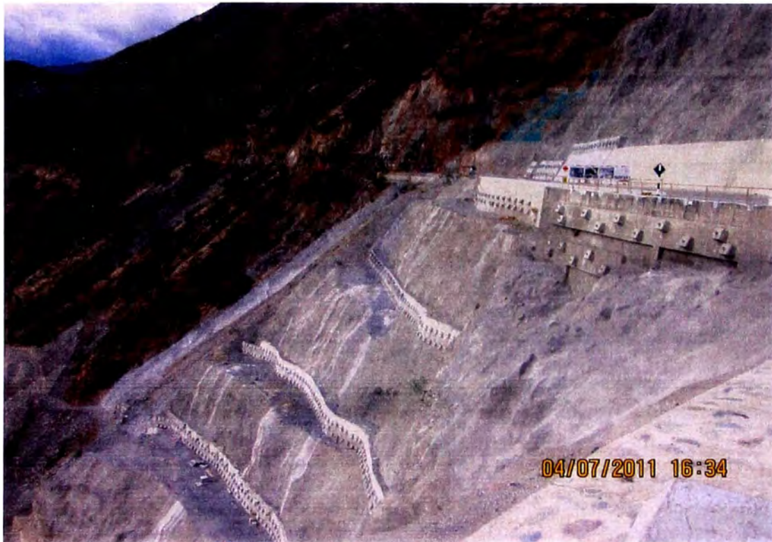
Foto 11: Km. 87 La imagen muestra los trabajos de estabilización de taludes con muros pantalla y concreto lanzado.
