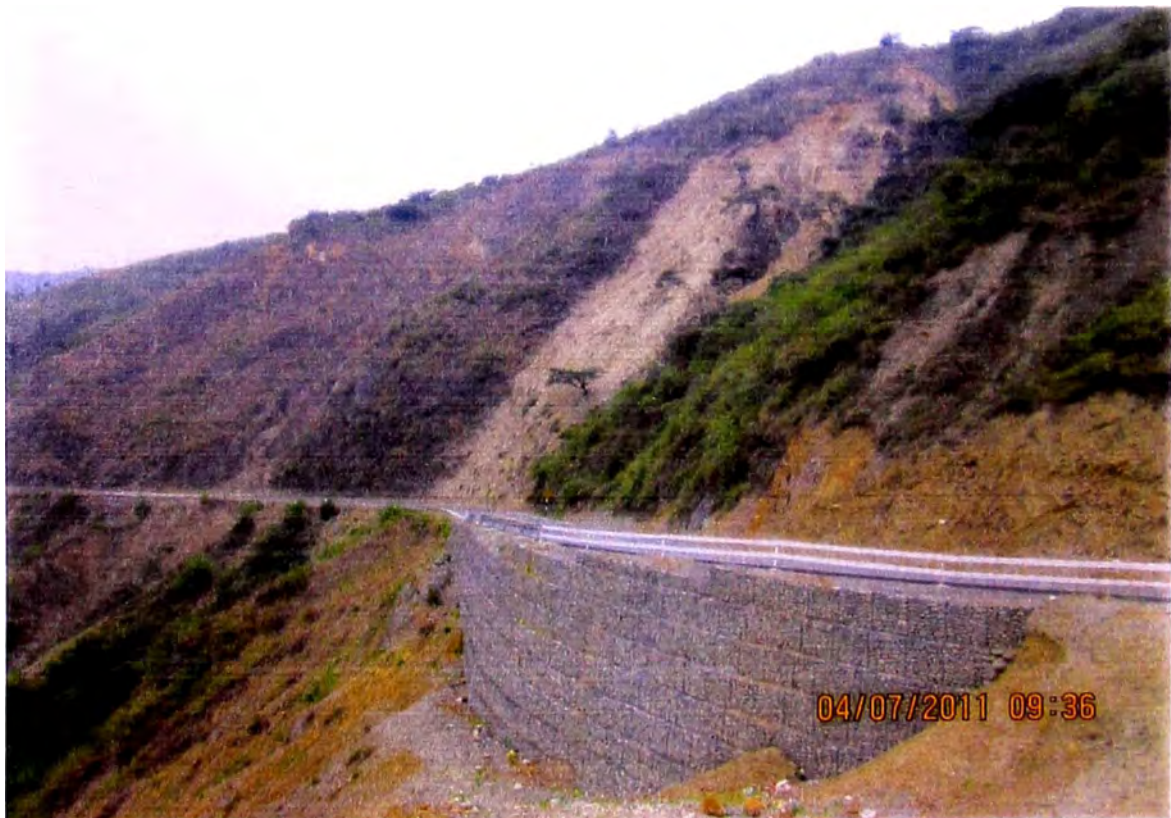
Foto 06: Km. 38 Vista de muro de contención de gaviones.
