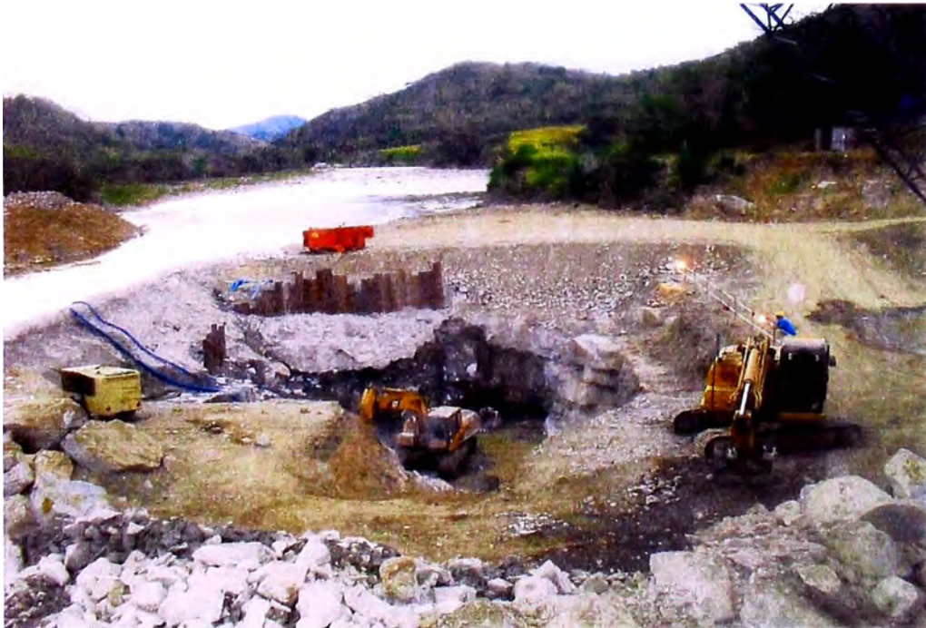
Foto N° 1.2. Construcción de Puente Alterno Macara
