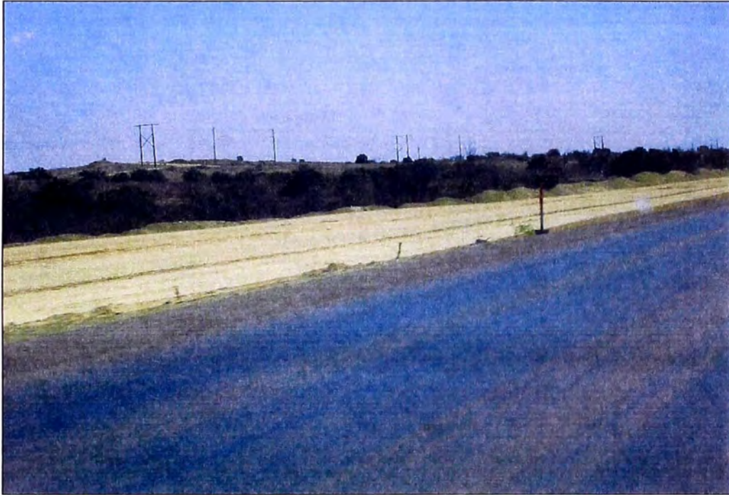
Foto N° 1.1. Ampliación del tramo Piura Sullana, trabajos de conformación de base
