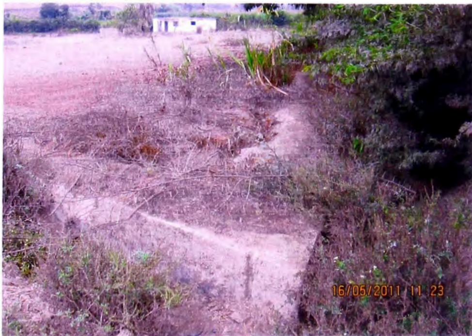
FOTON°26 UBICACIÓN DE BM10 (COTA= 225.647), ENCIMA DE CANAL DE CONCRETO AL INICIO DEL TERRENO DE LAS LAGUNAS DE OXIDACION
