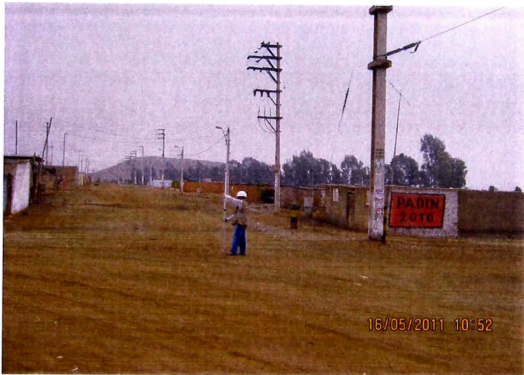
FOTON°05 SE CORRE NIVELACION PARA UBICACIÓN DE BM2
