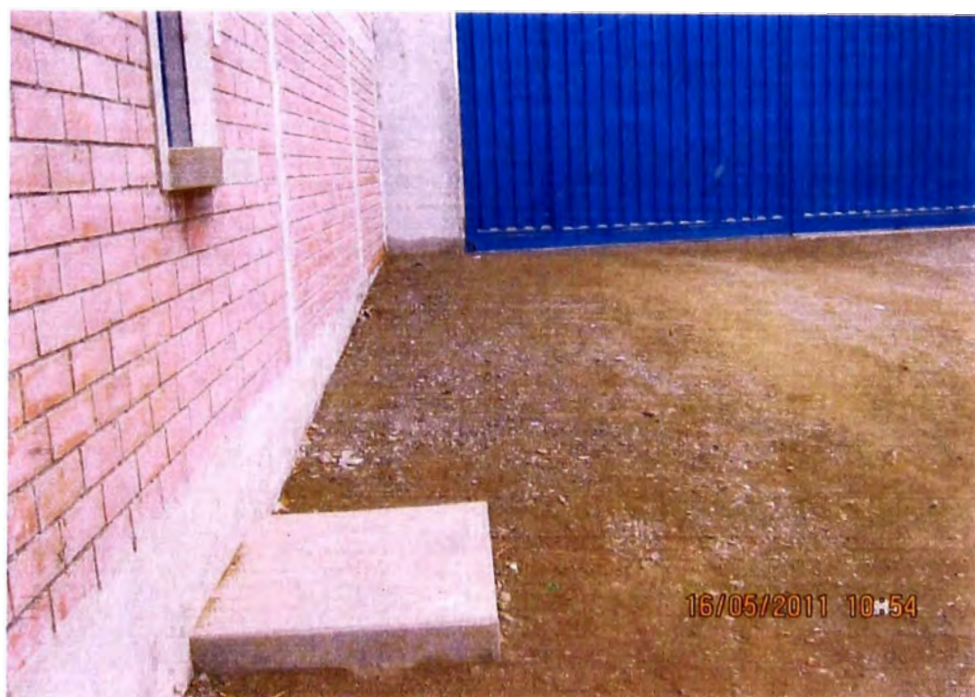
FOTON°08 UBICACIÓN DE BM2 (COTA=241.648), EN LOZA DE FACHADA DE PLANTA ELECTRICA
