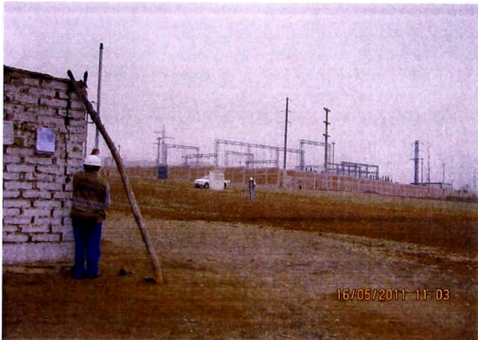
FOTON°13 UBICACIÓN DE BM5 (COTA=238.898), EN ESQUINA DE CASA BLANCA DE ADOBE, SE COLOCO FIERRO, UBICADA A LA MARGEN IZQUIERDA INGRESANDO CON DIRECCION AL PENAL, EN LA CALLE SANTA ROSA
