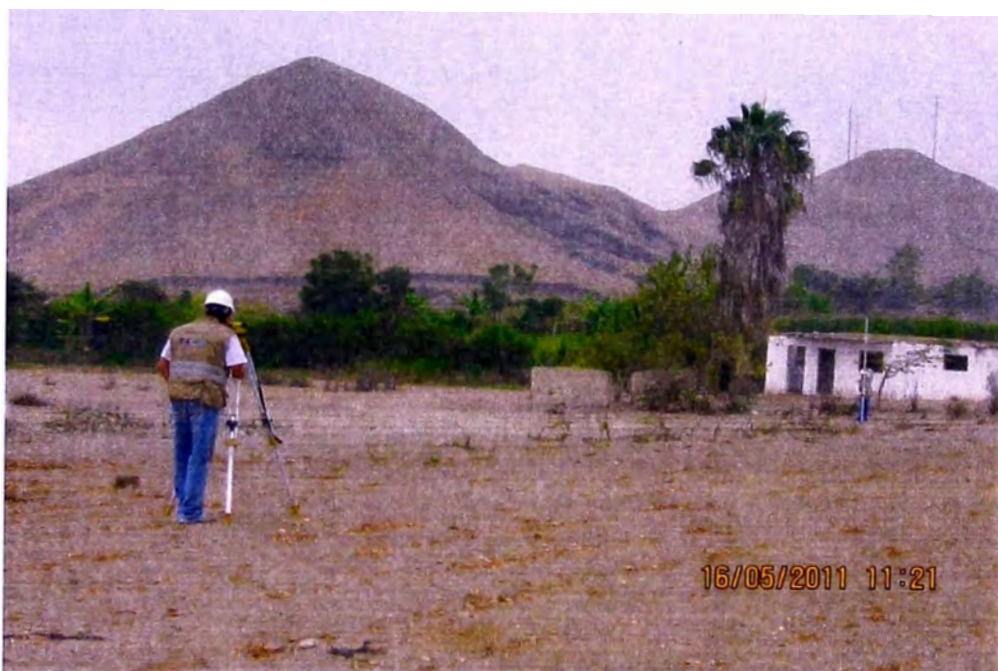
FOTON°27 UBICACIÓN DE BM11 (COTA= 223.163), SE COLOCO FIERRO FRENTA A CASA ABANDONADA EN TERRENO DE LAGUNAS DE OXIDACION
