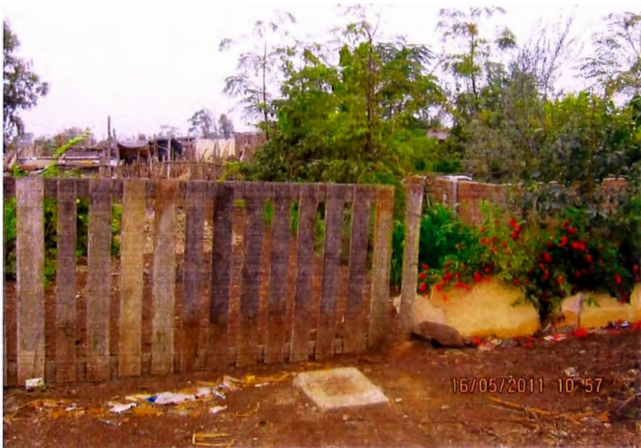
FOTON°10 UBICACIÓN DE BM3 (COTA=240.857), EN CAJA DE REGISTRO DE AGUA DE CEMENTO EN VIVIENDA UBICADA AL COSTADO DE PLANTA ELECTRICA, CALLE SAN VALENTIN A UN COSTADO DE PLANTA ELECTRICA
