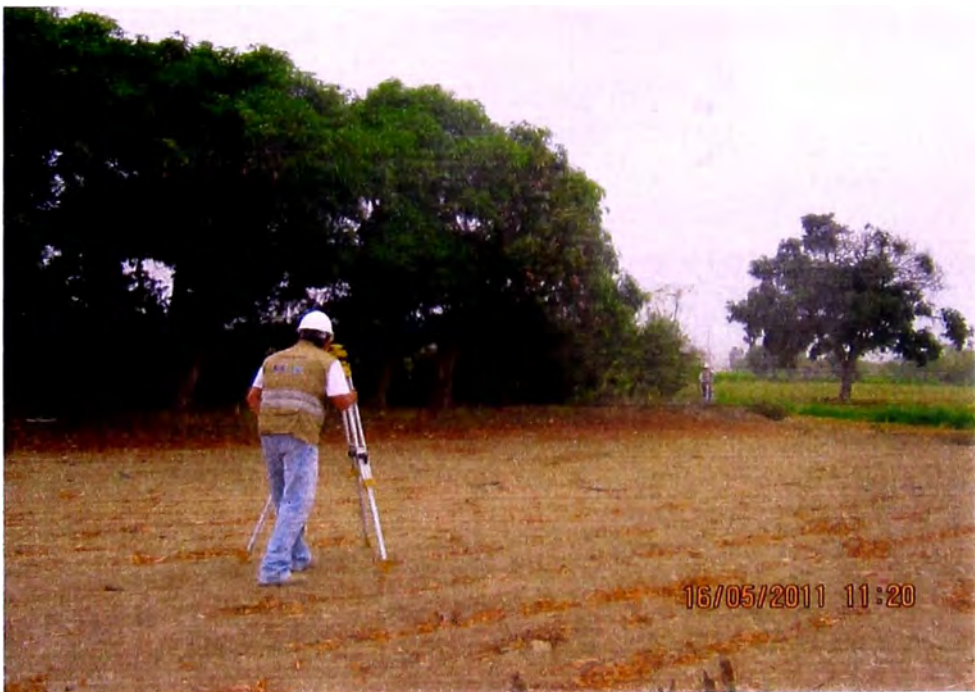
FOTON°24 UBICACIÓN DE BM10 (COTA= 225.647), ENCIMA DE CANAL DE CONCRETO AL INICIO DEL TERRENO DE LAS LAGUNAS DE OXIDACION
