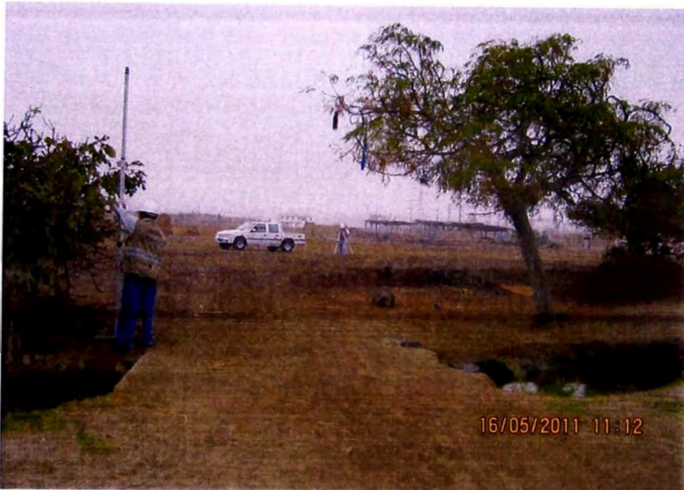
FOTON°21 UBICACIÓN DE BM9 (COTA= 236.177), SE COLOCO FIERRO AL INICIO DEL CAMINO DE PENETRACION A LAS FUTURAS LAGUNAS DE OXIDACION, A UN COSTADO DEL PUENTE
