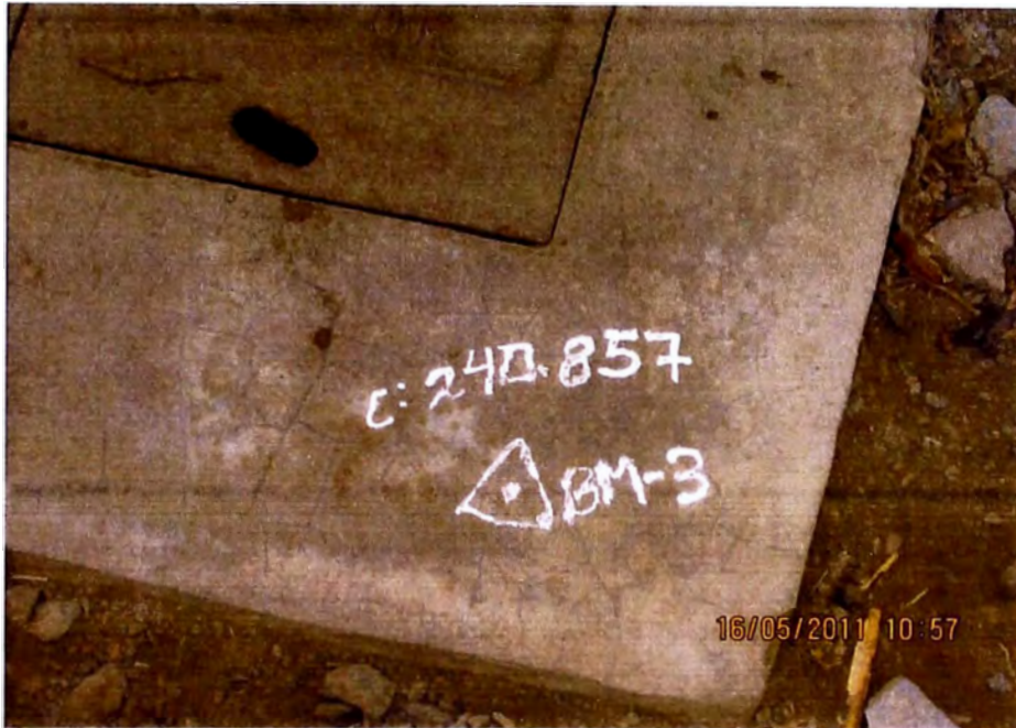
FOTON°09 UBICACIÓN DE BM3 (COTA=240.857), EN CAJA DE REGISTRO DE AGUA DE CEMENTO EN VIVIENDA UBICADA AL COSTADO DE PLANTA ELECTRICA, EN LA CALLE SAN VALENTIN
