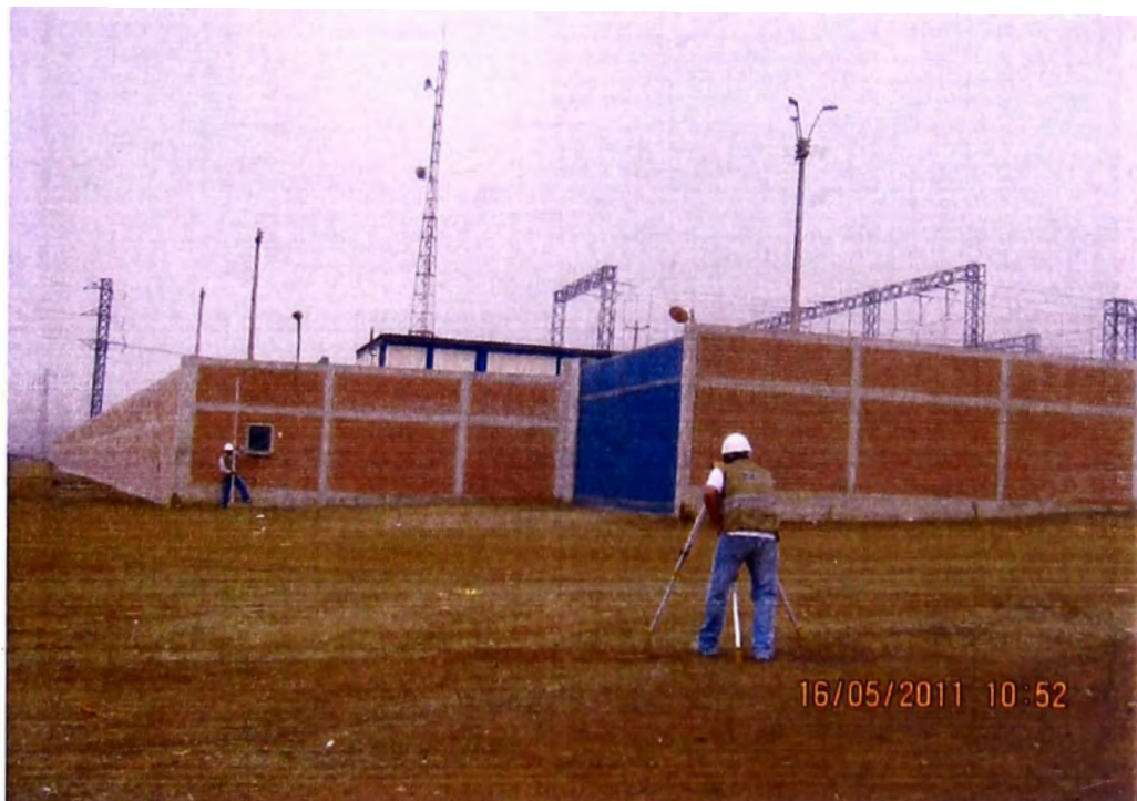
FOTON°06 UBICACIÓN DE BM2 (COTA=241.648), EN LOZA DE FACHADA DE PLANTA ELECTRICA, ENTRE LAS CALLES LOS CLAVELES Y SAN VALENTIN
