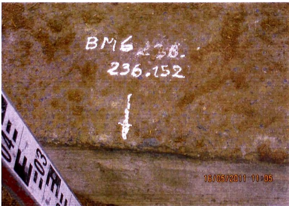
FOTON°16 UBICACIÓN DE BM6 (COTA=236.152), EN ESQUINA DE PUENTE DE CONCRETO QUE PERMITE EL INGRESO AL CENTRO POBLADO CANTERA, SE COLOCO FIERRO
