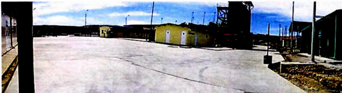
FOTONº7.- Pavimento del TRAMO 02 Y TRAMO 03
