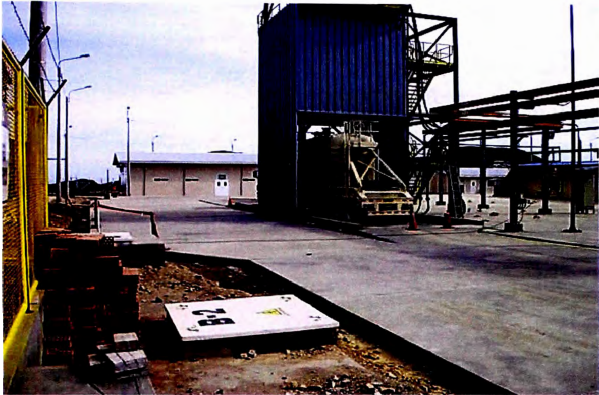
FOTONº6.- Pavimento del TRAMO 02
