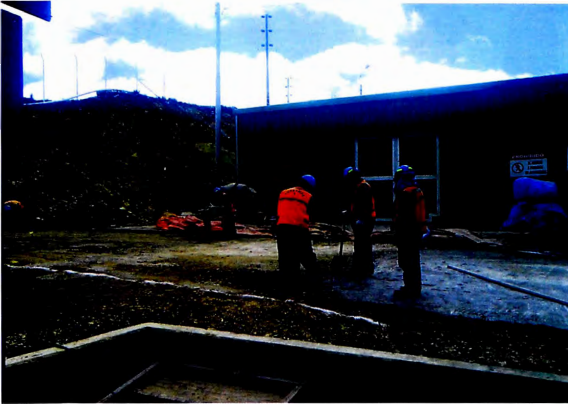
FIGURA N° 12 – ENCOFRADO DE LA LOSA A VACEAR
