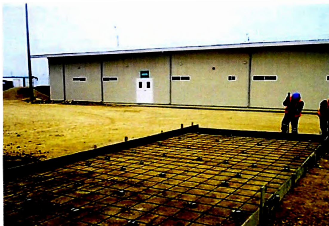
FIGURA N° 18 – COLOCACION DEL ACERO Y ENCOFRADO
