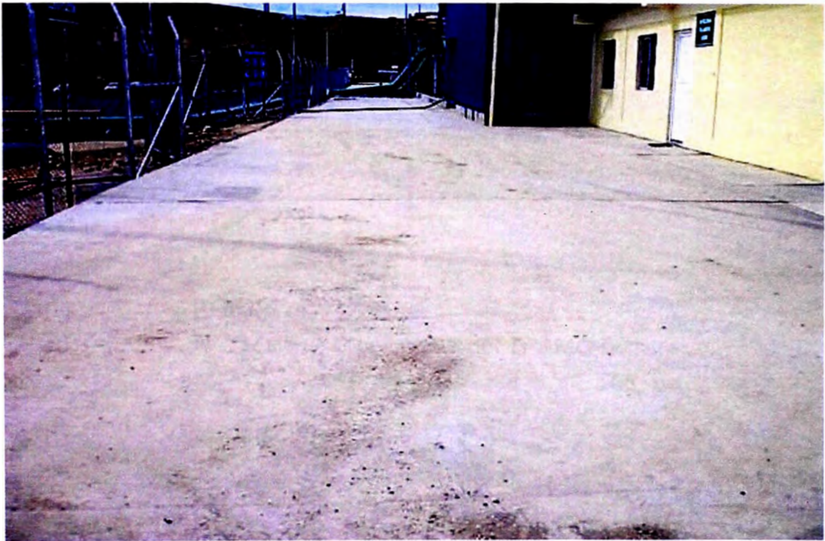
FOTONº10 .- Pavimento del TRAMO 04
