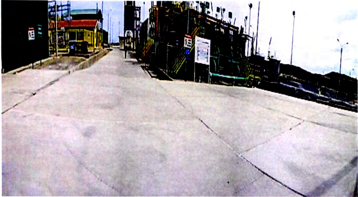
FOTONº4.- Pavimento del TRAMO 01 al TRAMO 02
