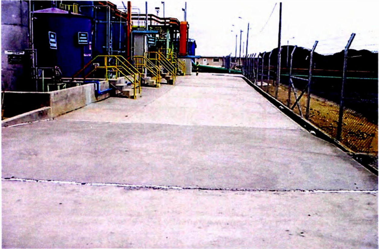
FOTONº11 .- Pavimento del TRAMO 05
