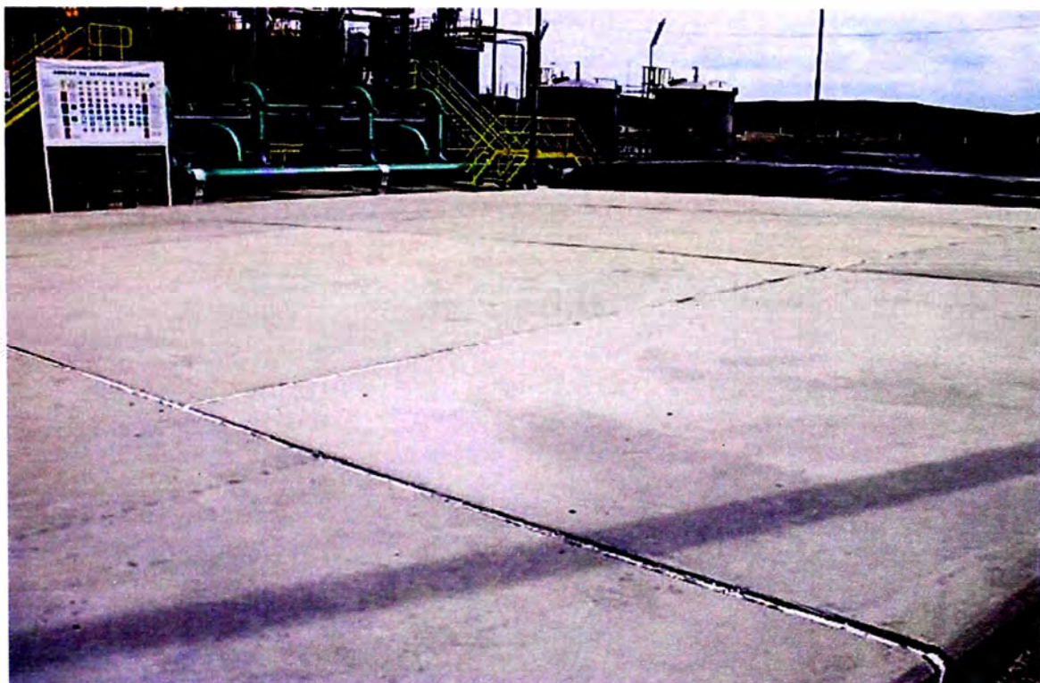
FOTON°3.- Pavimento del TRAMO 01
