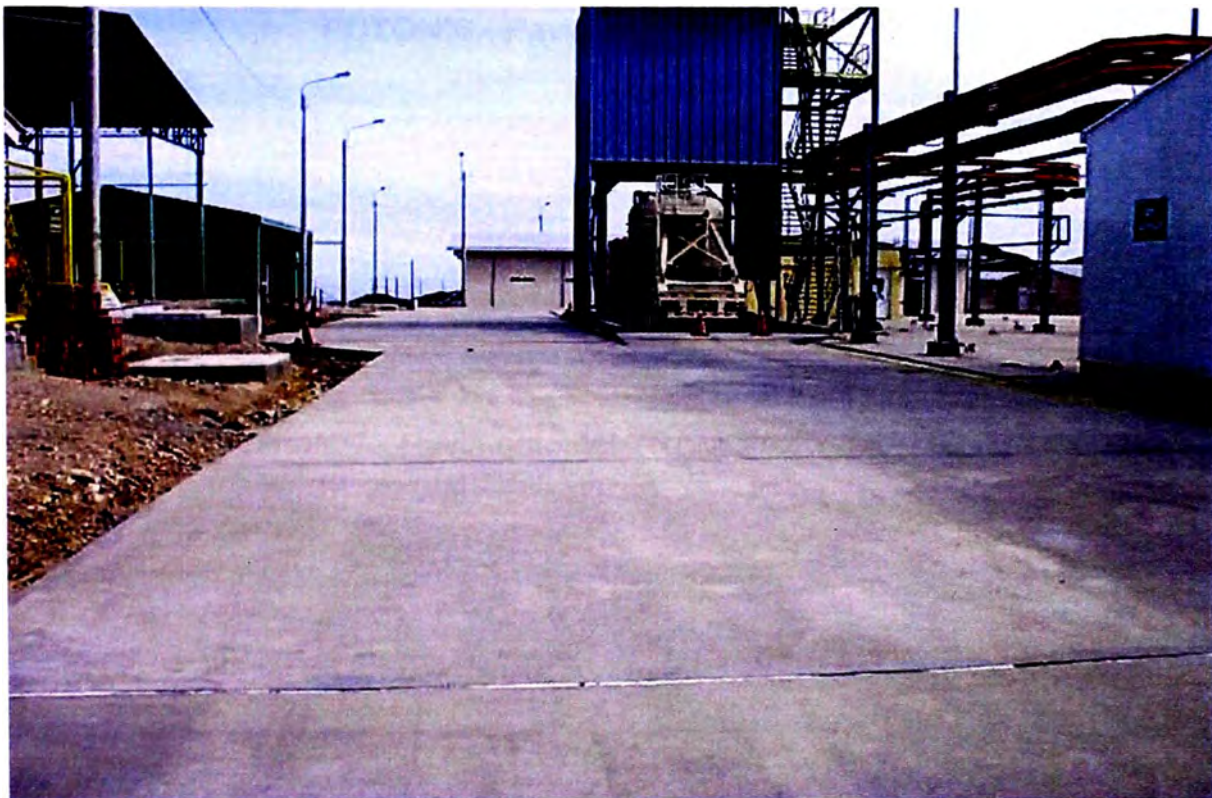
FOTONº5.- Pavimento del TRAMO 02
