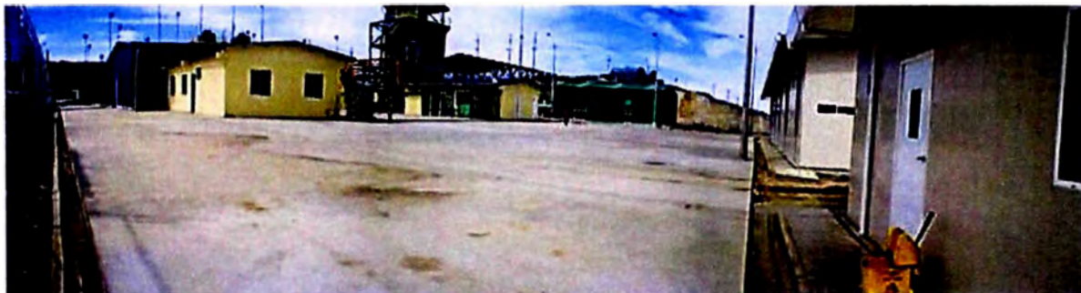
FOTONº8.- Pavimento del TRAMO 03 Y TRAMO 04
