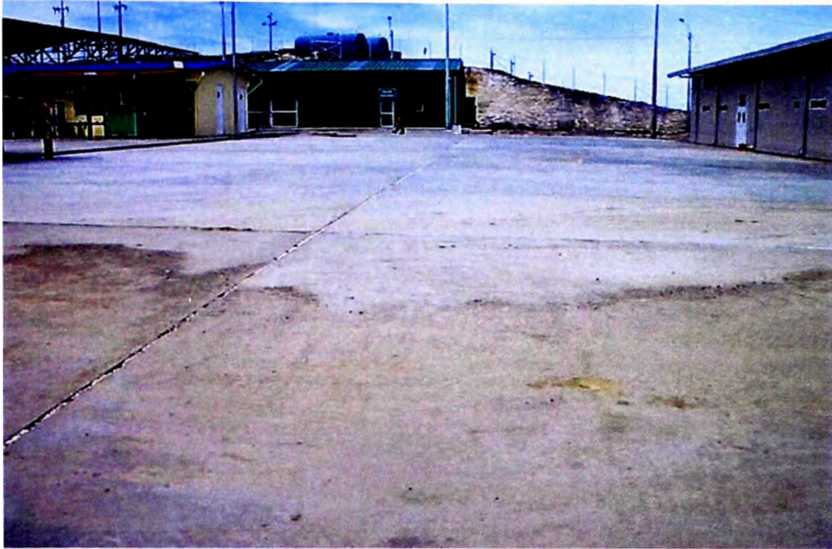
FOTONº9.- Pavimento del TRAMO 03
