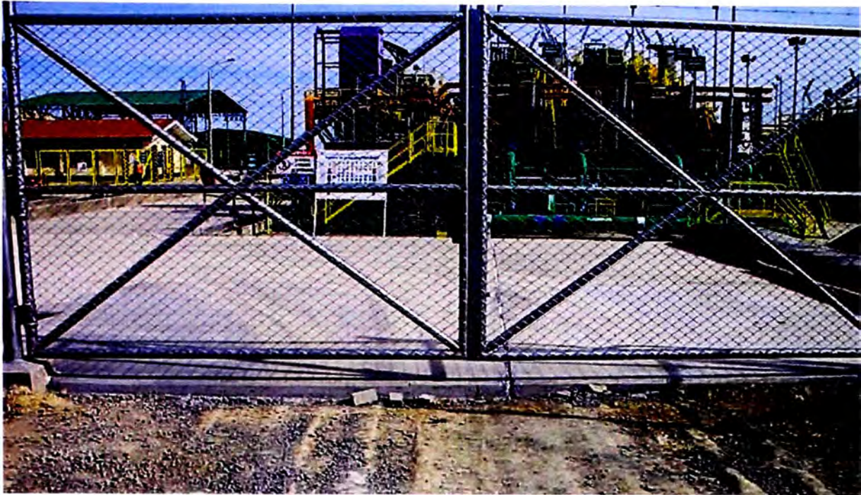
FOTO N°2.- TRAMO 01 Entrada a Planta ADR
