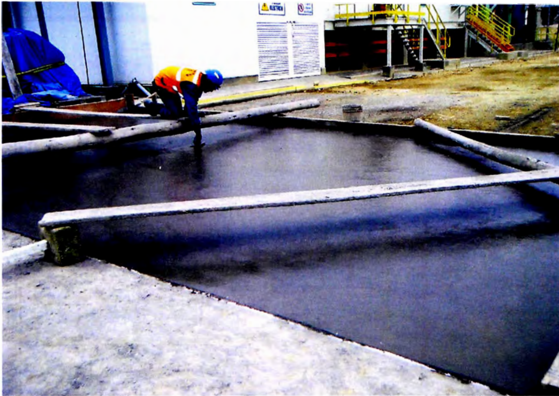
FIGURA N° 20 – CONSTRUCCION DE CUNETA DE CONCRETO
