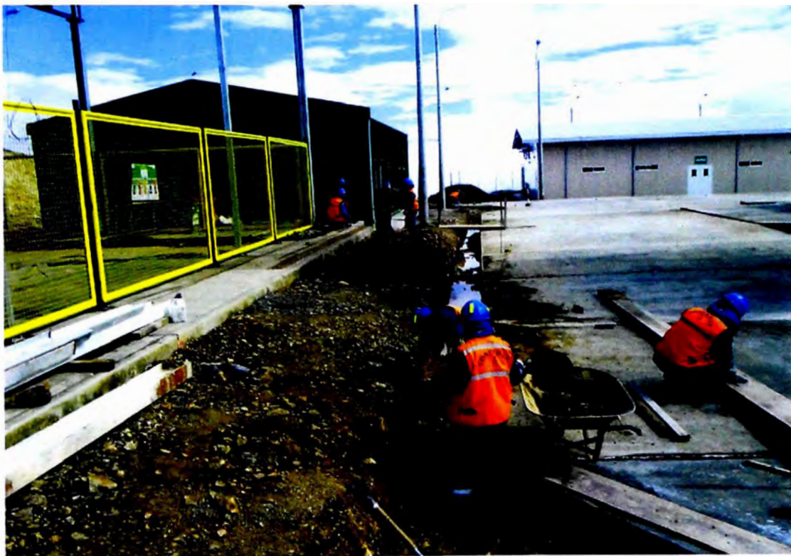
FIGURA N° 20 – CONSTRUCCION DE CUNETA DE CONCRETO
