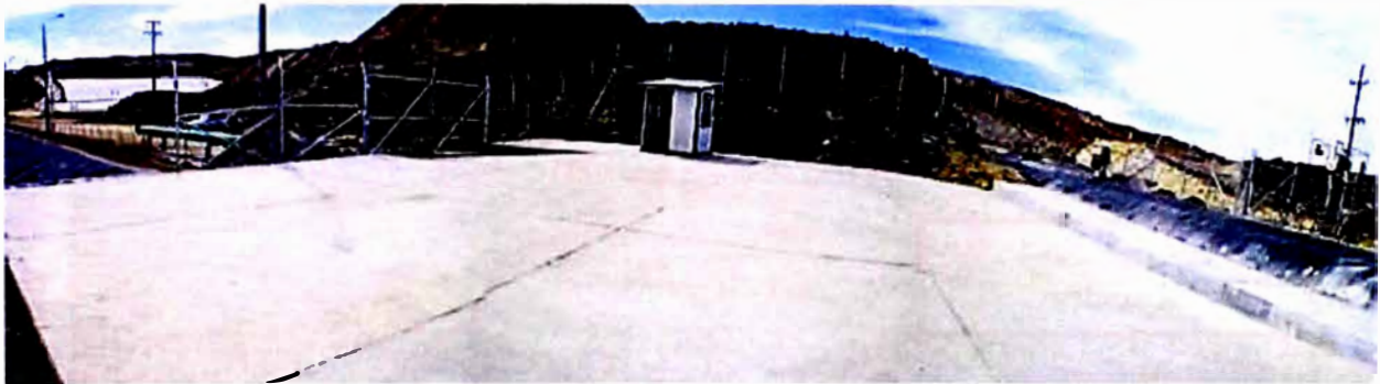
FOTONº12.- Pavimento del TRAMO 06
