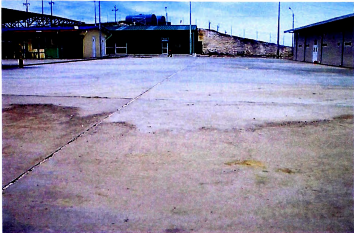
FOTONº8.- Pavimento del TRAMO 03
