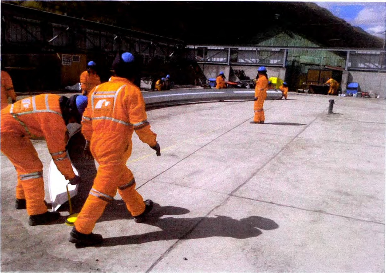
Control de cuerda y flecha de arcos
