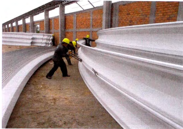
FIGURA N°4: Terceteado de arcos
