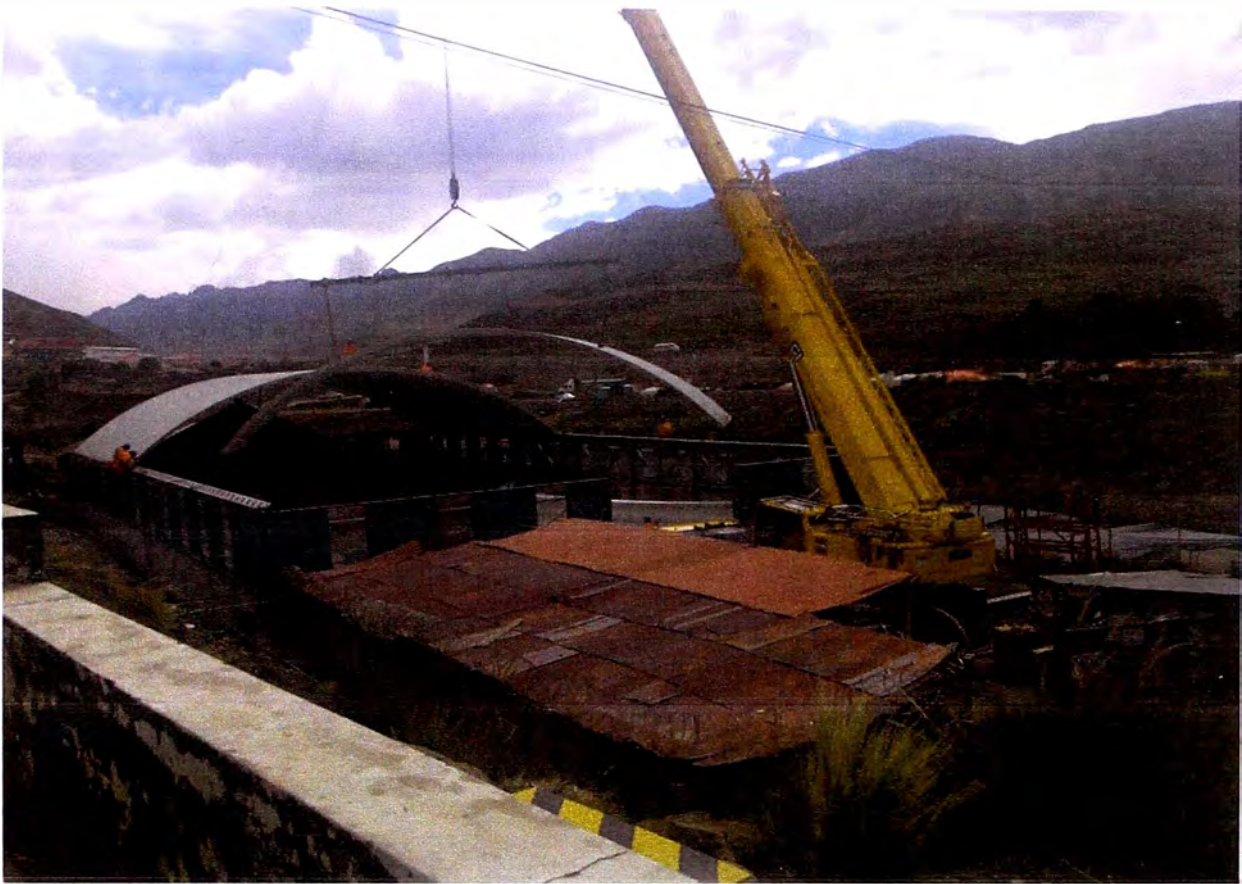
Montaje de tercetas
