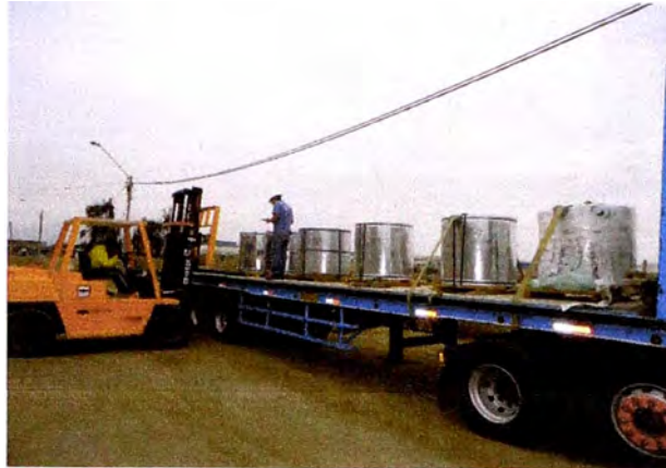
FIGURA N°1: Envío de bobinas de acero a obra
