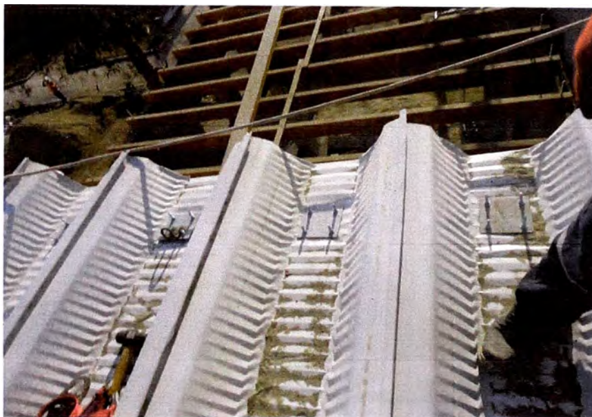
FIGURA N°7: Anclaje de tercetas en viga canal de concreto
