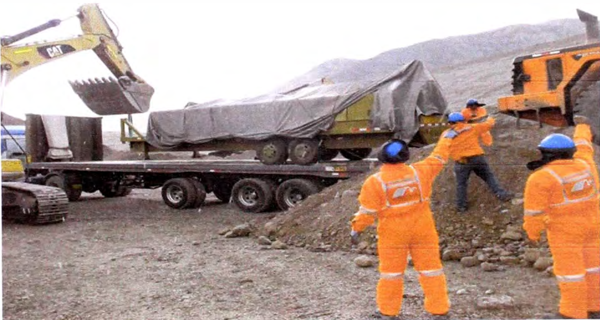
Descarga de la máquina conformadora
