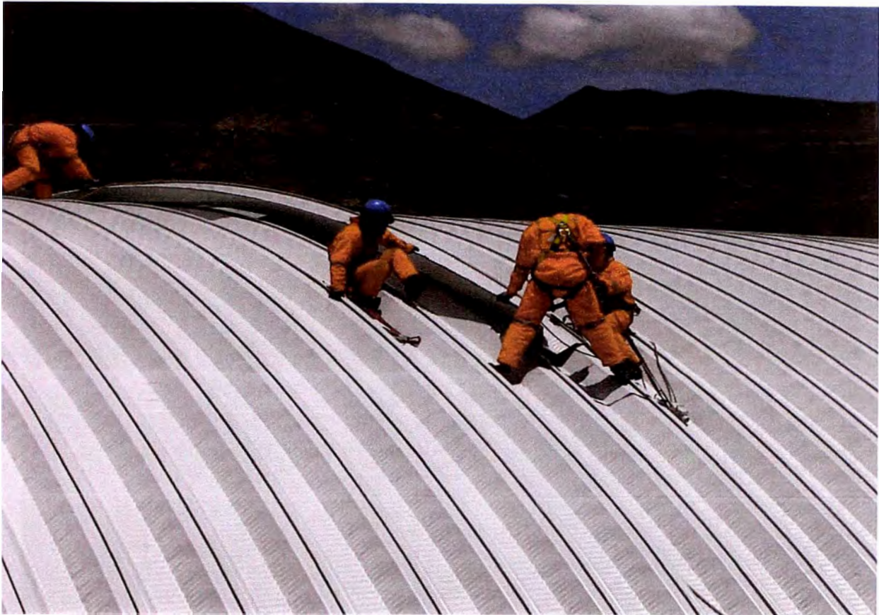
Traslado de arcos para colocación de traslúcidos
