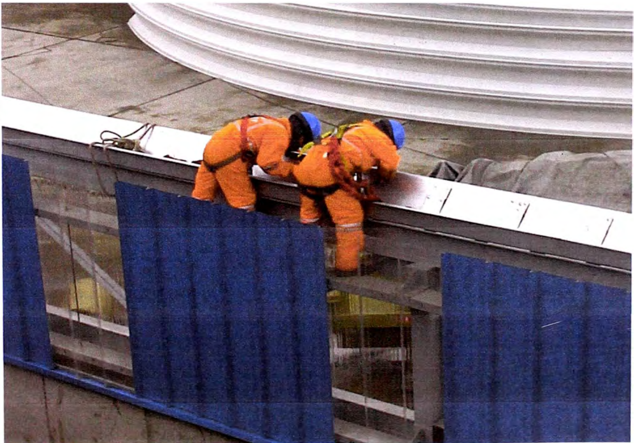
Colocación de pernos y placas
