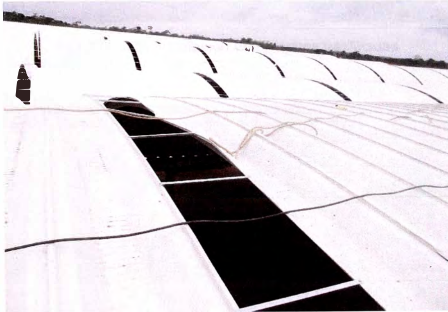
FIGURA N°8: Instalación de ángulos galvanizados
