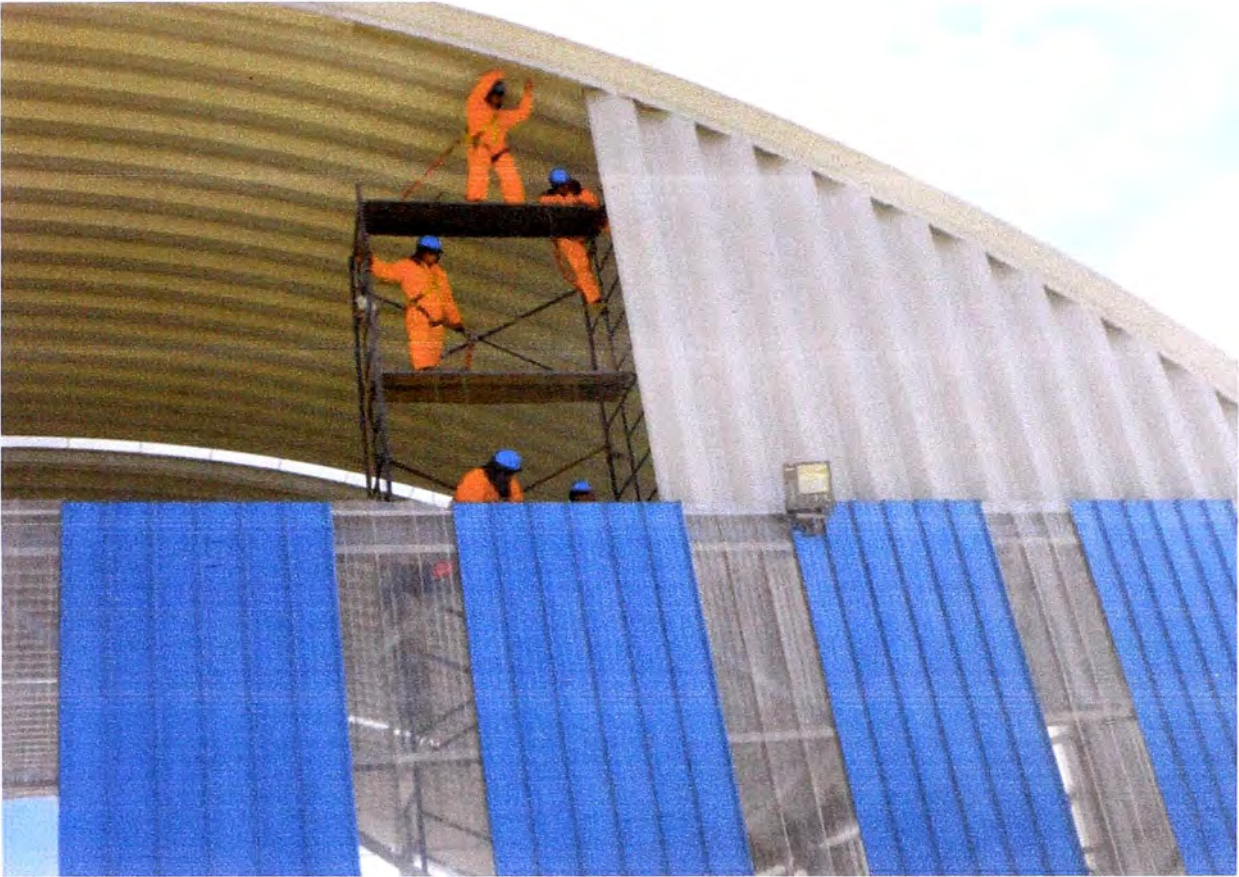
Instalación de tímpanos
