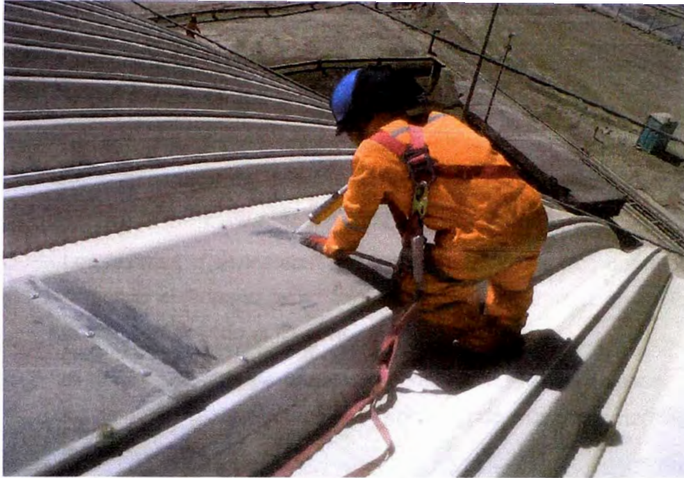
FIGURA N°9: Instalación de planchas traslúcidas
