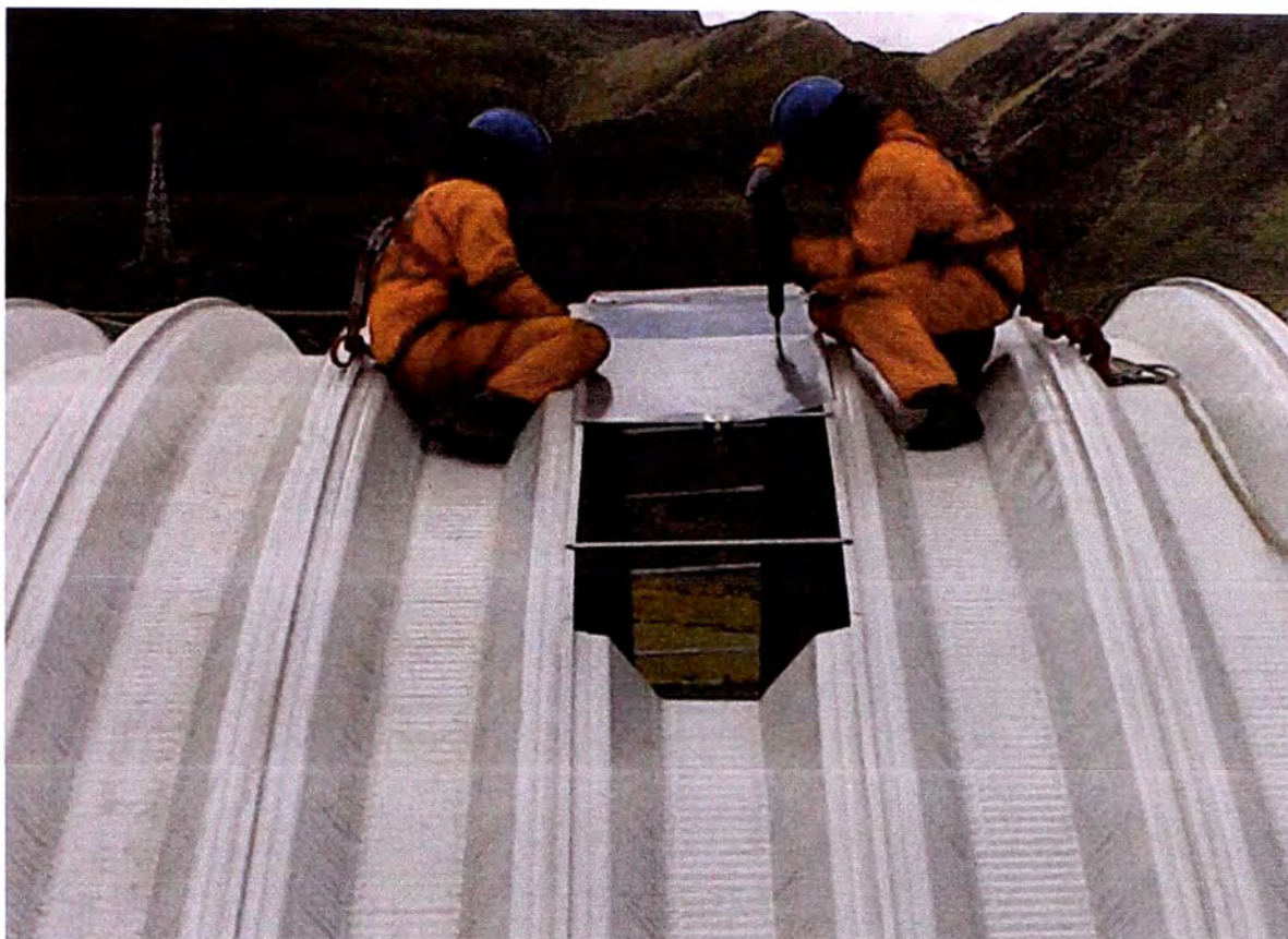
Instalación de planchas traslúcidas
