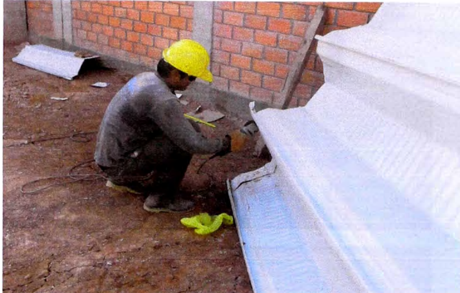
FIGURA N° 14: Corte de arcos que salieron más largos, para emparejarlos con el resto
