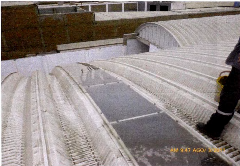
FIGURA N°10: Prueba de Agua en traslúcidos
