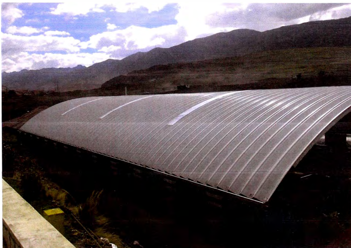
Cobertura lista para instalar los tímpanos
