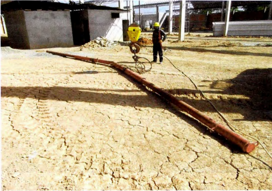
FIGURA N°16: Balancín que se dobló en pleno izaje
