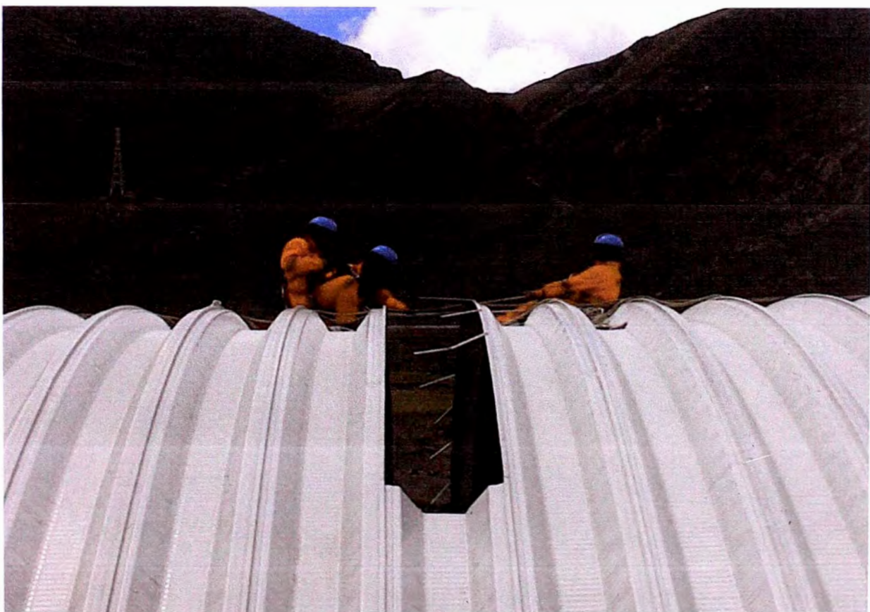
Colocación de ángulos galvanizados para traslúcidos
