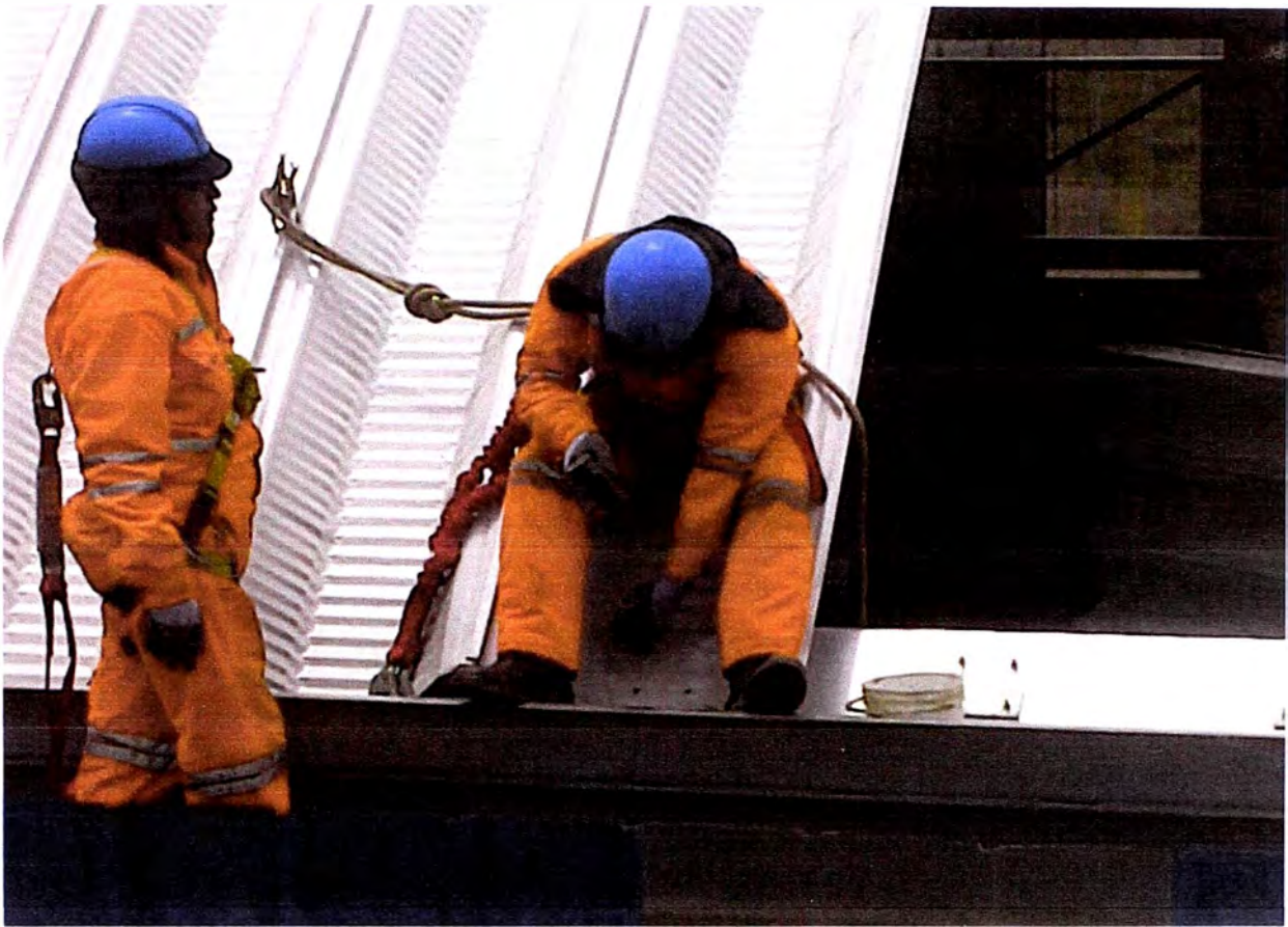
Anclaje de tercetas
