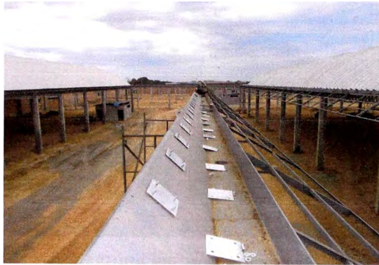
FIGURA N°5: Trazo y perforación en viga canal de acero
