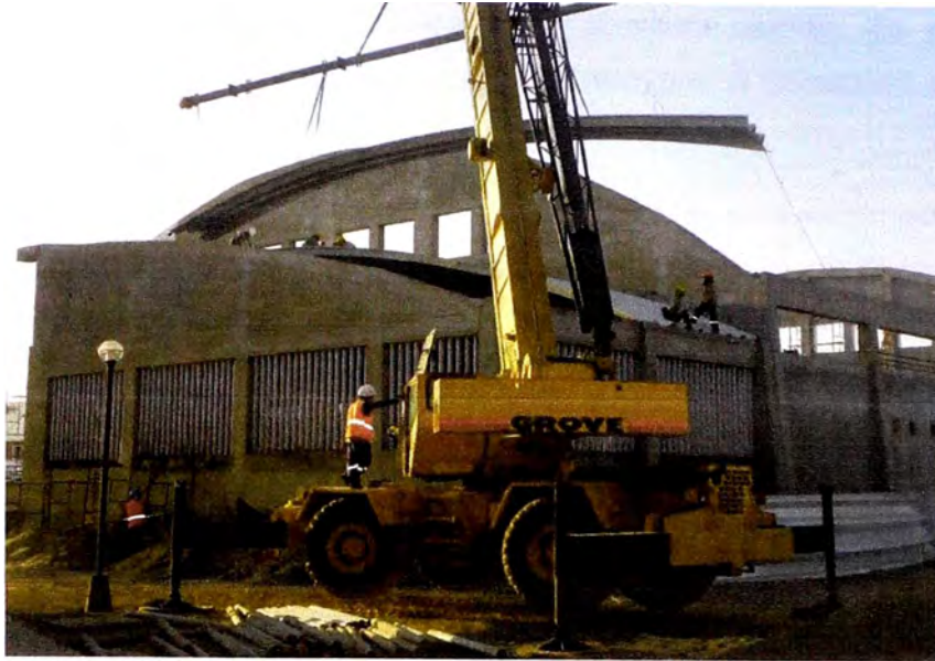
FIGURA N°6: Izaje de tercetas
