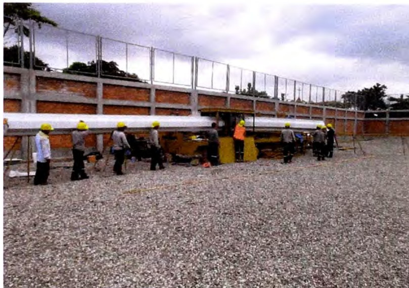
FIGURA N°3: Rolado de arcos
