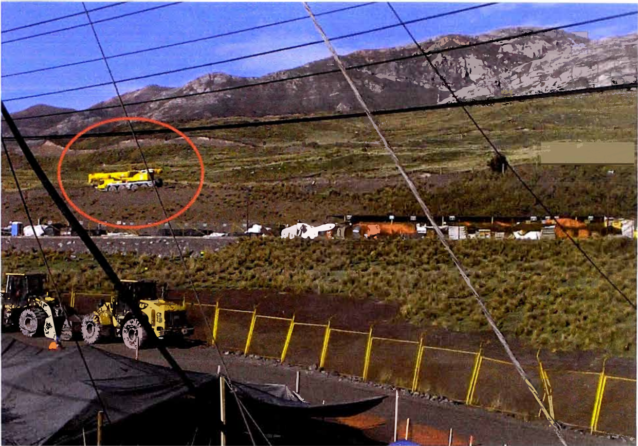
Llegada de grúa telescópica a obra
