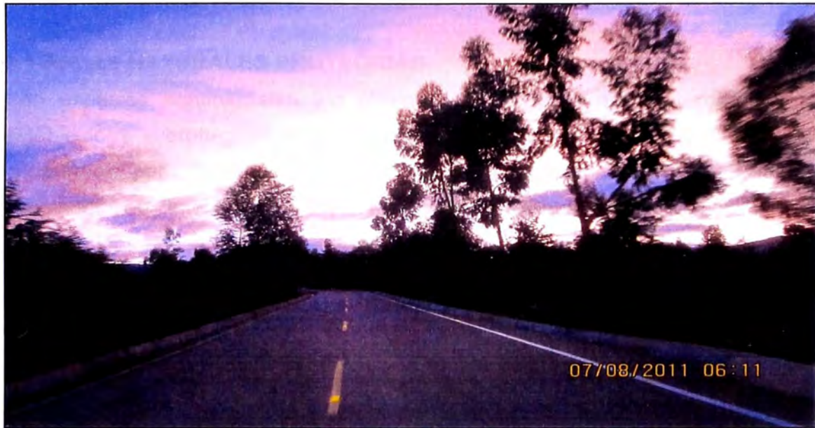
Fig.2.5 Cunetas como Sistema de drenaje del Tramo Pisco-Ayacucho
