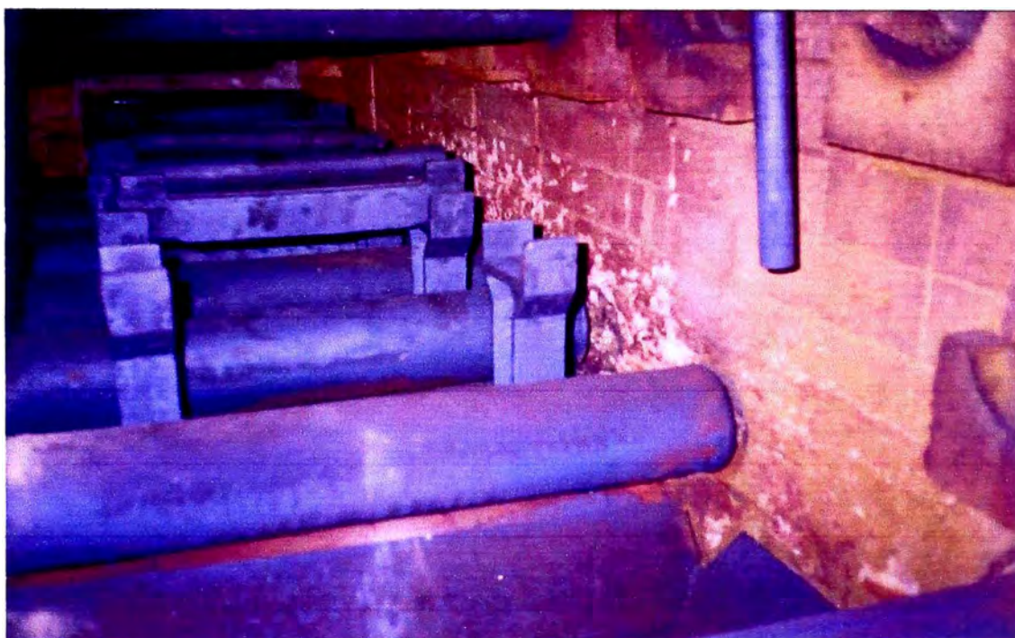
Foto 4.1 Cubierta metálica del ducto de descarga.
