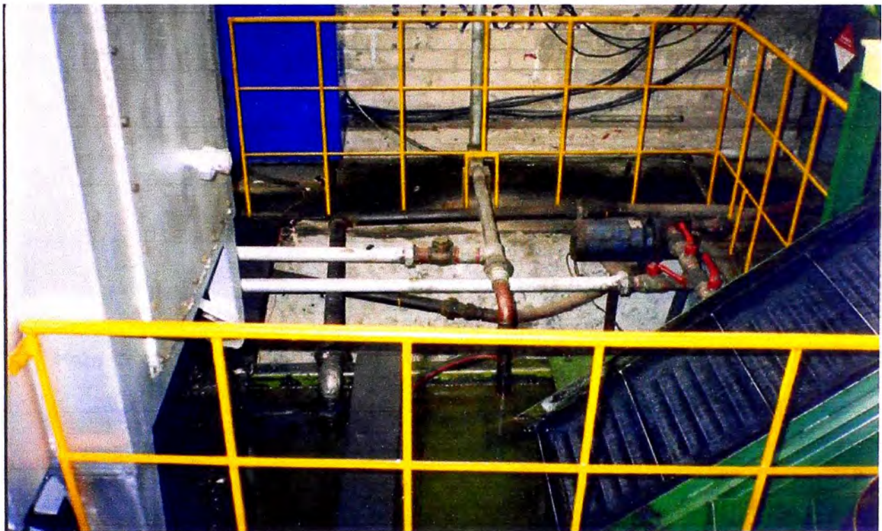
Foto 3.9 Faja transportadora a la salida del medio de temple y mostrando el anclaje al tanque.
