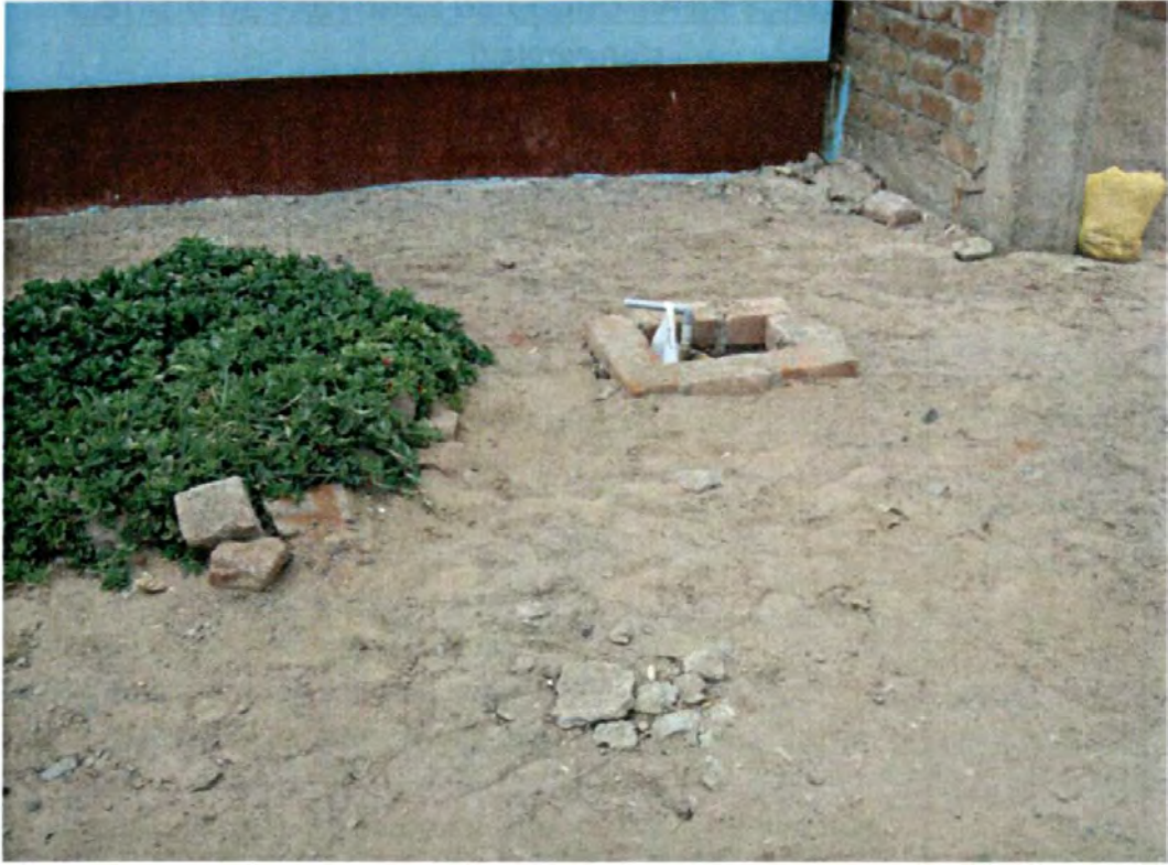
Foto N° 7: Conexiones existentes – Vista 2
