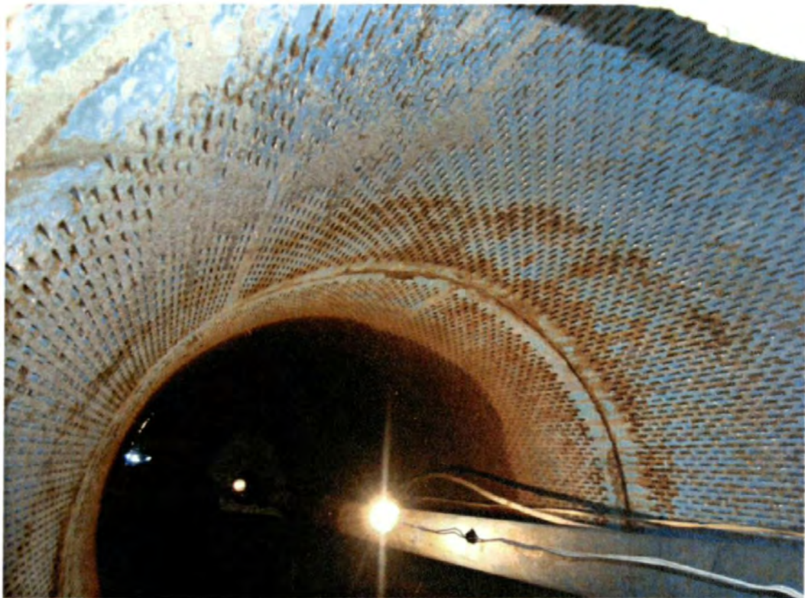
Foto N° 4: Estación de Bombeo existente – Anillo Metálico de filtración
