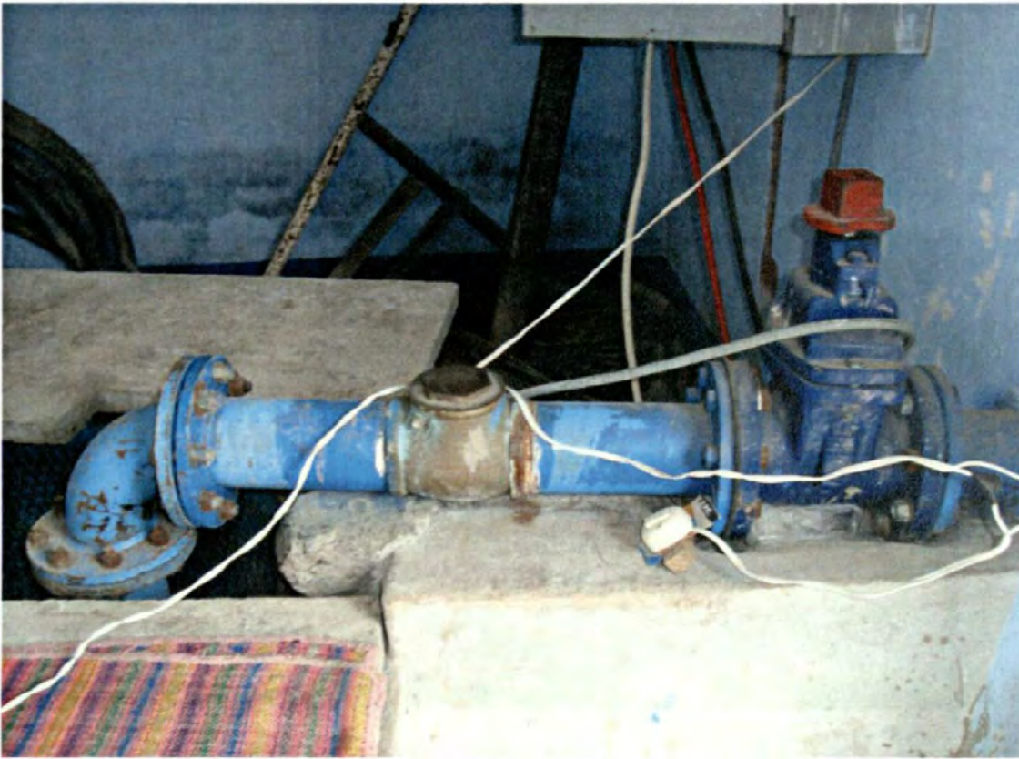
Foto N° 5: Estación de Bombeo existente – Inicio de la Línea de Impulsión
