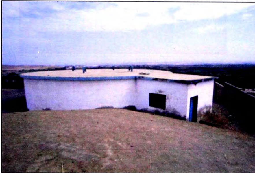
Figura 2.4: Reservorio (300 m 3 ) principal de Végueta
