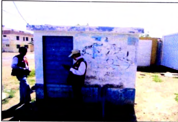
Figura 2.5: Caseta de la Estación de rebombeo enVégueta
