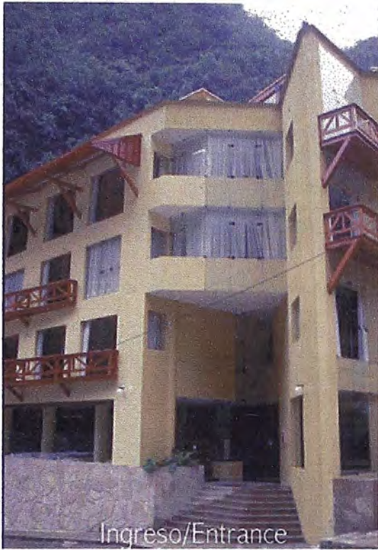
Foto 1: El ingreso principal
