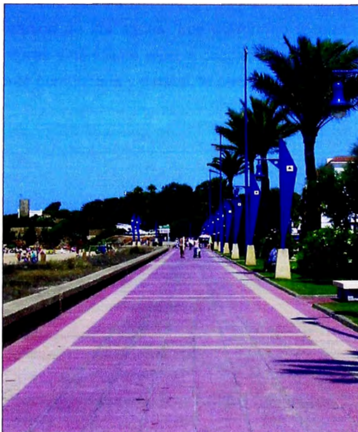
Figura 3.06. Paseo marítimo, y muros de contención.
