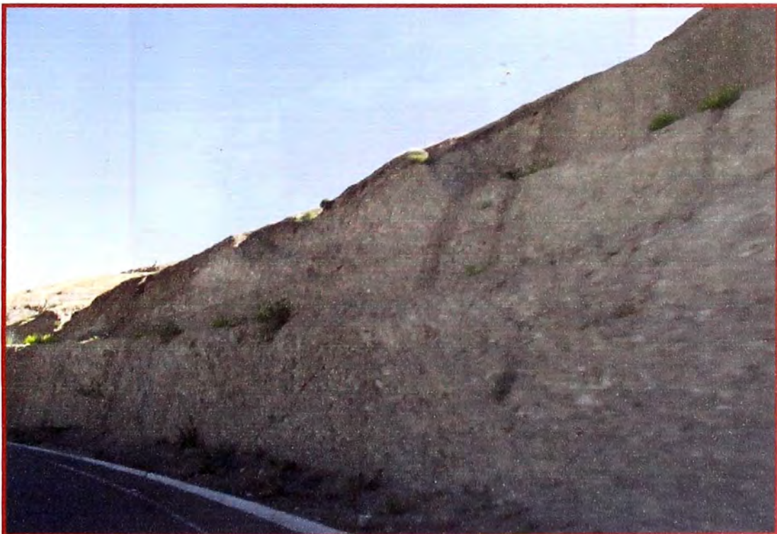
Con fines de estabilizar este talud se observa las banquetas hechas
