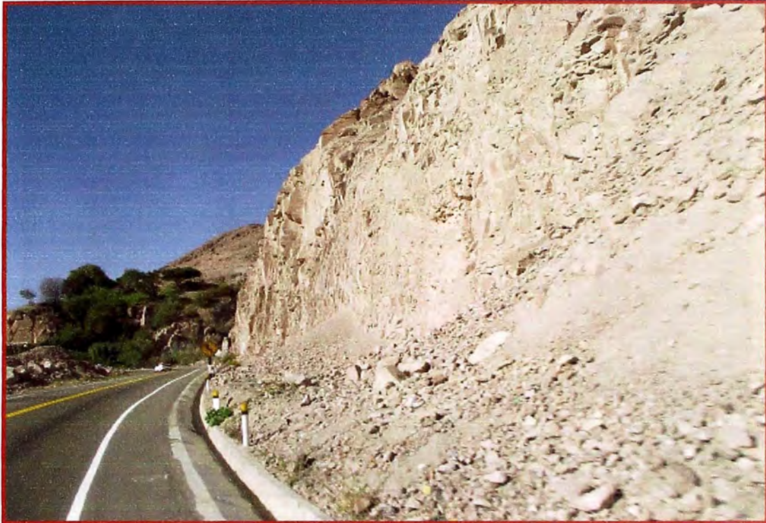
En las zonas de Samegua y Torata se observa la morfología accidentada con fuertes pendientes
