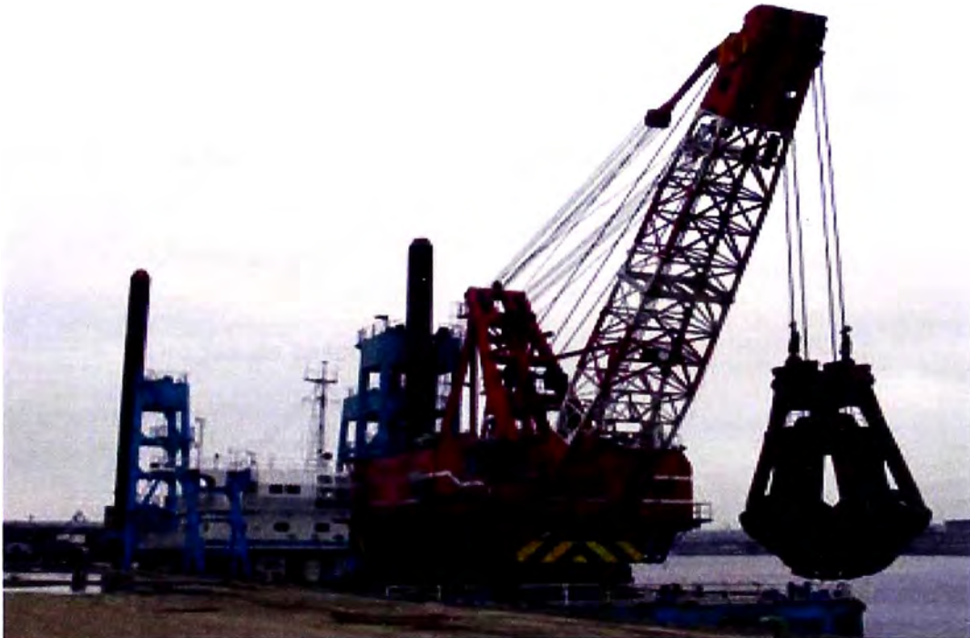
Figura N° 2.03 Draga de Jaiba o Cucharón de Almeja (Grab Dredger)
