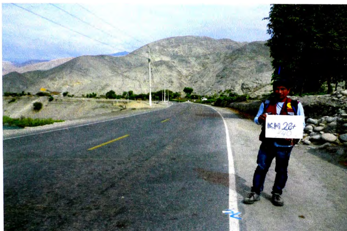
Foto 08: Se aprecia las señalizaciones horizontales, líneas discontinuas amarillas y líneas de borde blancas. En la progresiva 28+740.
