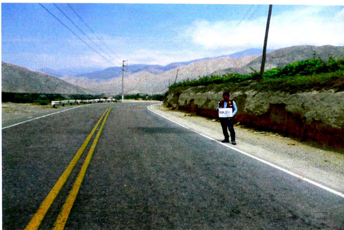
Foto 07: Señalización horizontal, donde se puede apreciar, las guardavías, las líneas continuas amarillas y las líneas de borde de color blancas en el Km 28+360.
