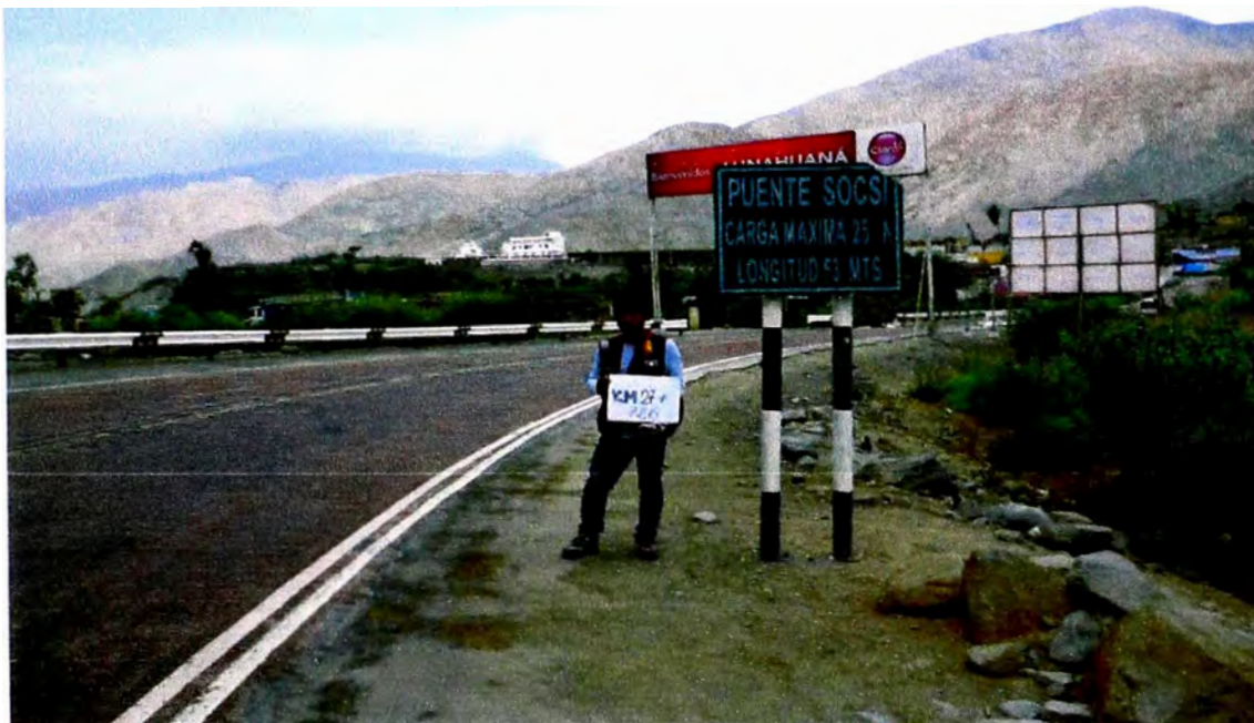
Foto 04: señalización informativa, que indica la capacidad máxima del puente, mas adelante se aprecia señalización informativas o de carácter propagandístico. En la progresiva 27+726.
