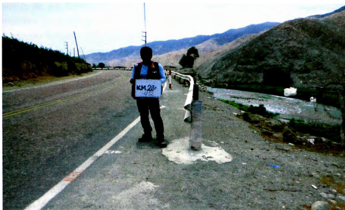
Foto N°2.4 Señalización horizontal de líneas de borde en el pavimento, KM 28+412.
