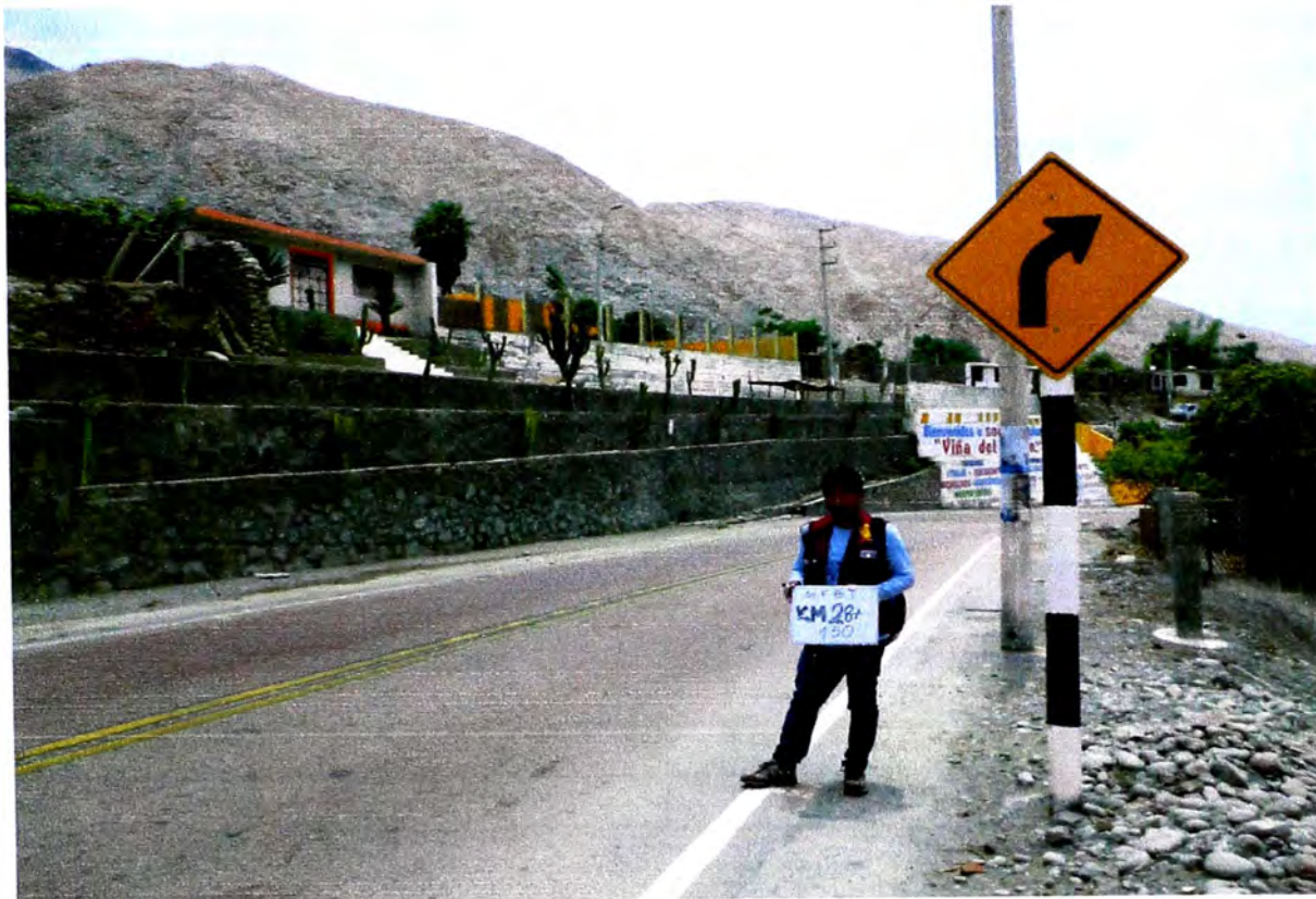
Foto N°2.1, Señalizaciones vertical en el KM 28+150 de la vía en estudio.
