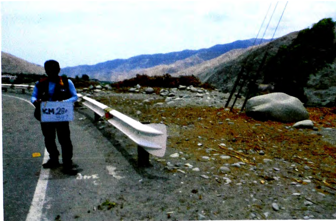
Foto 06: se aprecia un fin de guardavía en la progresiva 28+341.
