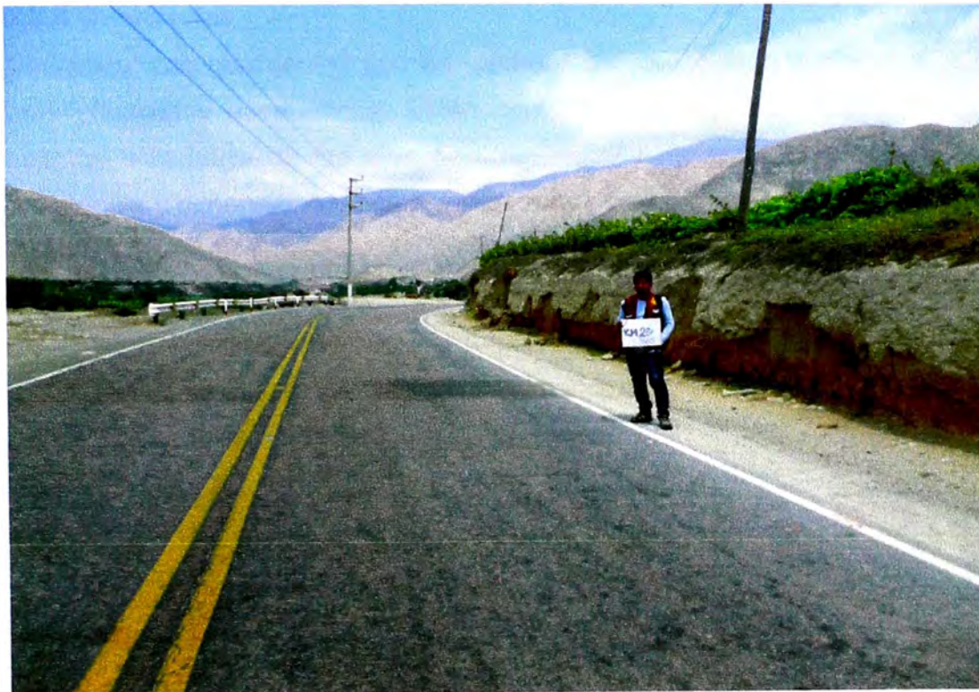
Foto N°2.3 Señalización horizontal de doble líneas en el pavimento, KM 28+360.
