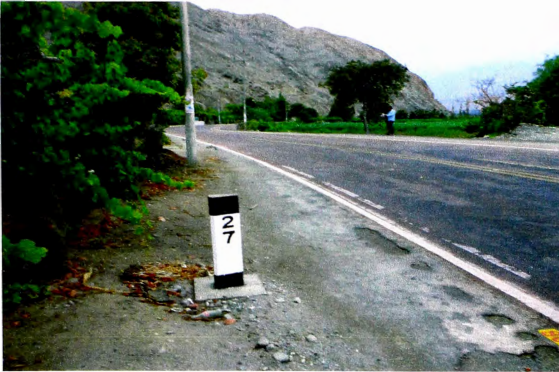
Foto 09: Se aprecia el Hito kilométrico en la ubicación km 27, la cual se encuentra en buen estado. También se puede apreciar la doble línea de borde, esta es de corrección como se puede apreciar.
