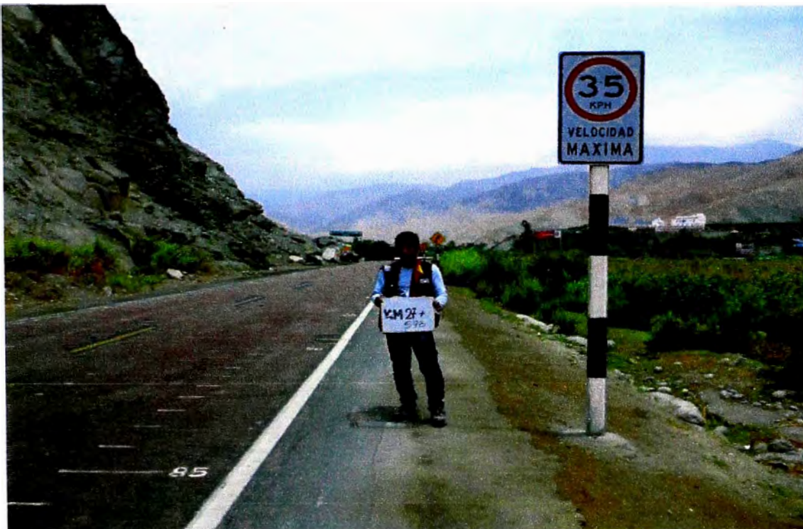
Foto 02: señalización reglamentaria R-30, señal velocidad máxima, se utiliza para recordar al usuario de la vía que solo esta permitido dicha velocidad máxima. Ubicada en la progresiva 27+593.
