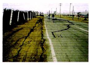
Foto 2.17 Efecto del sismo del 15/08/2,007. En la Antigua Panamericana Sur, el nivel freático cercano a la superficie contribuyo a la falla del Pavimento.
