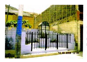
Foto 2.23 Parte lateral de una vivienda de 2 pisos de adobe y quincha, en la cual se observa el Estado actual de la madera, el carrizo y el adobe que ha ido perdiendo el recubrimiento Por efectos del clima, el tiempo, la humedad y los sismos de las últimas décadas.
