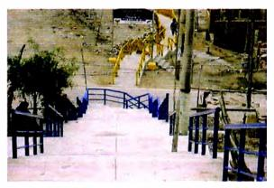
Foto 3.31 Construcción de Escaleras para el Mejoramiento de las Condiciones de Transitabilidad Peatonal en el A.H. José Olaya Balandra II-Chorrillos. Fuente: Elaboración Propia.
