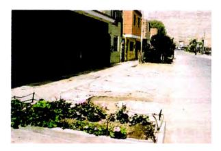
Foto 4.2 Veredas construidas por sus propios moradores de una manera artesanal sin ningún aspecto técnico y alineamiento.
