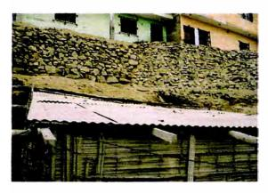
Foto 2.25 La existencia de pircas ejecutadas sin ninguna dirección técnica en los diferentes asentamientos humanos pone en riesgo las construcciones de viviendas. Las cuales son realizadas por auto construcción.
