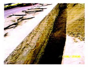
Foto 2.13 Corte realizado cerca al ovalo de la curva, para canalización de una empresa de servicios; podemos observar los estratos de arena limosa, arcilla y material Subredondeado, grava mal graduada. Fuente: Elaboración Propia.
