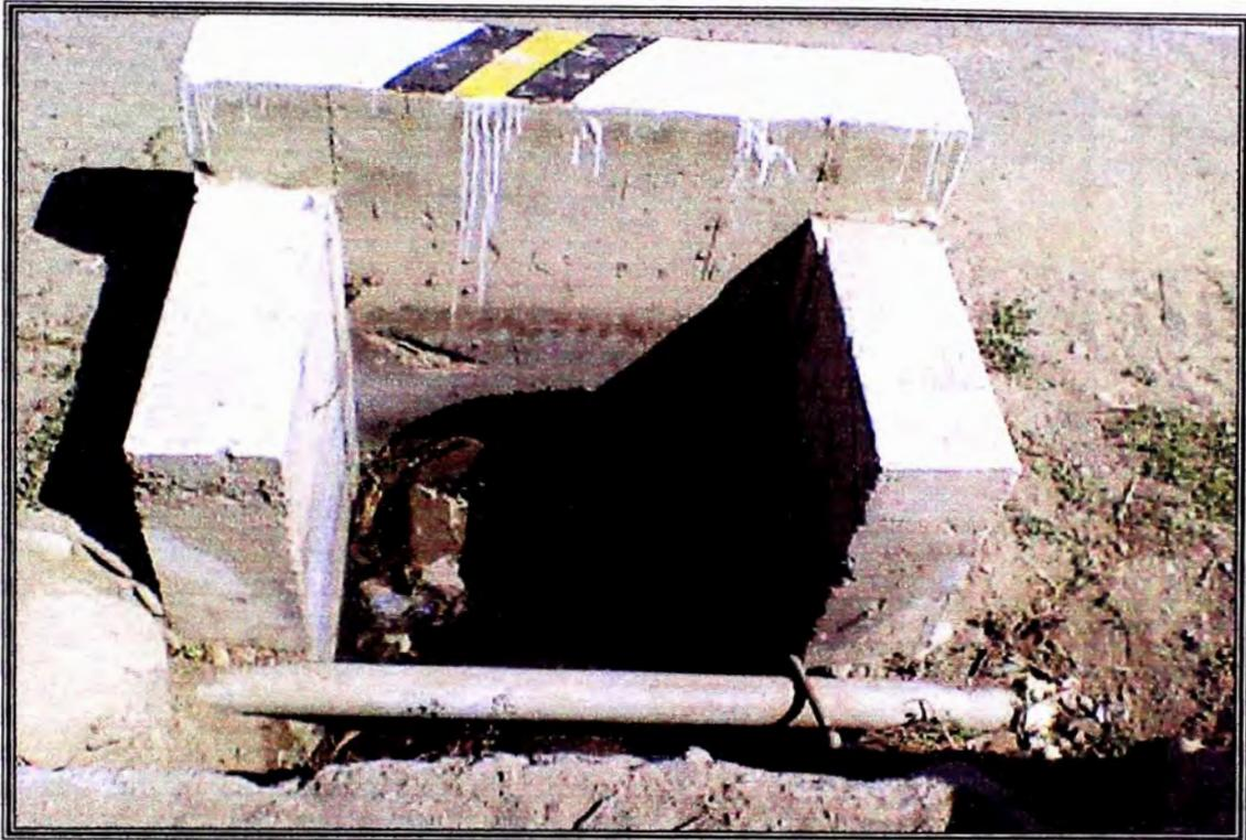
**Foto N° 10:** Conexiones artesanales existentes en la actualidad, los cuales ocasionan fugas de agua y pérdidas de presión afectando la red de agua potable.
