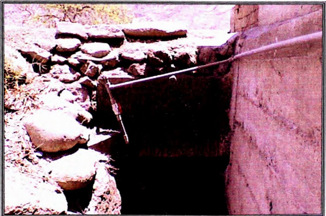
**Foto N° 11:** Se observa las conexiones domiciliarias que pasan por la parte interior de las alcantarillas de la carretera.
