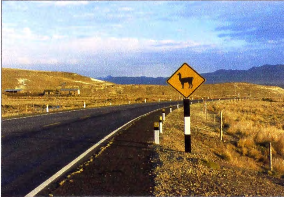
Figura 5.10.- Señalización preventiva asociada al cruce de animales en la Carretera Ilo-Desaguadero (Fuente propia)
