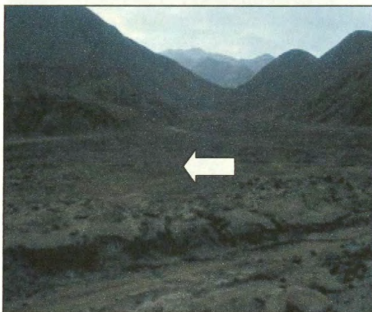
Foto N° 2: Cantera Lúcumo km 27+700, acceso a 2600 metros, lado izquierdo, potencia 63,919.94 m 3 , uso relleno.
