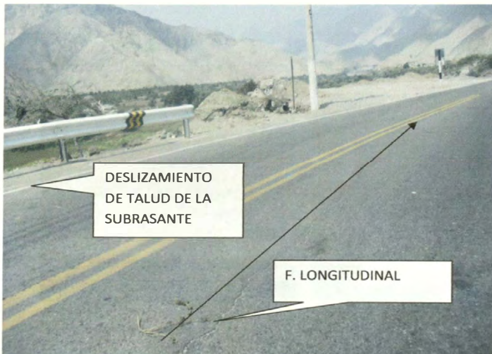
Foto N° 9: Progresiva 28+420 km, detalle de la ubicación de fisura longitudinal, nivel de gravedad alto.
