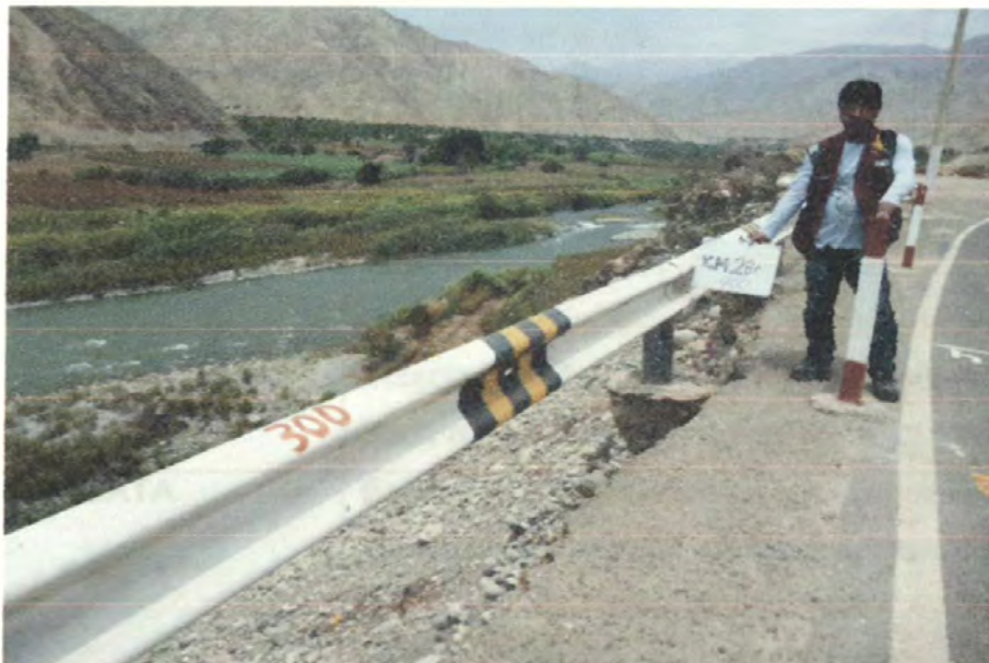
Figura N° 3.05: Erosión de talud.
