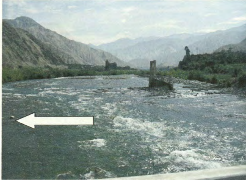
Foto N° 5: Fuente de agua km 27+780, acceso a 40 m., lado izquierdo, los valores de cloruros están encima de los admisibles.
