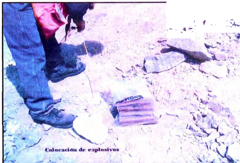
Foto N°2.1: Colocación de explosivos en cantera.
