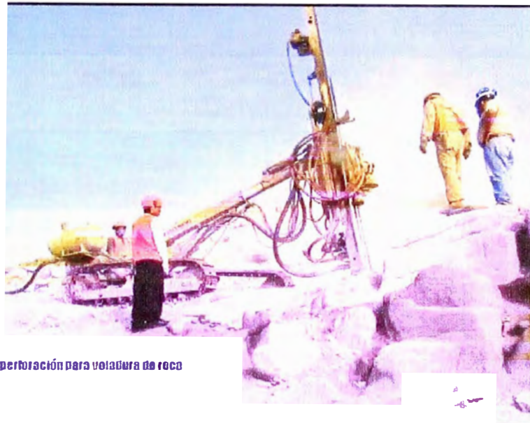
Foto N°2.2: Trabajos de perforación para voladura de roca.
