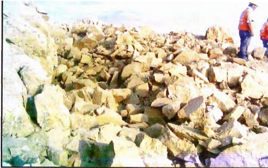
Vista del material obtenido con la primera voladura
