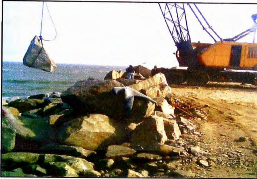
Foto N°2.5: Izaje y colocación de roca en cuerpo de escollera.
