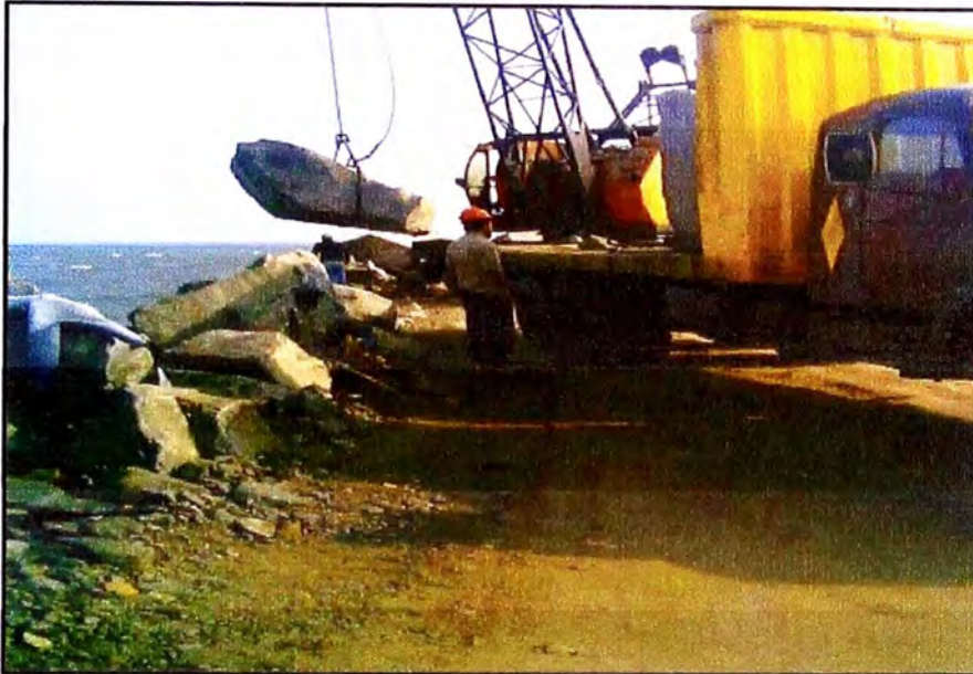
Foto N°2.4: Colocación de roca en cuerpo de escollera.
