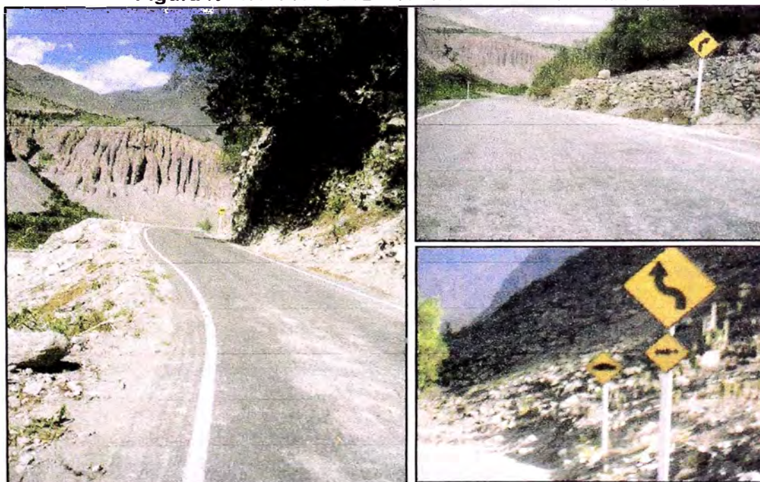
Figura N° 1.13: Km. 102 – Km. 104 Señales de tránsito
