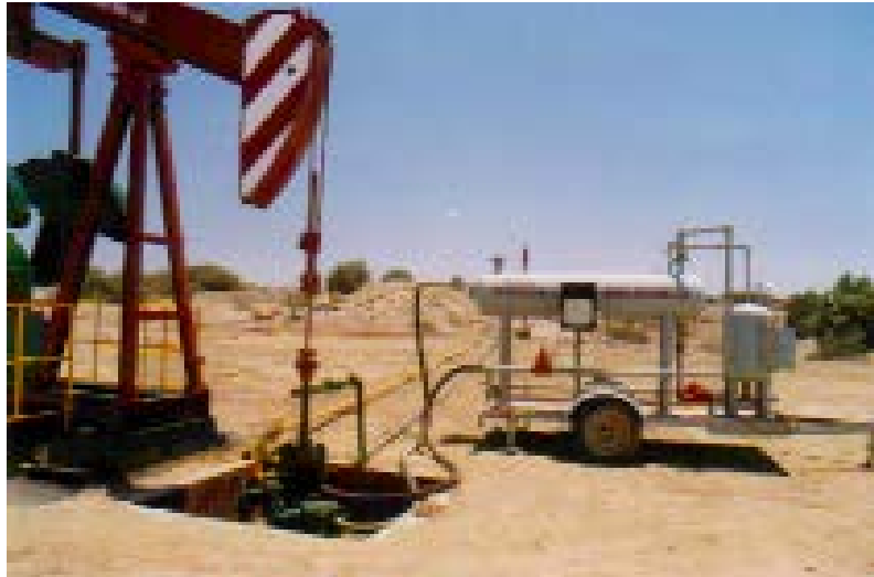
Figura 11.- Equipo portátil para medición de fluidos
