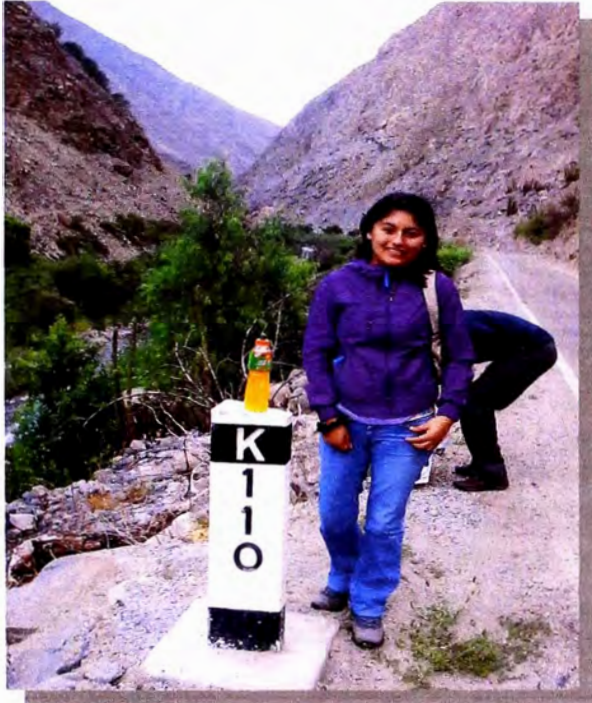
Figura 3.4: km.110 Carretera Cañete -Huancayo
