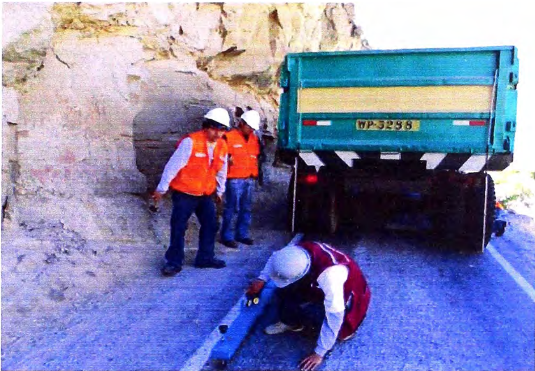
Imagen No 3: Se puede apreciar el ancho de la vía de 2.50m en el Km 115+200
