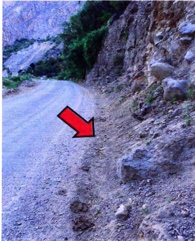
Imagen No 5: Estado actual de las cunetas tramo; Km 114 - 115
