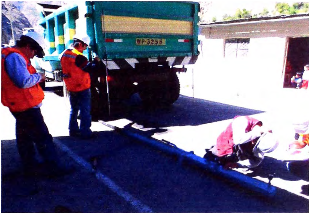
Imagen No 1: Se aprecia la manera de medir y tomar datos para el ensayo de deflexiones. Km 114+500
