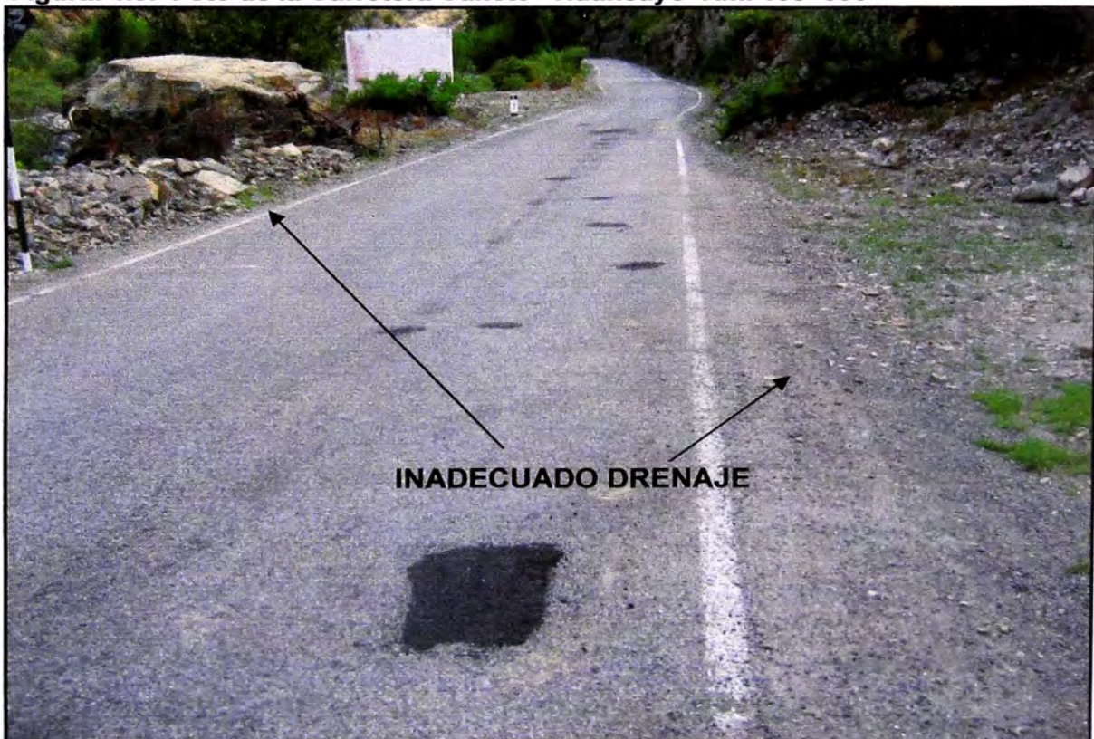
Figura: 1.5. Foto de la Carretera Cañete –Huancayo Km. 105+000
