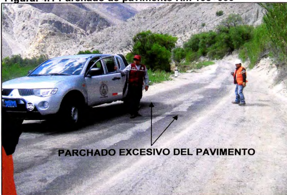
Figura: 4.1 Parchado de pavimento Km 105+000
