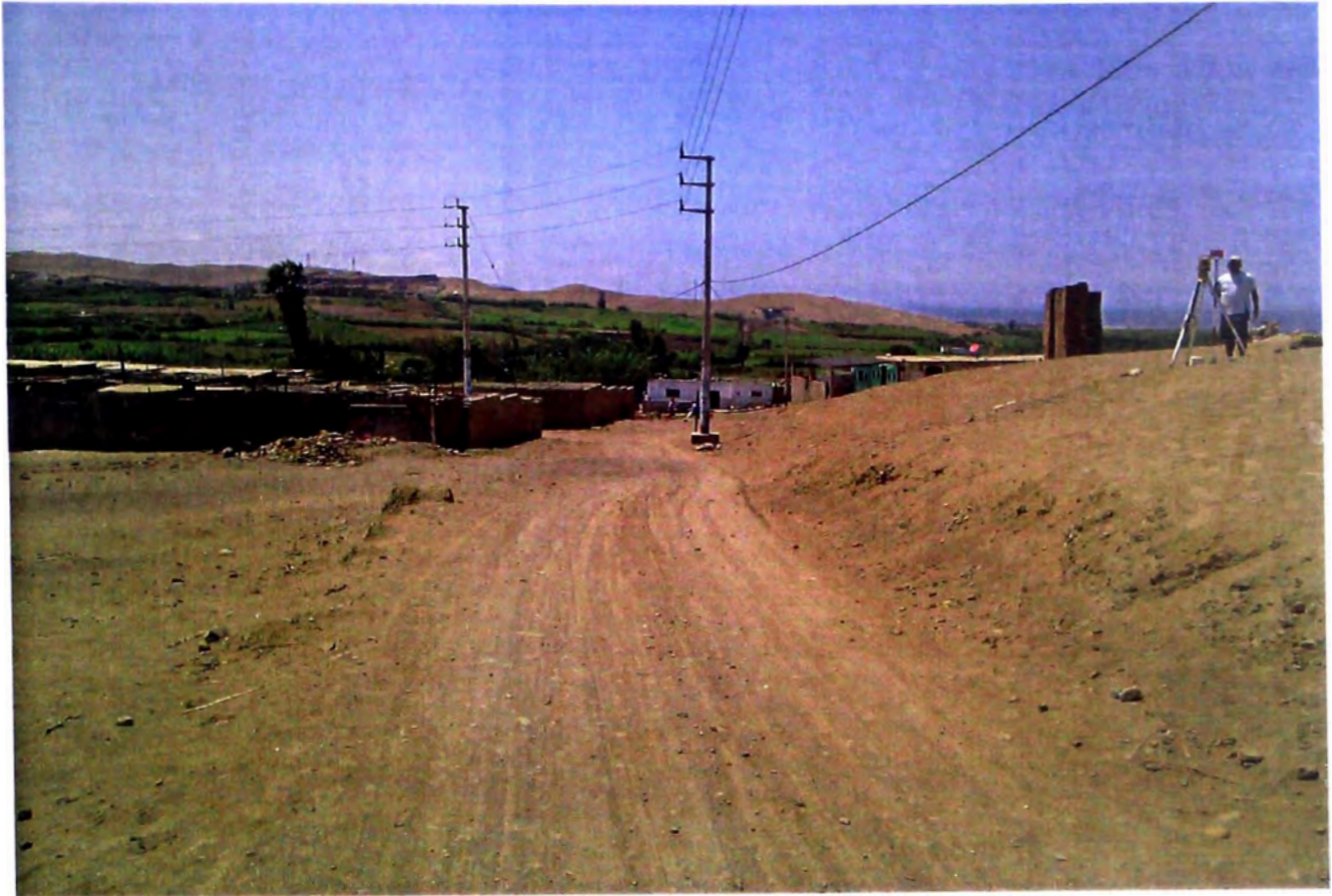
Foto N°3: Levantamiento Topográfico – Estación total
