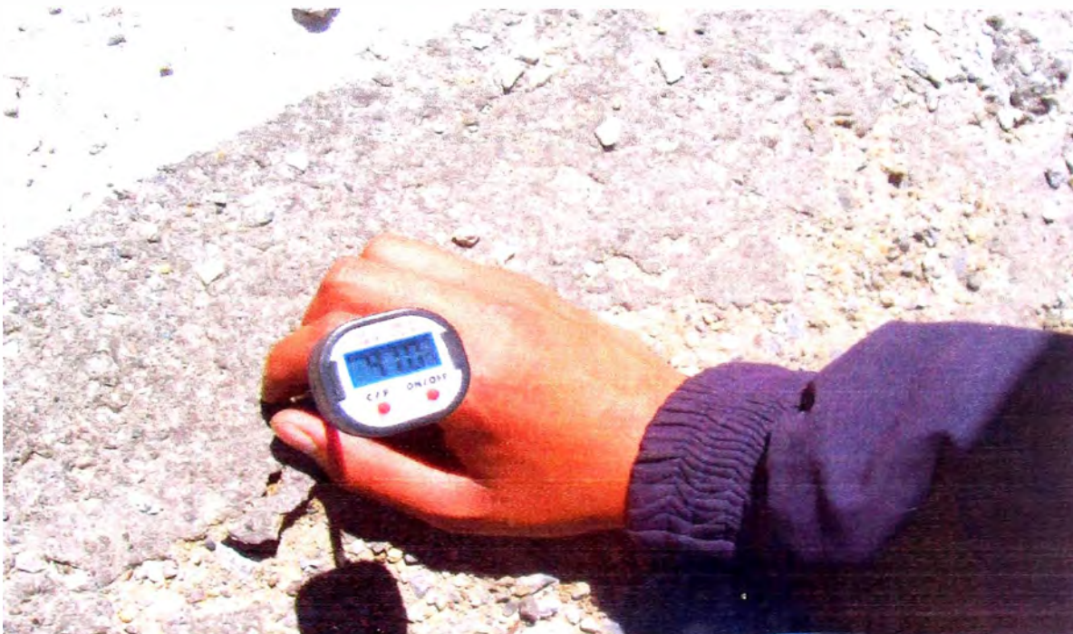
FOTO 4: Medición de temperatura de la carpeta de rodadura en el punto de ensayo, con termómetro digital.
