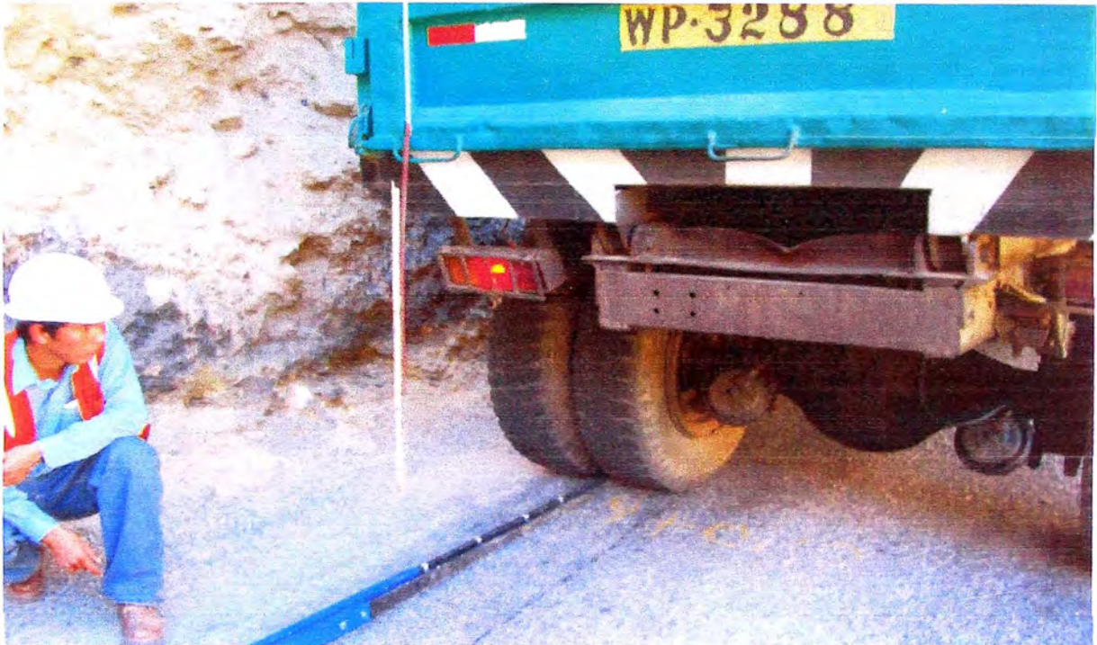
FOTO 1: Viga Benkelman colocado en el punto de ensayo para realizar las mediciones
