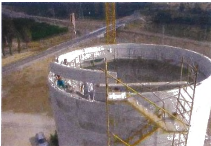
Fotografía N° 1.01 - Silo de concreto para almacenamiento de clinker
