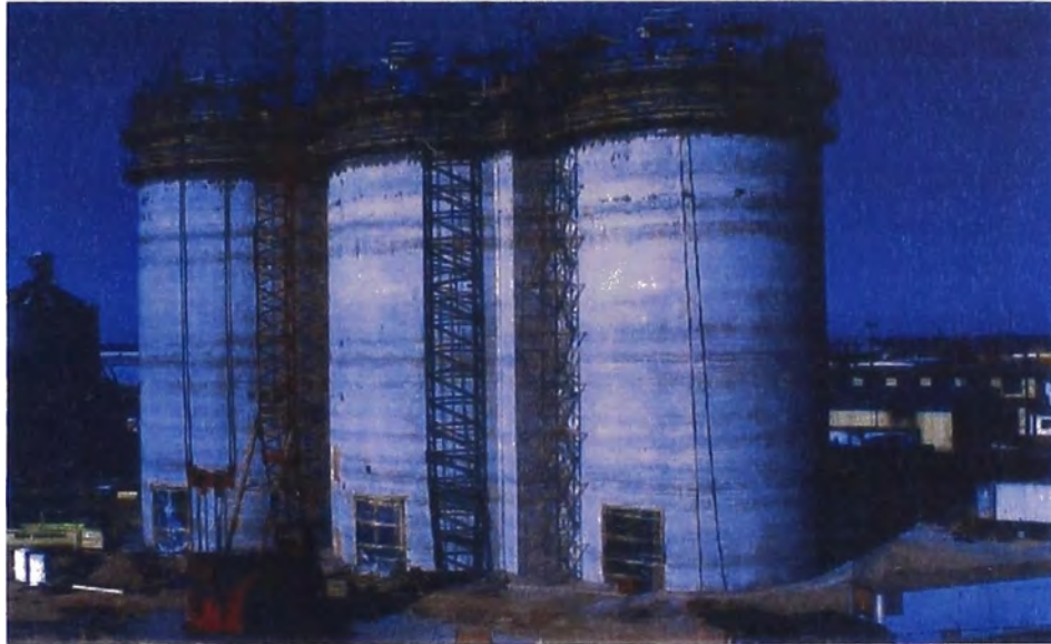
Fotografía N° 1.03 - Silo de concreto reforzado en etapa de construcción
