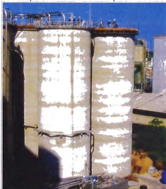
Fotografía N° 1.02 - Grupo de silos de concreto para almacenamiento de granos
