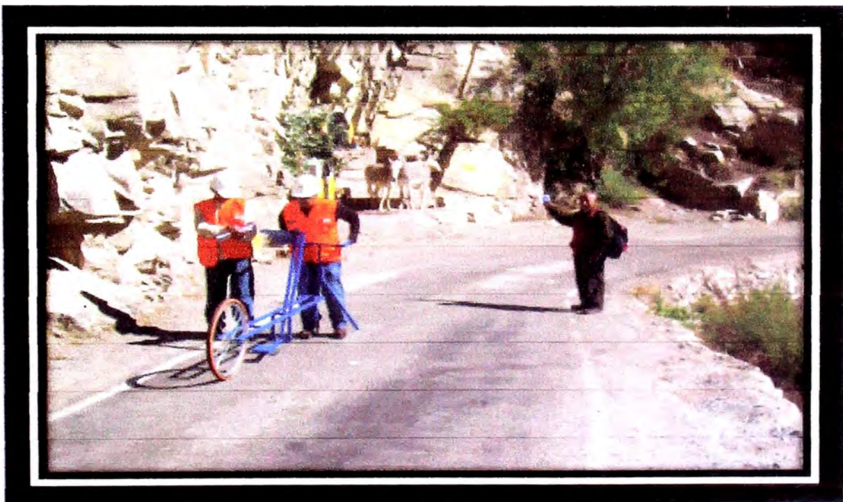
Superficie de rodadura 118+000 al 120+000
