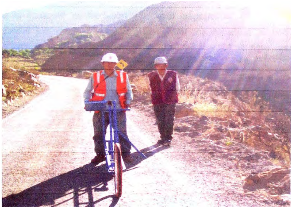
Figura N° 2.3: Lectura y recolección de datos con equipo Merlín durante la evaluación funcional en la carretera Cañete – Yauyos – Chupaca – Huancayo
