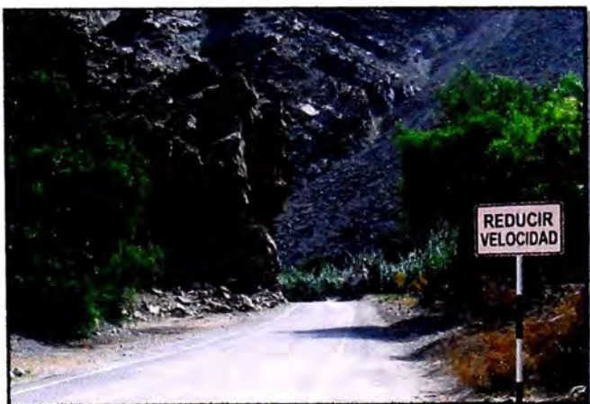
Fotografía N° 1.03: Falta de visibilidad en las curvas horizontales.
