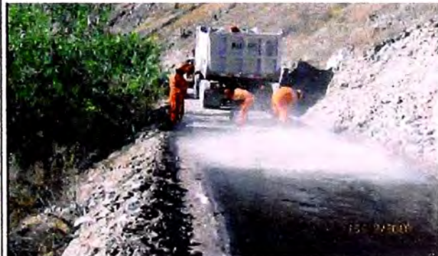
Fotografía N° 1.9: Colocación del tratamiento superficial monocapa con esparcidora.
