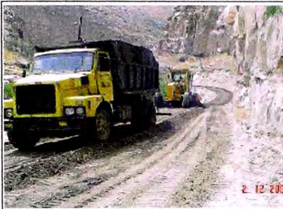
Fotografía N° 1.05: Conformación de afirmado estabilizado con riego de emulsión.
