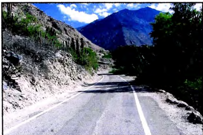
Fotografía N° 1.01: Topografía de la vía en media ladera.
