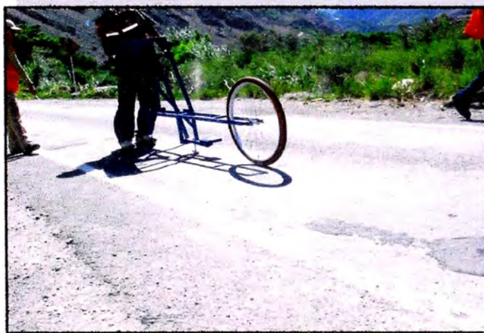
Fotografía N° 4.02: El ensayo no destructivo con el equipo MERLIN se realizó aproximadamente a 1 m. del borde de la calzada.
