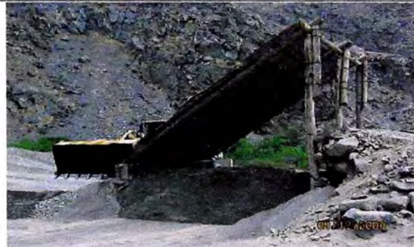
Fotografía N° 1.07: Producción de gravilla de 3/8" para monocapa.
