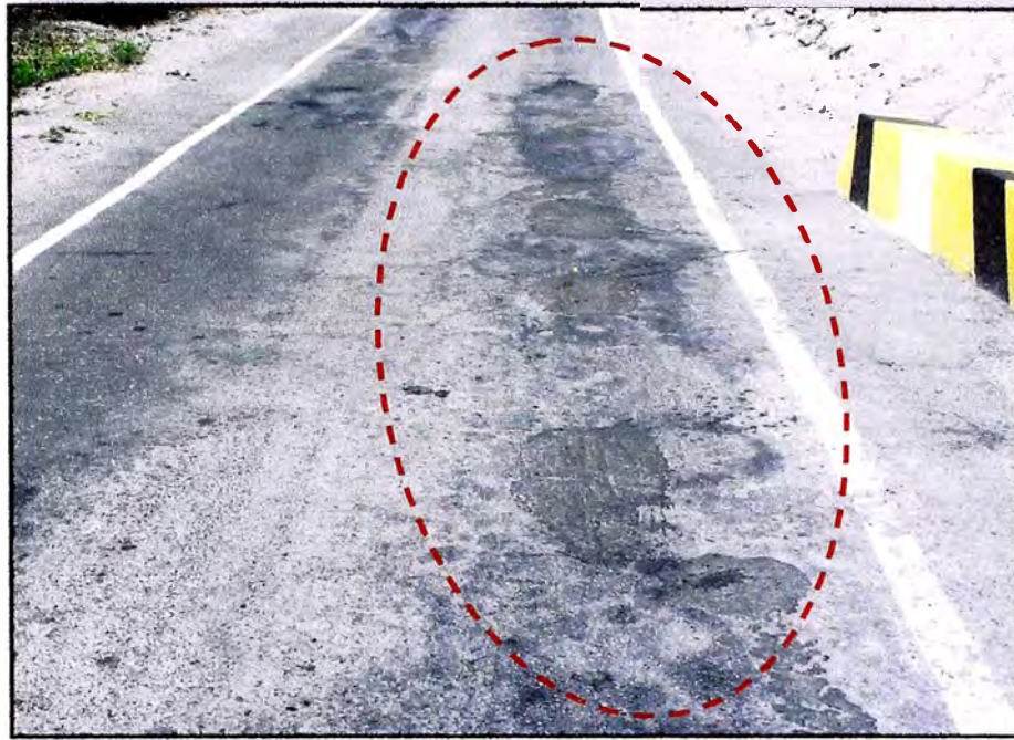
Fotografía N° 5.04: Mantenimiento Rutinario: parchados con Slurry Seal.
