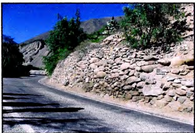
Fotografía N° 1.02: Pendiente de suave a moderada.
