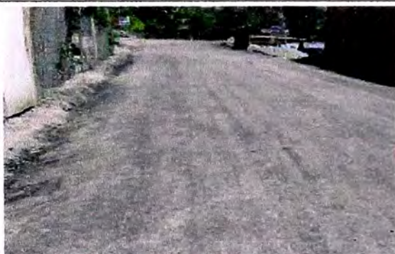
Fotografía N° 1.06: Superficie de Plataforma luego de ser compactada.
