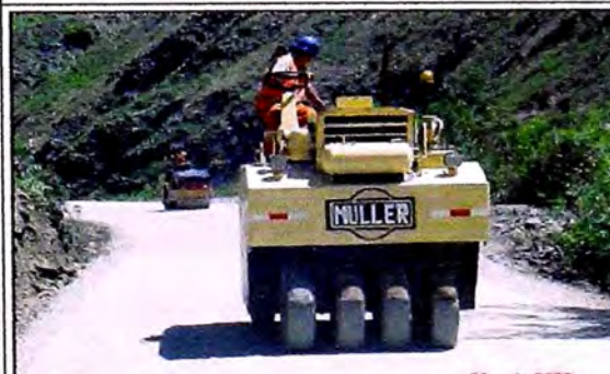
Fotografía N° 1.10: Compactado del monocapa con rodillo de neumáticos.
