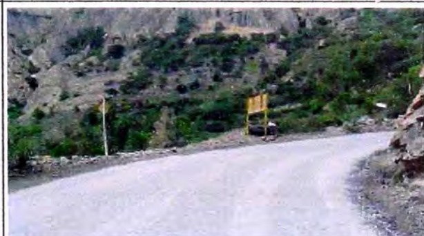
Fotografía N° 1.11: Tramo con monocapa terminado.
