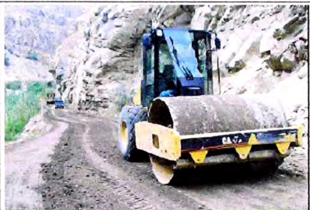
Fotografía N° 1.05: Conformación de afirmado estabilizado con riego de emulsión.
