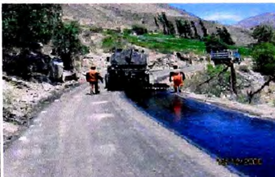
Fotografía N° 1.08: Aplicación de RC-250 para riego de liga para el monocapa.
