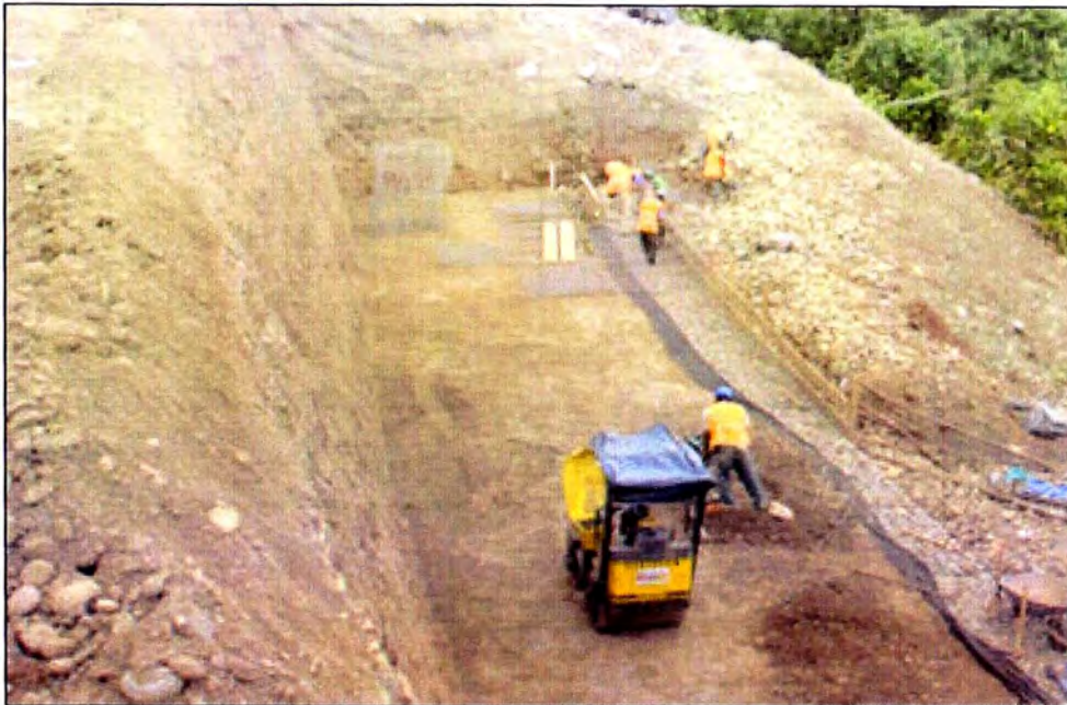
Grafico 10.12.- Proceso constructivo de armado de Suelo reforzado
