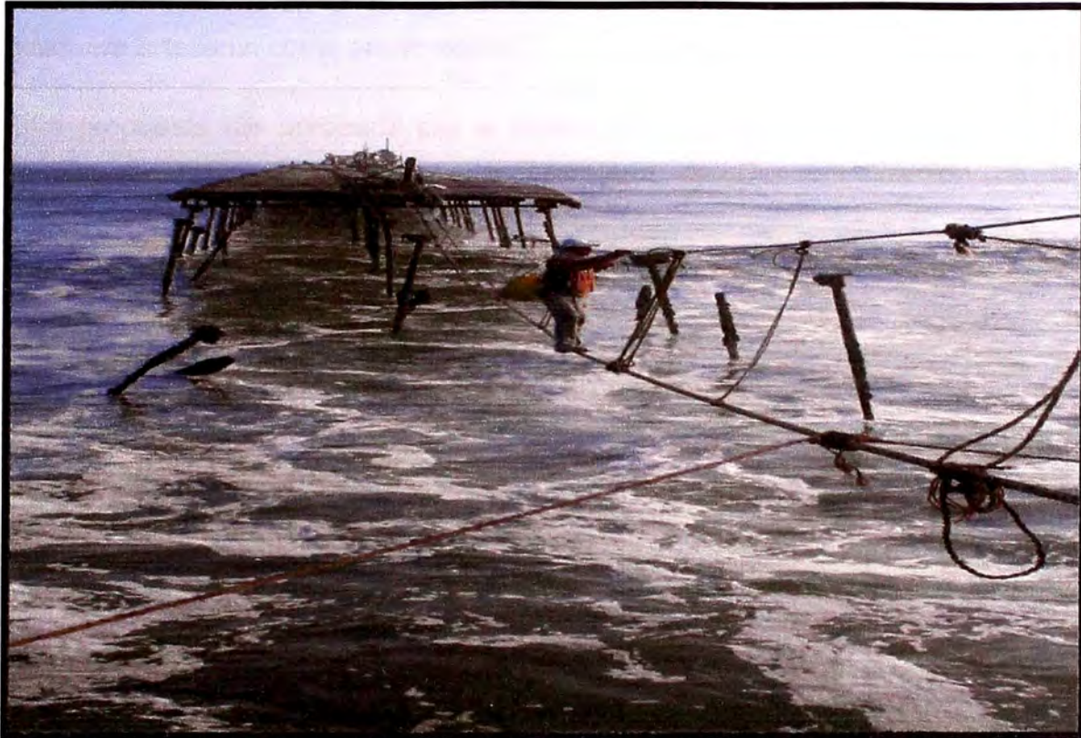
Figura 1.1: Situación Actual del Muelle de Eten.
