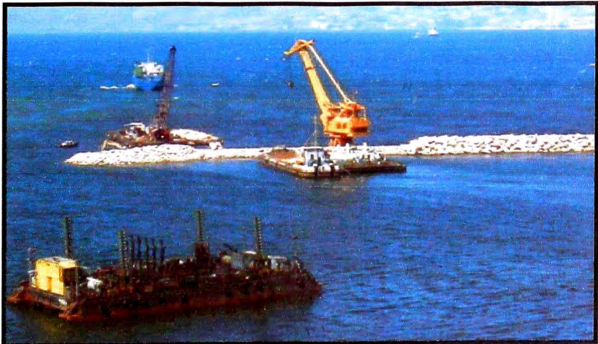
Figura 3.8: Colocación de roca en coronación utilizando grúas.
