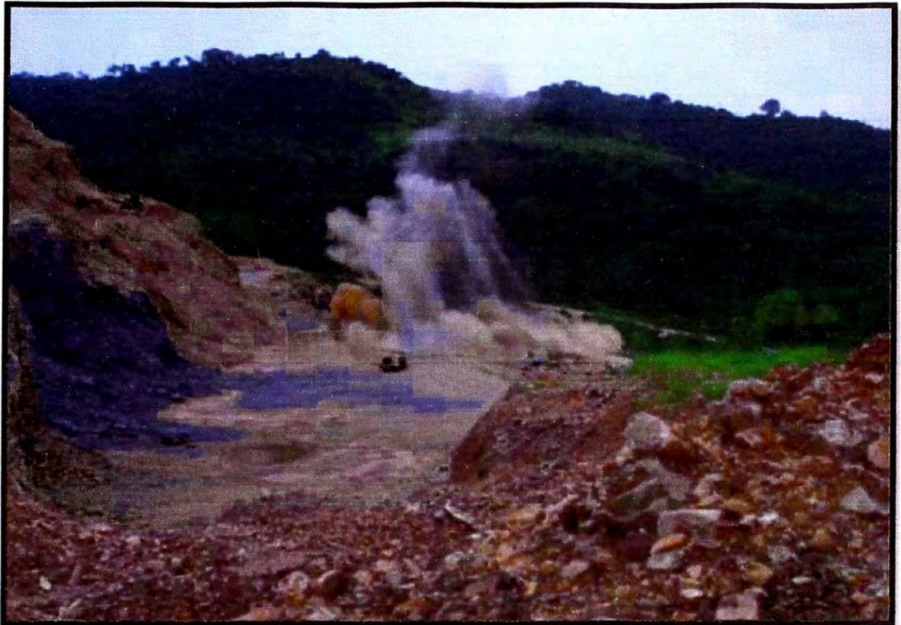
Figura 3.5: Vista de voladura en roca.
