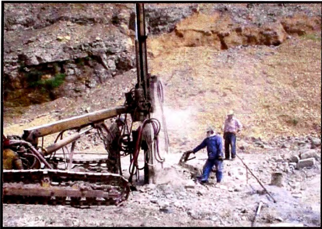
Figura 3.4: Colocación de explosivos en cantera.
