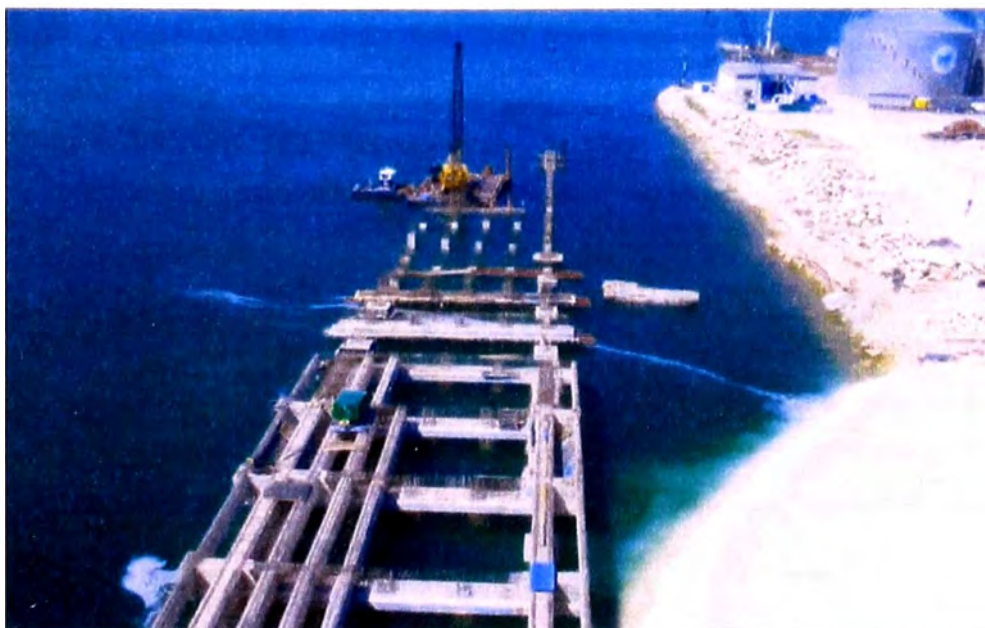
Figura 2.4 Hincado desde Tierra
