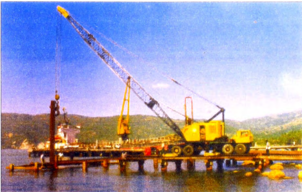
Figura 2.7 Hincado de Pilotes
